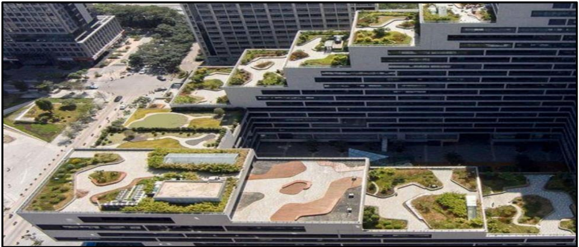
Şekil 2.3. Yeşil çatı uygulaması (Pouya, 2019).
