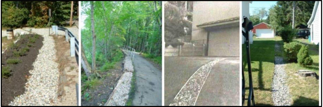
Şekil 2.6. İnfiltrasyon hendeği örnekleri (Konyalı Dereli ve Çay, 2020).
