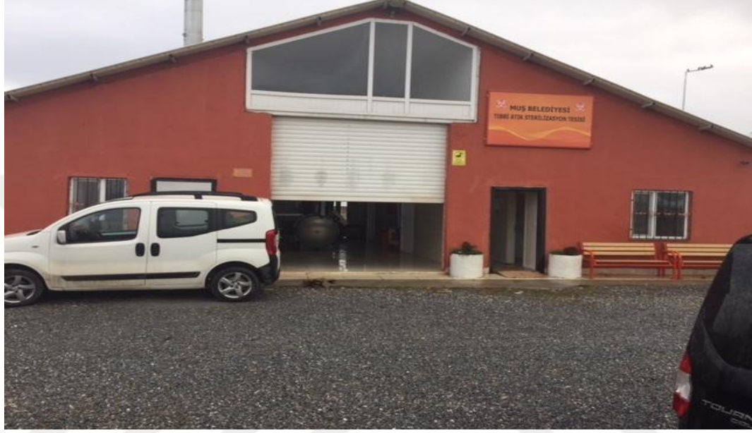
Şekil 3.11. Muş ili tıbbi atık bertaraf tesisi dıştan görünüm
