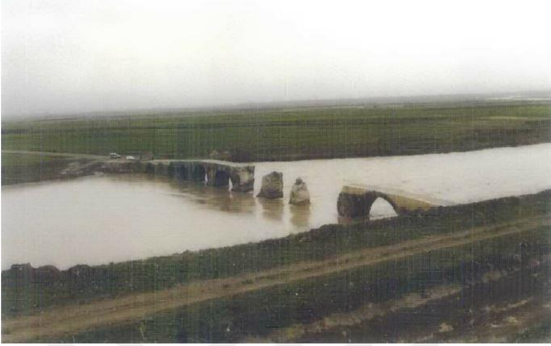
Şekil 2.3. Murat köprüsü Yıkılan Kemerler Memba Görünüşü
