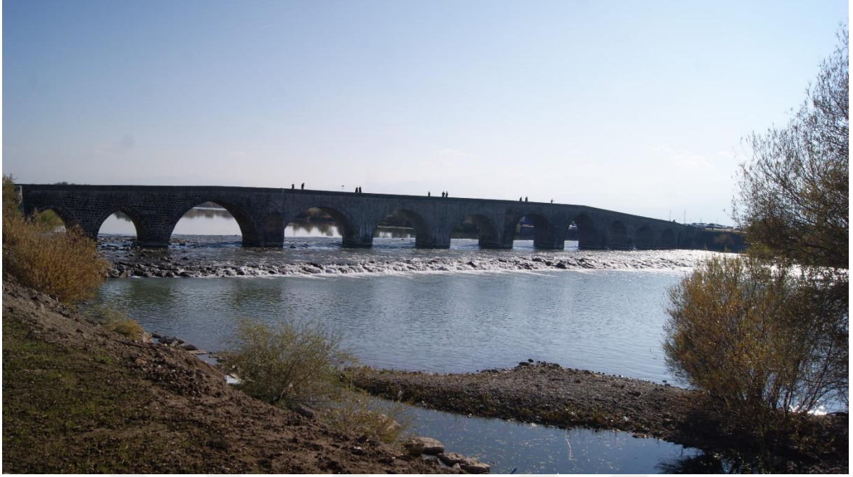
Şekil 2.5. Murat Köprüsü Mansap Görünüşü
