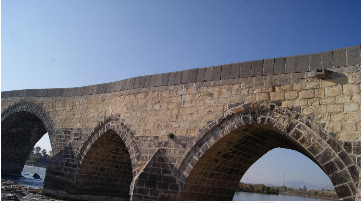
Şekil 2.13. Murat Köprüsü Tempan Duvarında Kullanılan Farklı Taşlar
