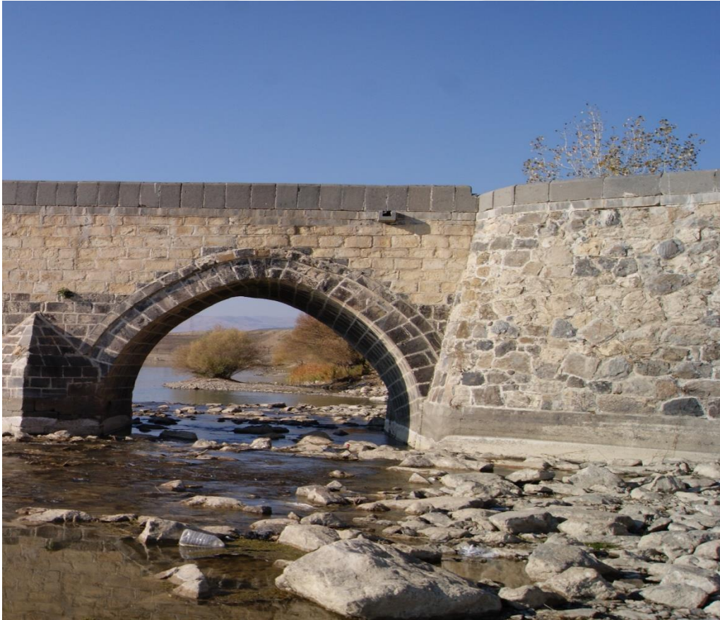
Şekil 2.14. Nehir Kıyısı Birleşim Ayağında Kullanılan Moloz Taşları
