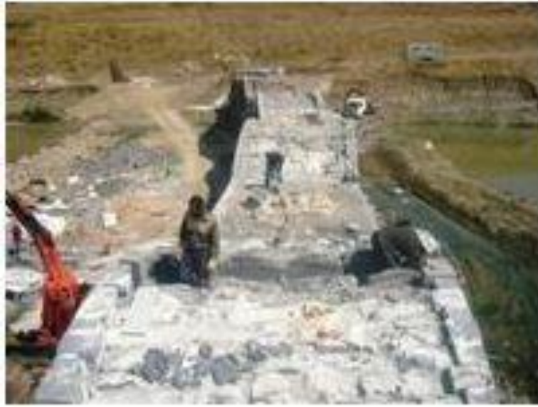
Şekil 2.4. Murat Köprüsü Onarım Çalışmaları Kaynak: (Evrensel, 2004)
