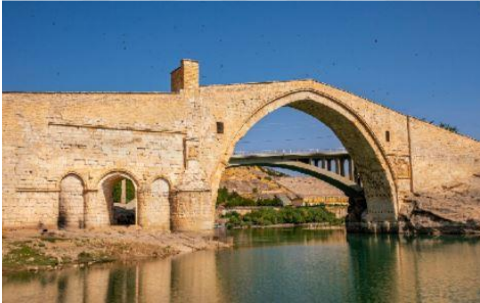
Şekil 1.14. Malabadi Köprüsü Silvan/Diyarbakır
