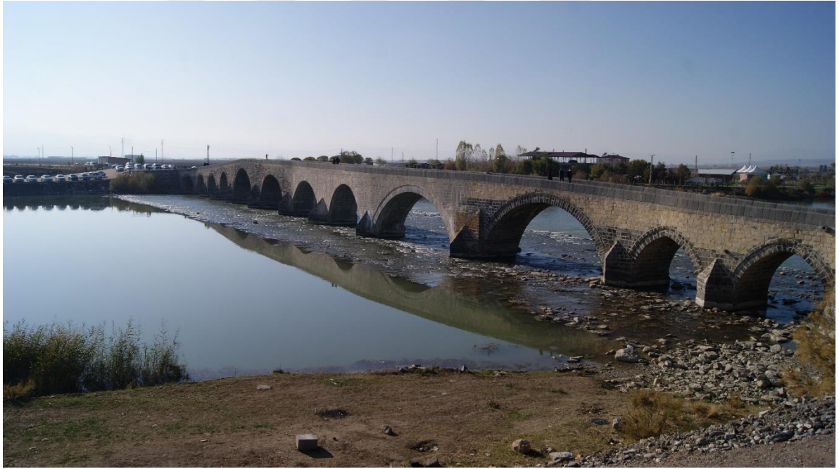
Şekil 2.6. Murat Köprüsü Memba Görünüşü
