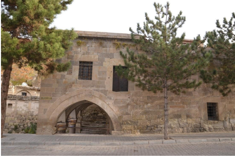
Şekil 5.16. Güney cephe narteks/galeri kısmı
