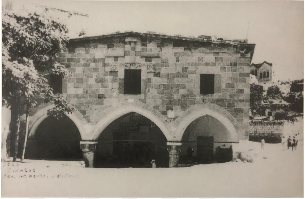
Şekil 6.7. 1959 Yılına ait batı cephesinden fotoğraf (Balta 2005, s. 70).
