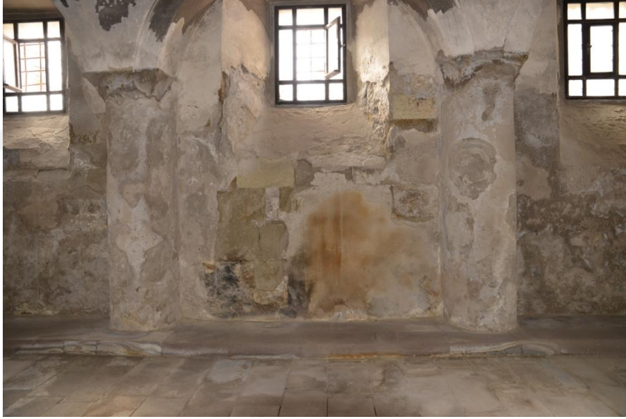
Şekil 6.22. Restorasyon çalışması yenilenen ahşap pencere doğramaları
