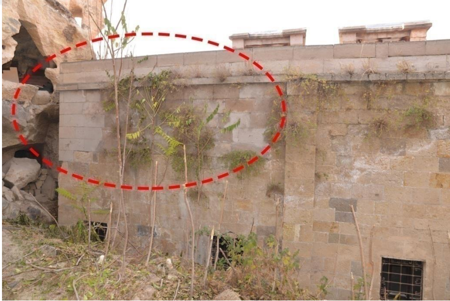
Şekil 6.24. Kuzey cephenin doğusundaki taşlarda yenileme
