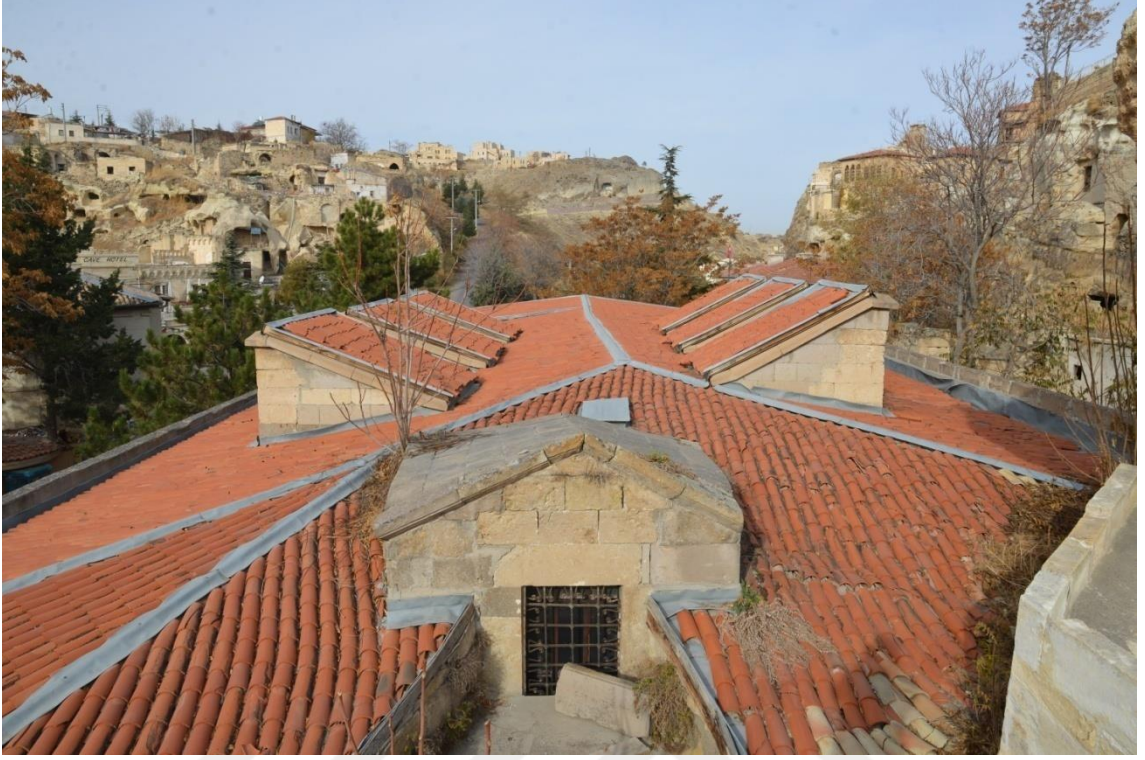
Şekil 6.25. Çatının yenilenerek alaturka kiremit örtüye dönüştürülmesi
