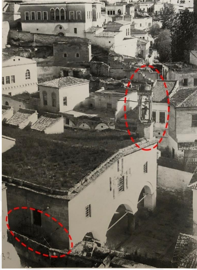
Şekil 5.20. Yıkılan çan kulesi ve merdiven
