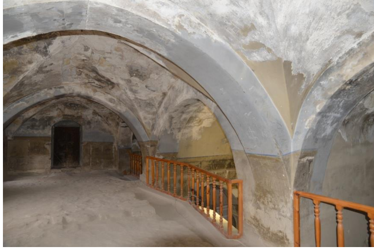
Şekil 6.21. Restorasyon çalışması ile galeri kısmındaki ahşap korkuluklar
