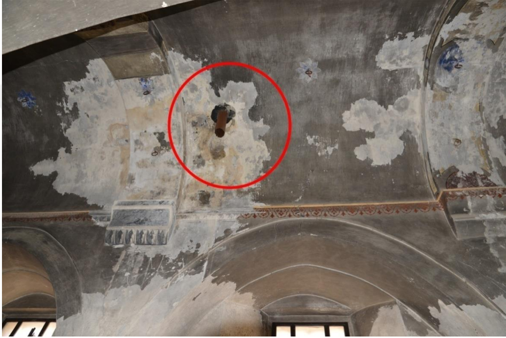
Şekil 5.21. Baca ve çevresi isten kaynaklı renk değişimi
