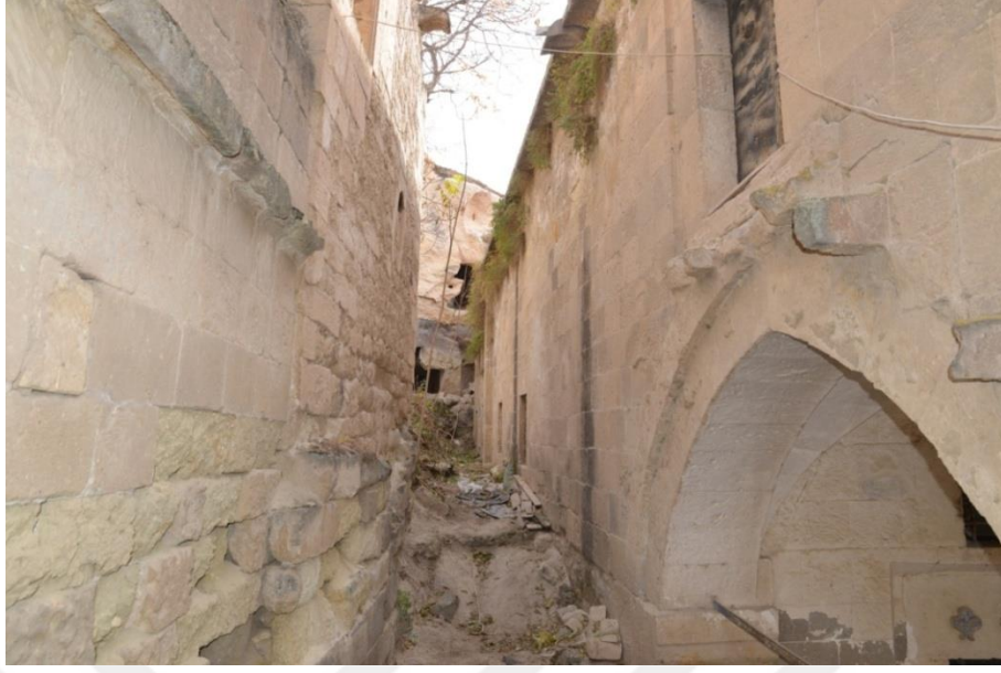
Şekil 6.2. Kuzey cephede galeri kısmına ulaşımı sağlayan merdiven
