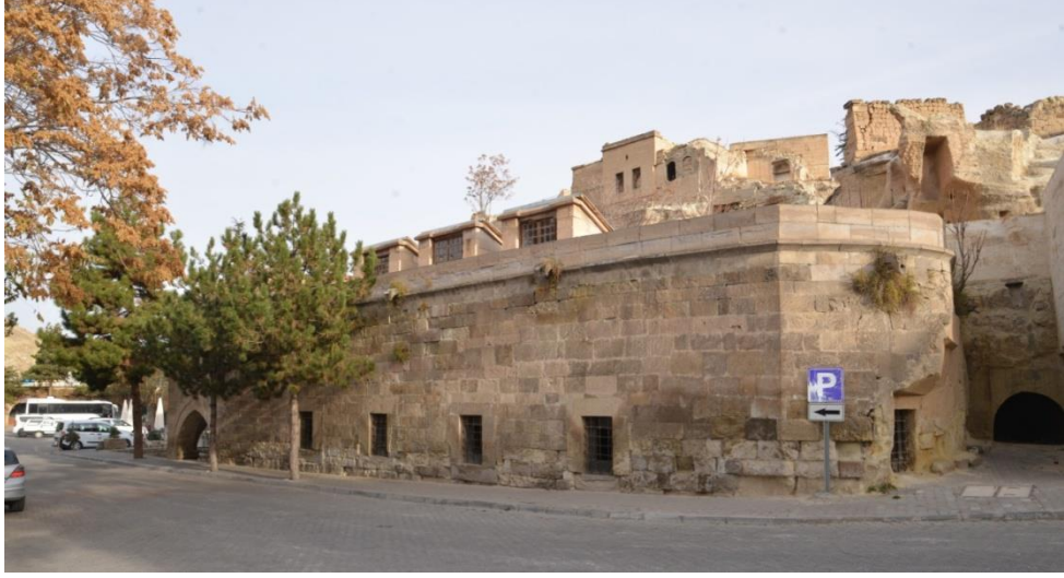
Şekil 5.15. Güneydoğu yönünden güney cephesine bakış
