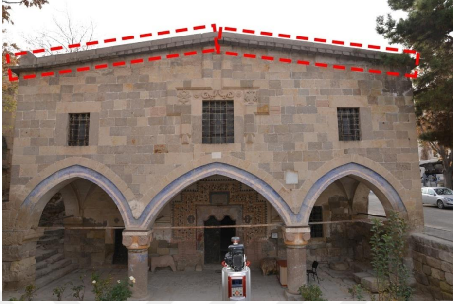
Şekil 6.23. Restorasyon çalışması tüm cephe boyunca yenilenen çatı parapeti
