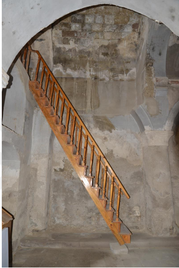
Şekil 6.20. 1988 yılından sonra yapılan restorasyon çalışması (ahşap merdiven)
