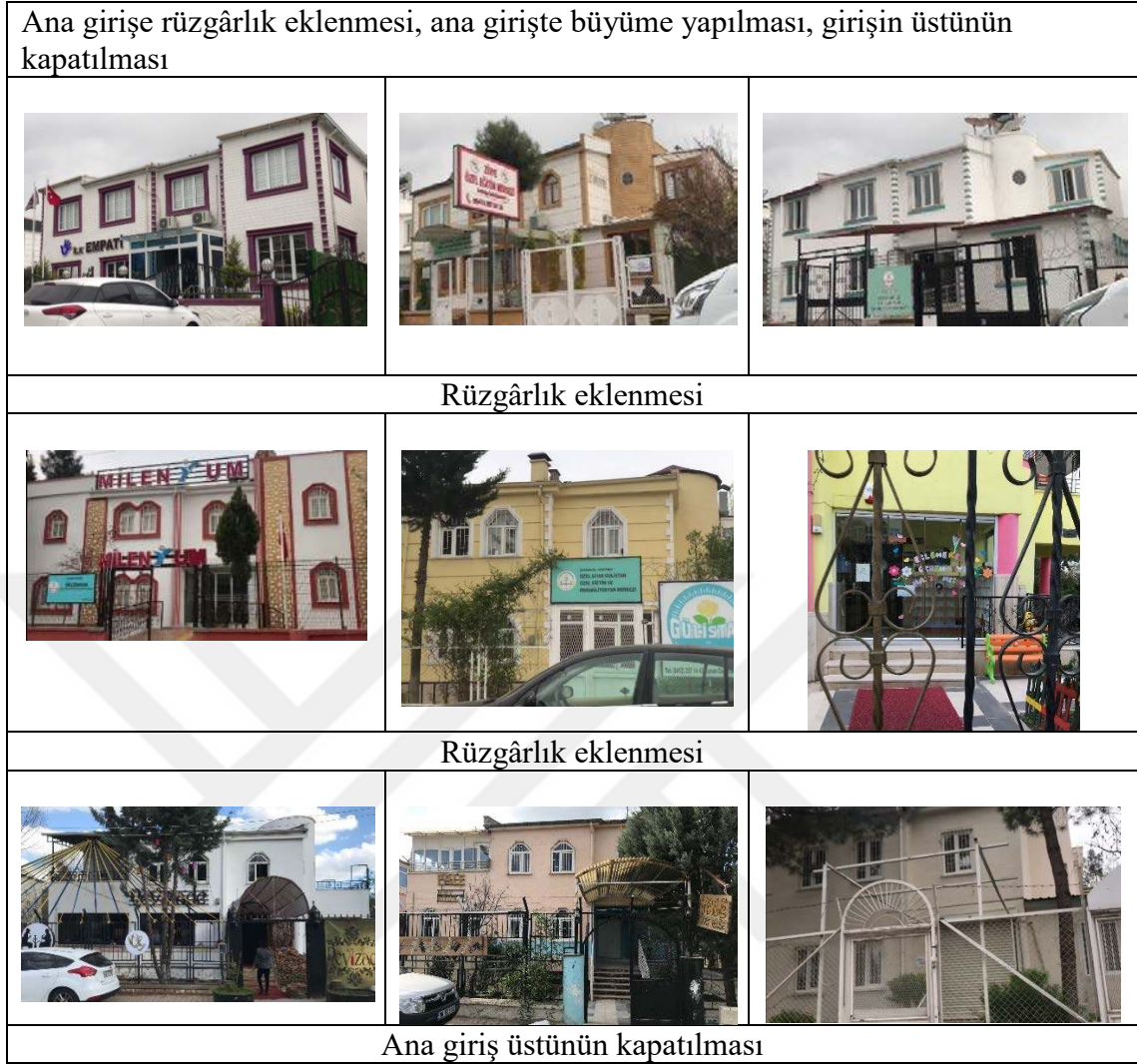
Şekil 4.26. Ana girişe yapılan müdahaleler
