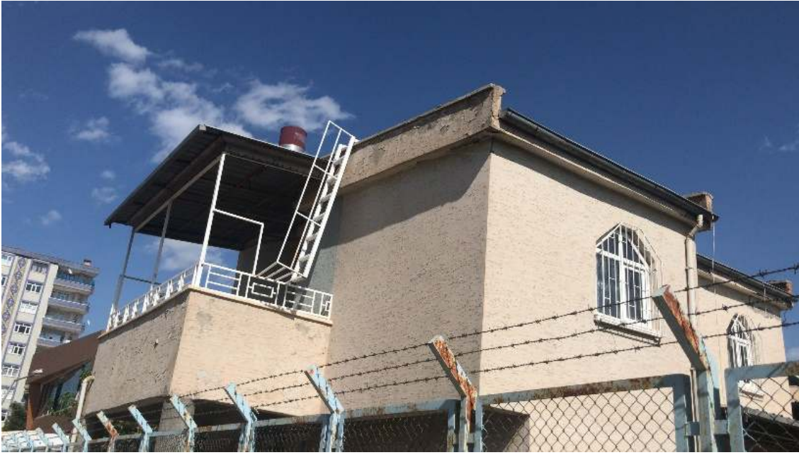
Şekil 4.14. Çatı çıkış merdiveni
