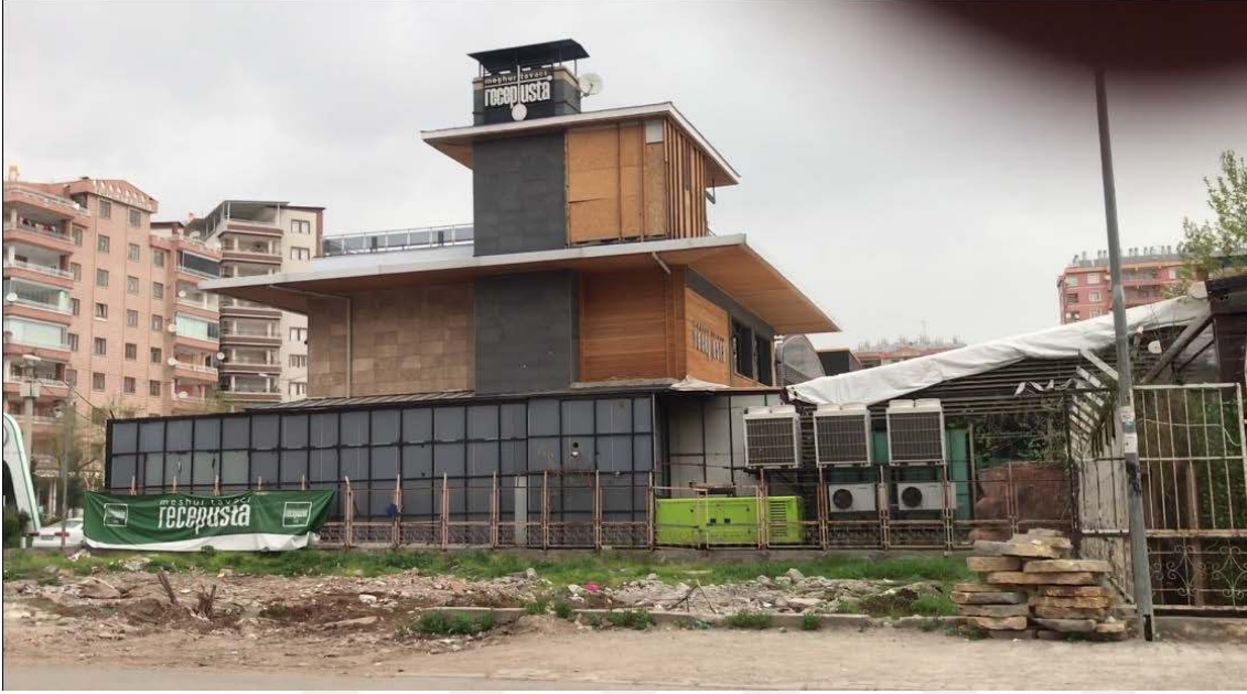
Şekil 4.29. İki parseli birleřtirerek yeniden yapılan yapı
