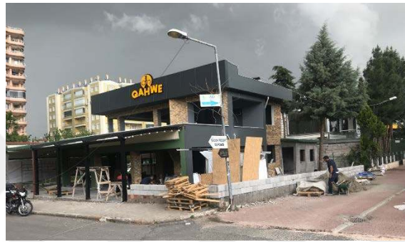
Şekil 4.35. Tadilat süresince konutun cephesel değişimi
