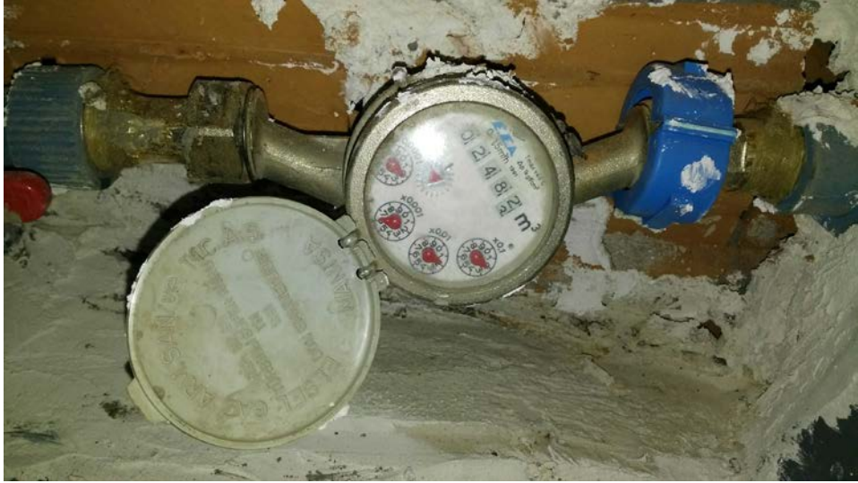
Şekil 3.2.b Arızalı Sayaç Örneği (MASKİ,2016)
