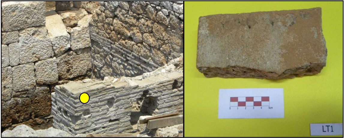
Şekil 3.41. LT1 kodlu tuğla duvar numunesi
