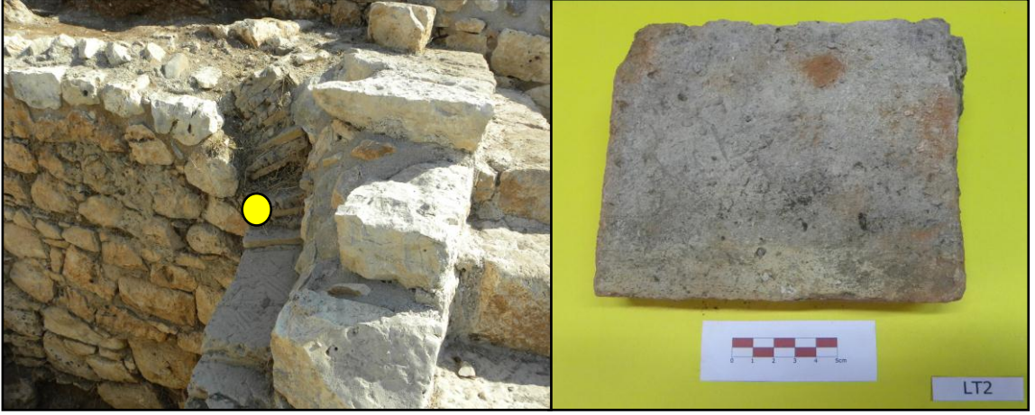
Şekil 3.43. LT2 kodlu tuğla duvar numunesi
