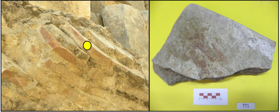
Şekil 3.82. TT1 kodlu tuğla kemer numunesi
