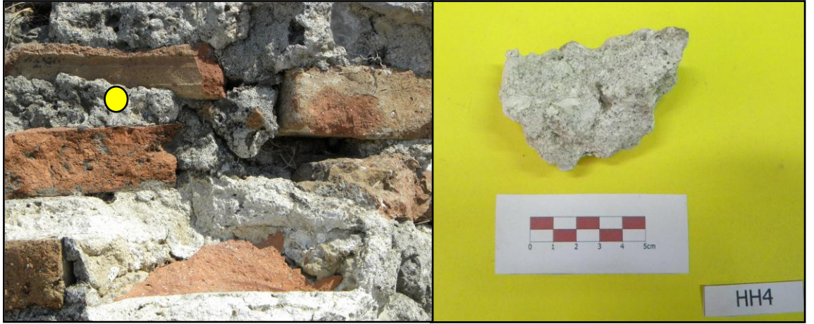
Şekil 3.72. HH4 kodlu tuğla duvar harcı numunesi
