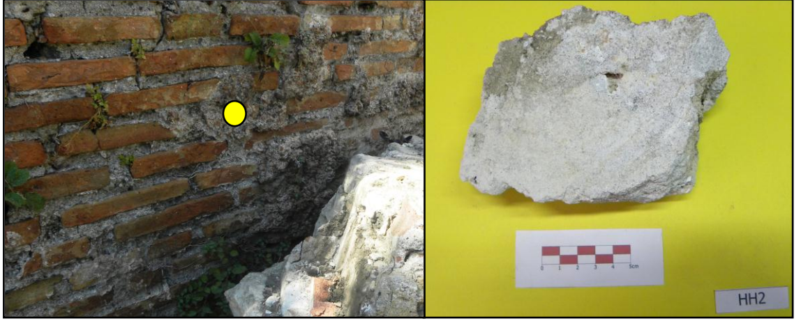
Şekil 3.68. HH2 kodlu tuğla duvar harcı numunesi
