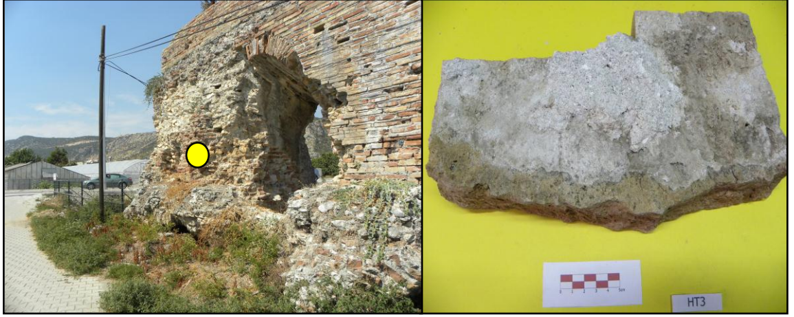
Şekil 3.71. HT3 kodlu tuğla duvar numunesi
