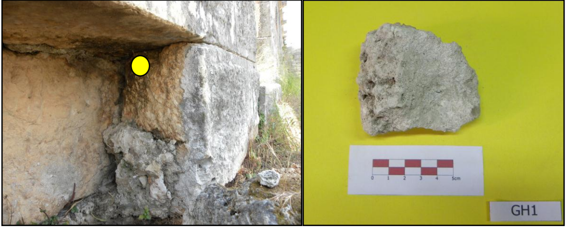
Şekil 3.19. GH1 kodlu taş duvar örgü harcı numunesi
