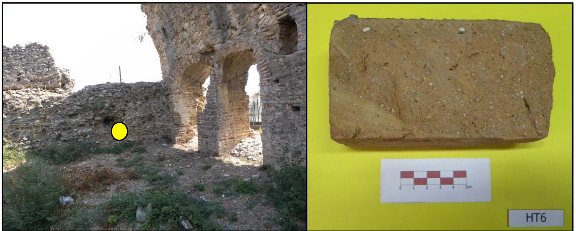
Şekil 3.76. HT6 kodlu tuğla duvar numunesi
