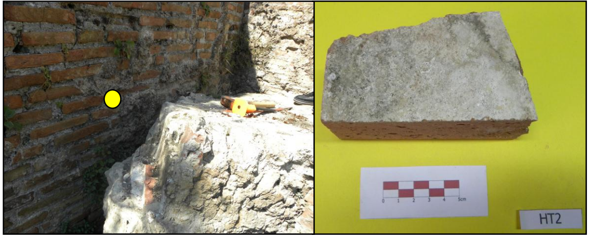
Şekil 3.69. HT2 kodlu tuğla duvar numunesi
