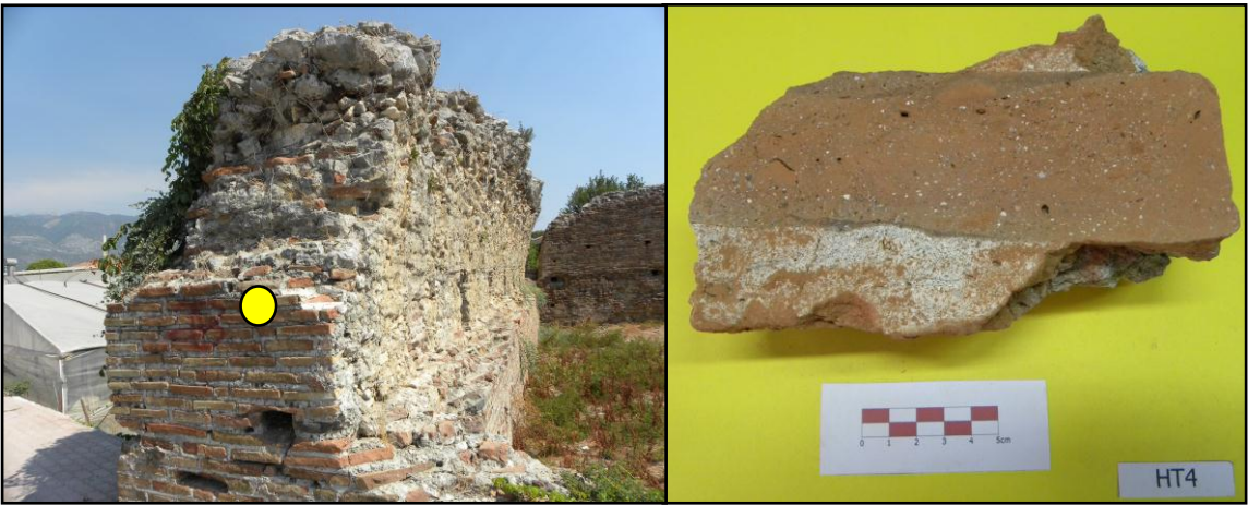
Şekil 3.73. HT4 kodlu tuğla duvar numunesi
