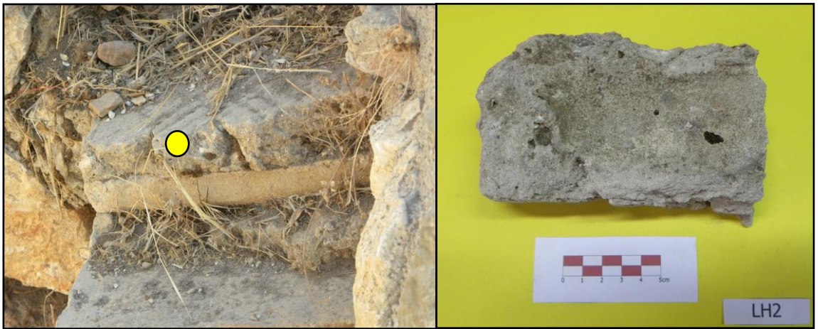
Şekil 3.42. LH2 kodlu tuğla duvar harcı numunesi
