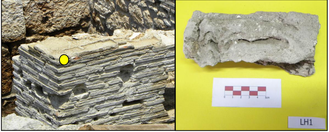
Şekil 3.40. LH1 kodlu tuğla duvar harcı numunesi
