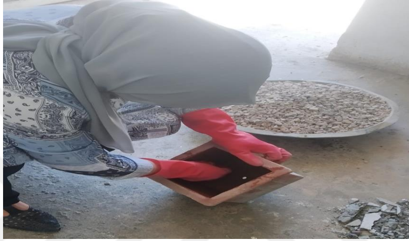
Şekil 4.5 Kalıpların temizlenmesi ve yağ ile yağlanması
