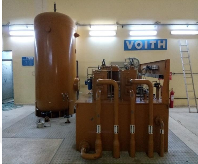
Şekil 10: Karkamış HES Hız Regülatörü
