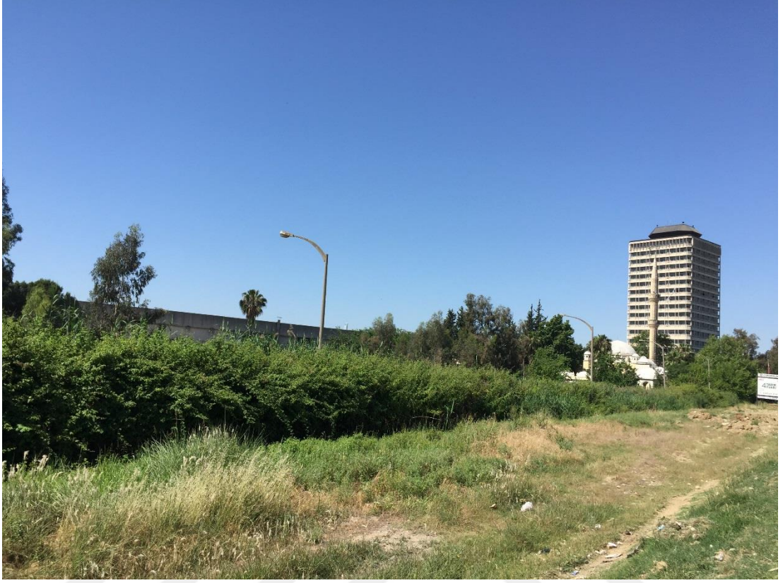
Fotoğraf III. E-5 üzerinde kapanan atıl durumdaki Çukobirlik fabrikası.
