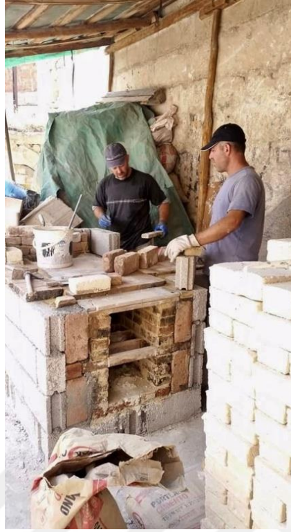
Görsel 2.54. Levent, Mehmet Düzgün ve Odun Yakutlu Fırın İnşası (Mehmet Düzgün Kişisel Arşiv)
