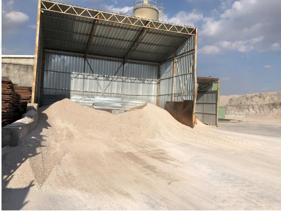
Şekil 3.22. Ham madde bunkerı önü koruyucu setin olmadığı yanlış uygulama örneği.
