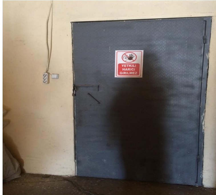
Şekil 3.19. Kompresör odası girişinde uyarı levhası.
