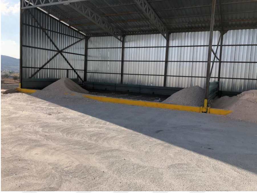
Şekil 3.21. Ham madde bunkerı önü koruyucu setin bulunduğu doğru uygulama örneği.
