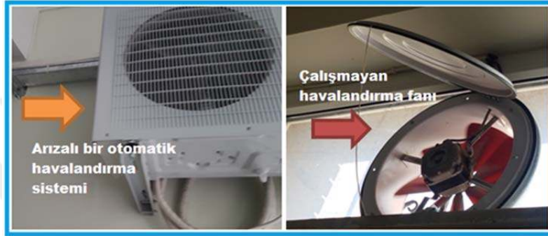
Şekil 6.11. Arızalı otomatik ve manuel havalandırma sistemleri
