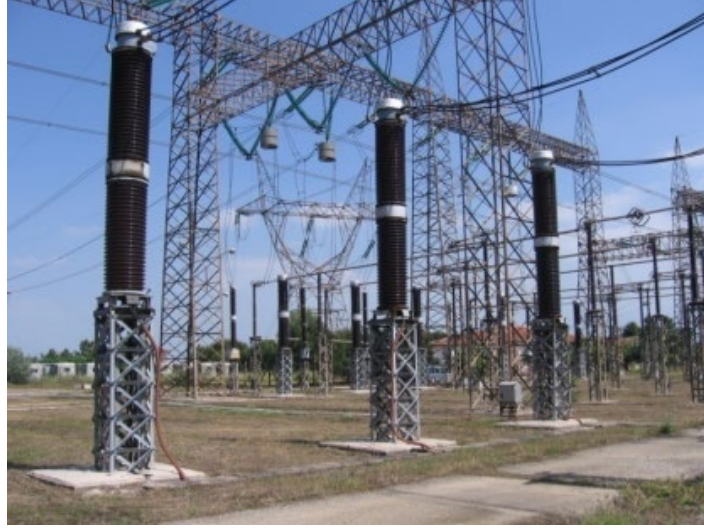
Şekil 2.16. 380 kV gerilim seviyesinde kullanılan akım trafoları [32]
