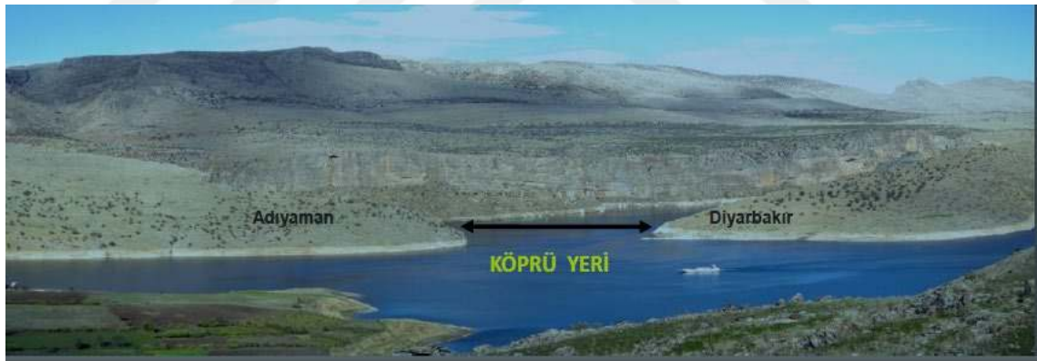
Şekil 4.14 Köprünün İmal Edildiği Yer
