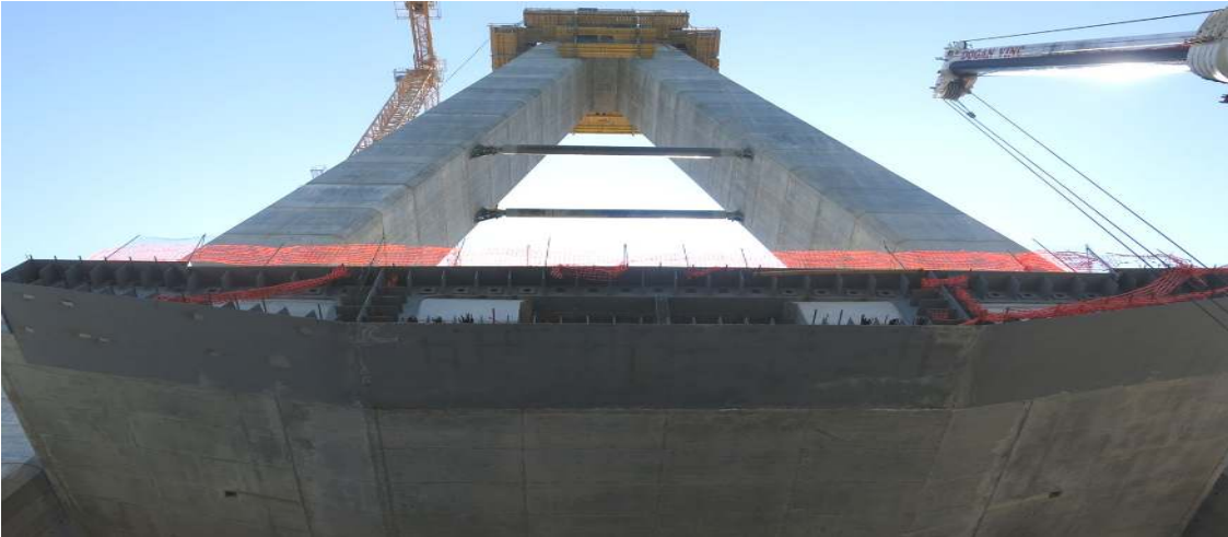
Şekil 4.51. İlk Çelik Segmentin İmalatının Tamamlanması
