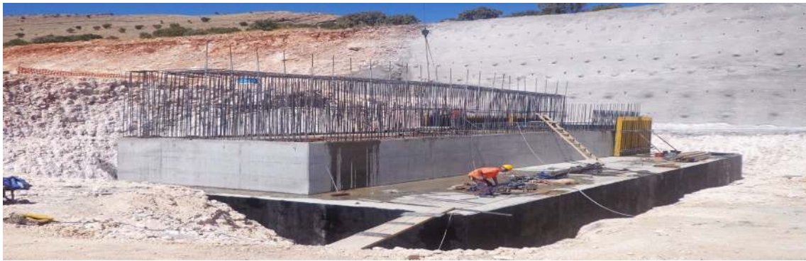
Şekil 4.24. Kenar Açıklık Kenar Ayak Temel İmalatı
