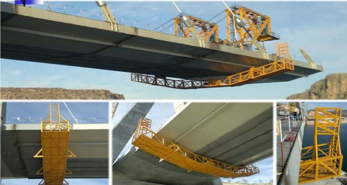
Şekil 4.61. Üstyapıda Bir Önceki Çelik Segment ile Kaynak İşleminin Yapılması
