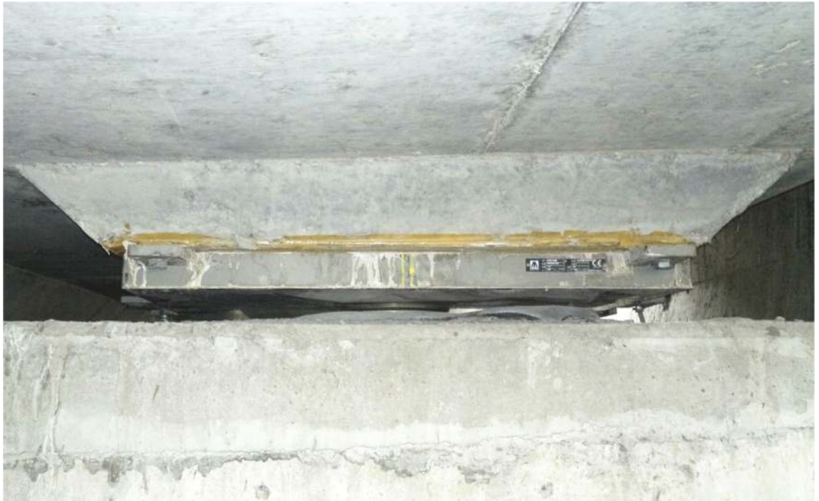
Şekil 4.29. Kenar ayaktaki Pot Mesnetin Yerleştirilmesi
