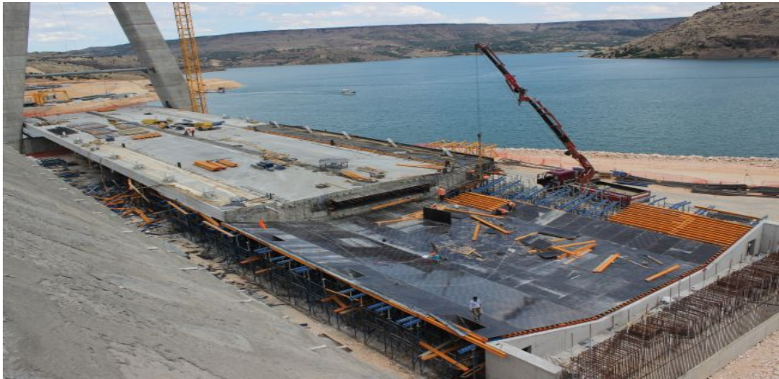
Şekil 4.34. Kenar Açıklık 2. Faz İmalata Başlanması
