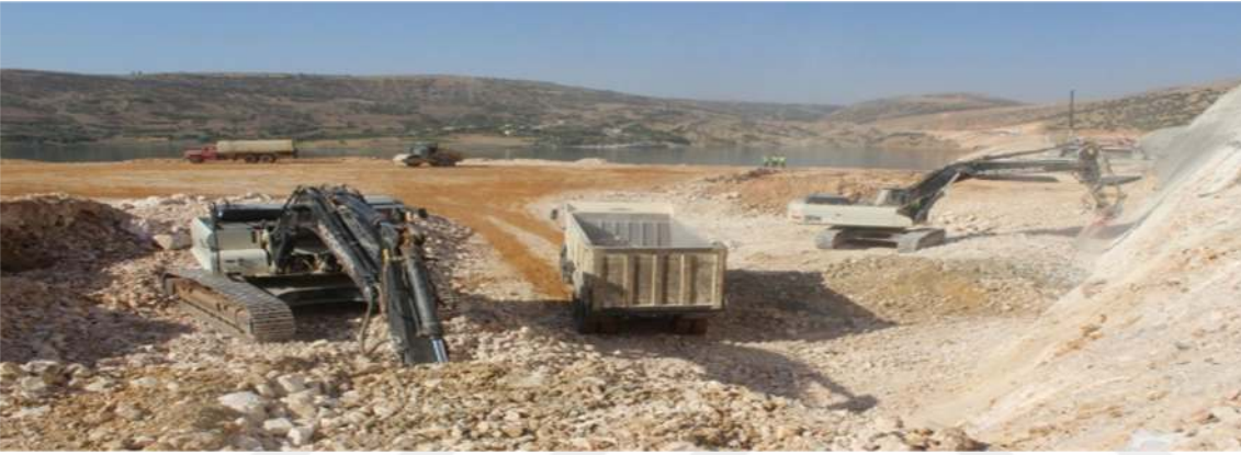
Şekil 4.17 Arazinin temel imalatına hazır hale getirilmesi
