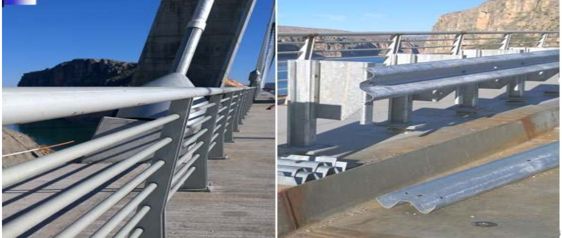
Şekil 4.72. Otokorkuluk İmalatının Yapılması
