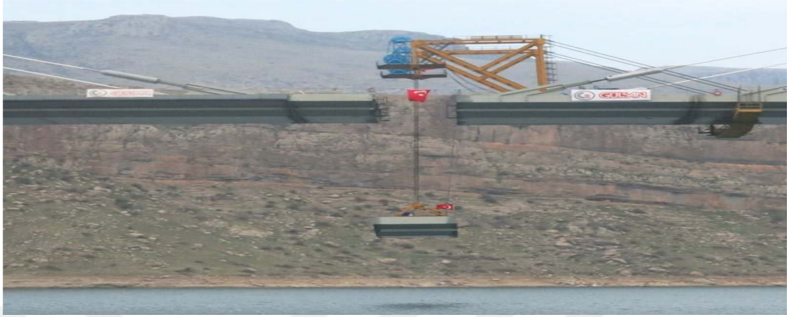
Şekil 4.67. Anahtar Segmentin Yerleştirilmesi
