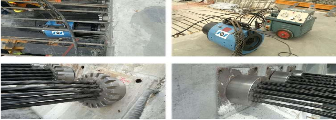
Şekil 4.36. Germe İşleminin Yapılması
