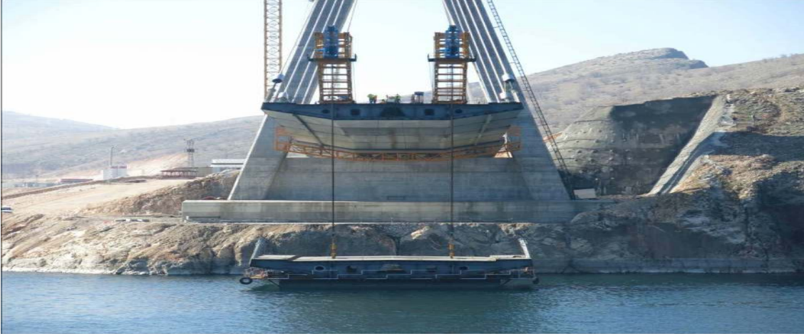
Şekil 4.59. Ağır Kaldırma Yöntemiyle Segmentin Kaldırılması
