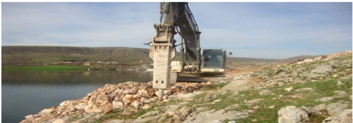
Şekil 4.15 Patlayıcı madde için çukur açılması
