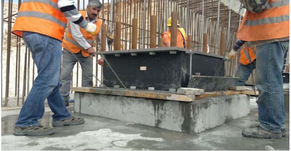
Şekil 4.28. Mesnetin Yerleştirilmesi
