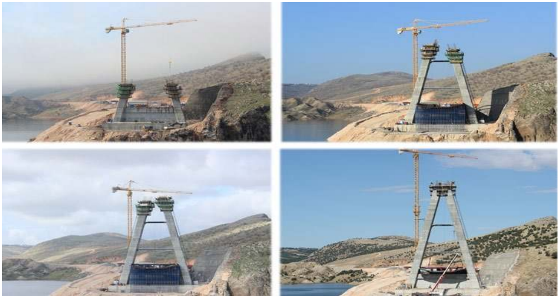
Şekil 4.38. Pilon İmalatının Eğimli Ayaklarının İmalat Aşamaları
