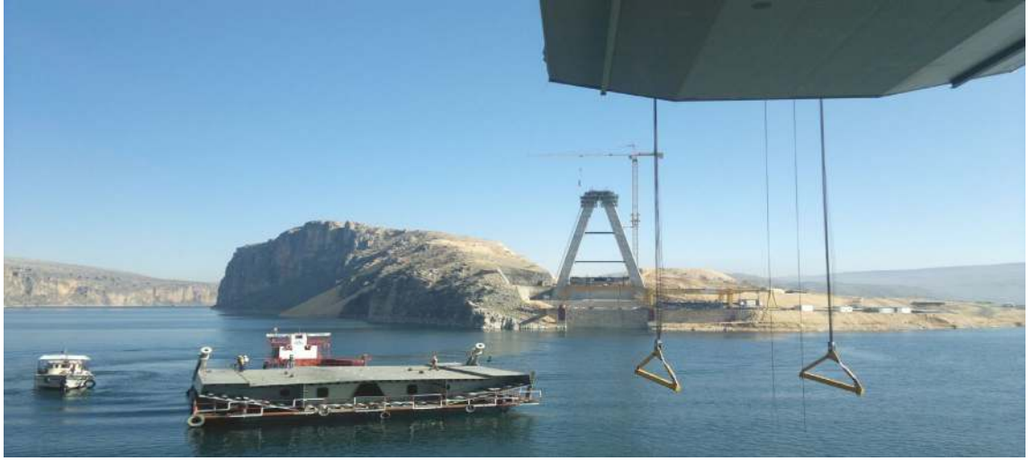
Şekil 4.57. Çelik Segmentin Feribotla Taşınması
