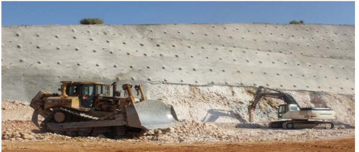
Şekil 4.21. Şev Destekleme Sistem İmalatının Tamamlanması
