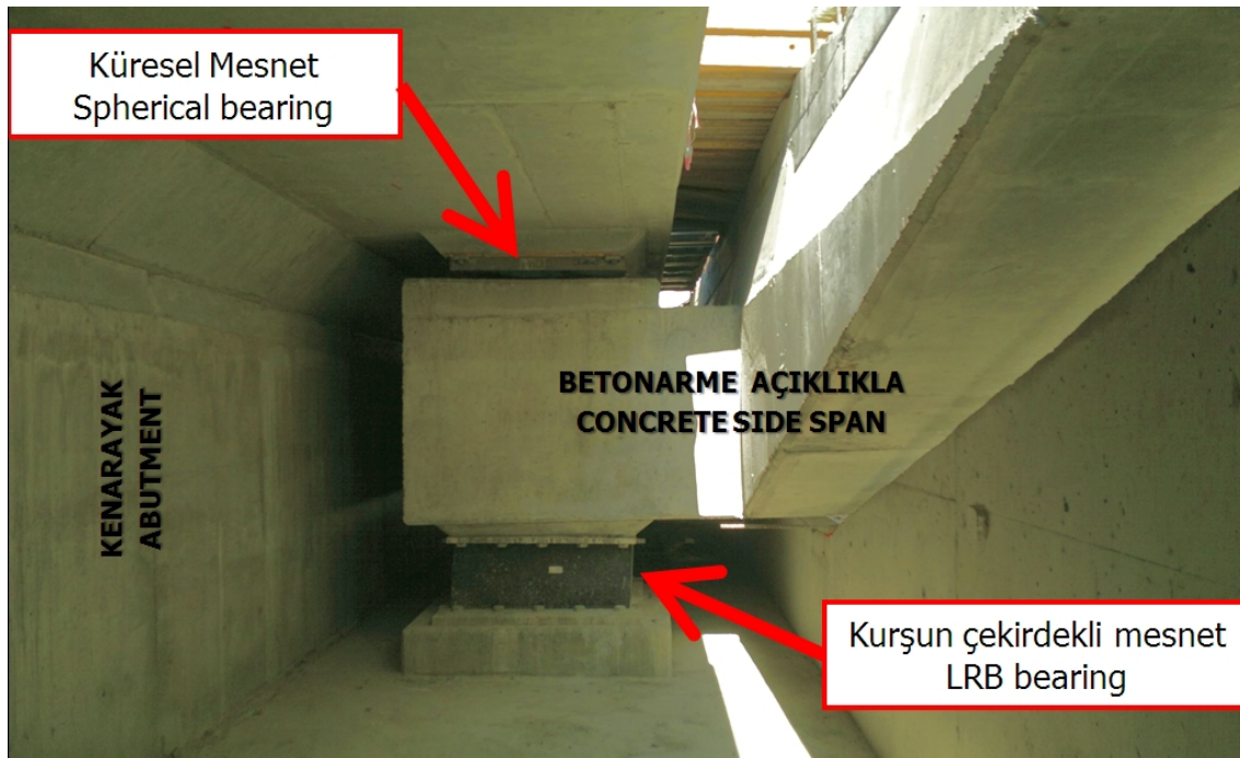
Şekil 4.27. Kenar ayak Temelinin Mesnet Bandı Kotuna Kadar İmalatının Tamamlanması
