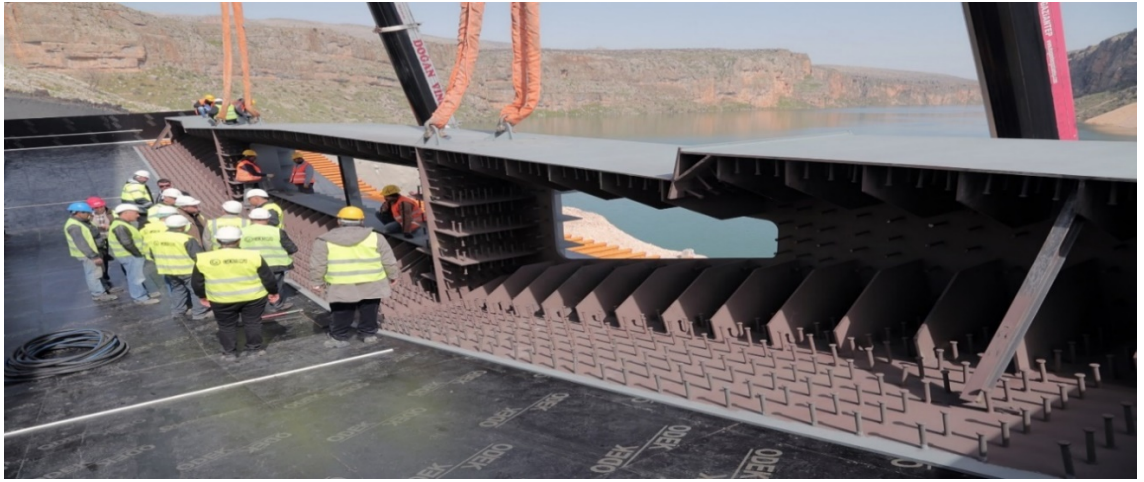
Şekil 4.47. İlk Çelik Segmentin Montajı
