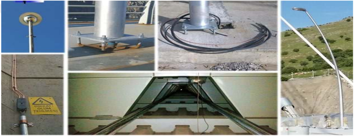
Şekil 4.73. Aydınlatma İşlerinin Yapılması
