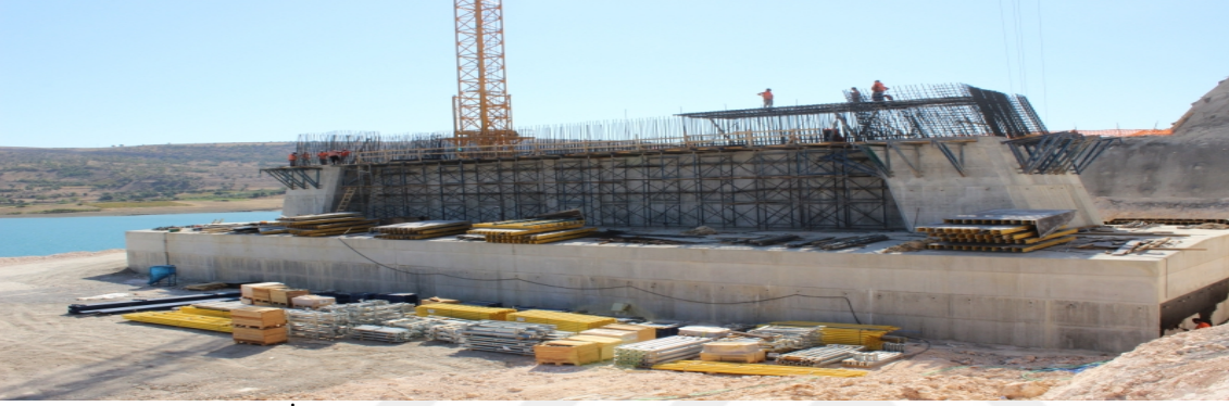
Şekil 4.22. Pilon Temel İmalatı
