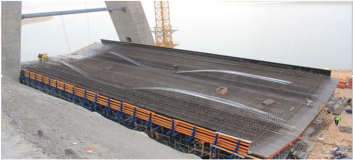
Şekil 4.33. Kenar Açıklık Ard germe Kablolarının Yerleştirilmesi
