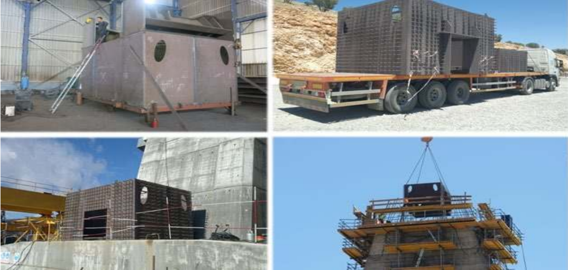
Şekil 4.40. Pilonlarda Kullanılan Çelik Kutunun İmalatı ve Pilonla Taşınması
