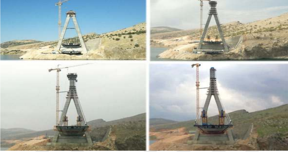
Şekil 4.39. Pilon İmalatının Dik Yükselen Ayak İmalatı
