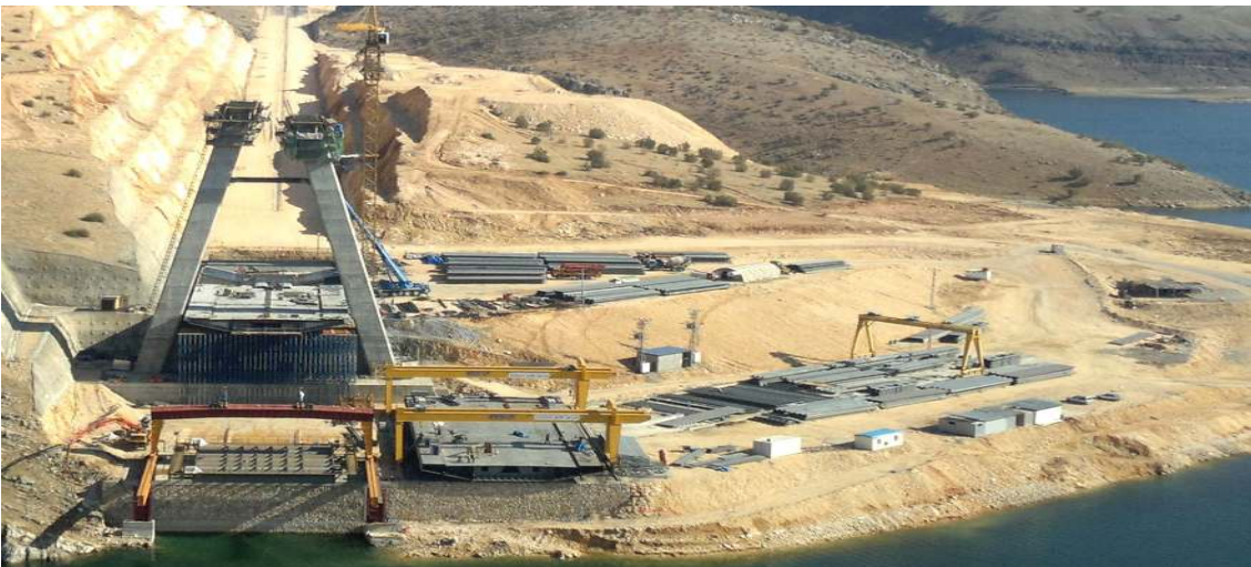
řekil 4.56. elik Segmentin st Yapıya Tařınmaya Hazır Hale Getirilmesi
