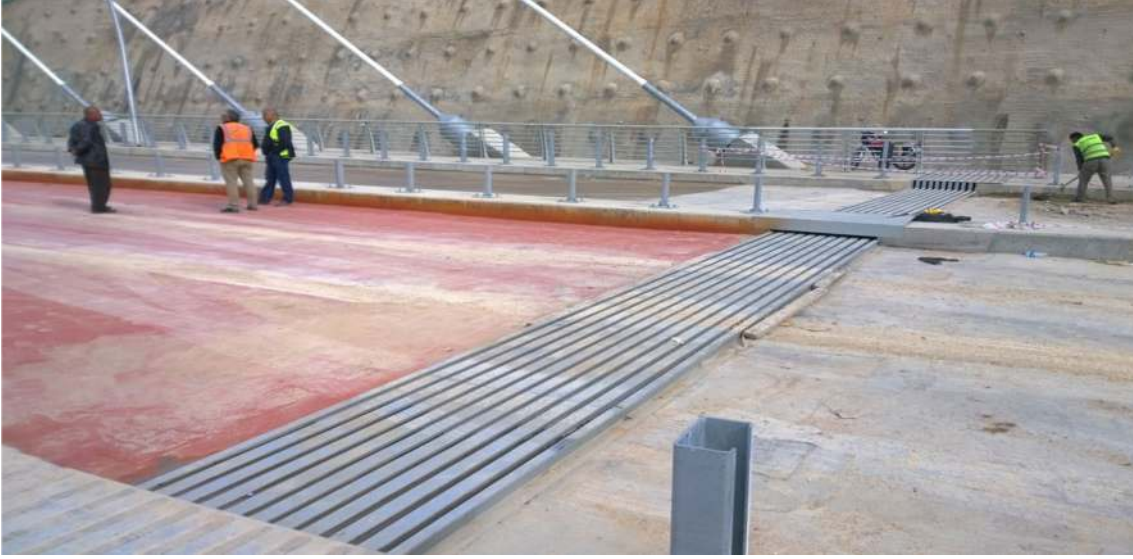
Şekil 4.30. Kenar Açıklıktaki Genleşme Derzi
