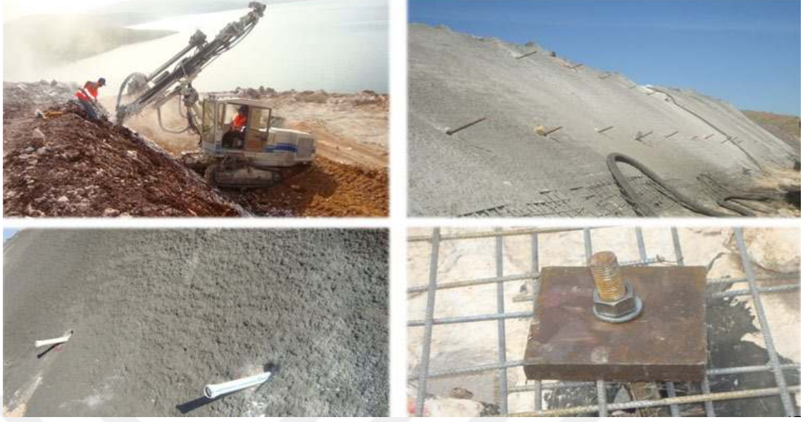
Şekil 4.19. Şev Destekleme Sisteminin İmalatı
