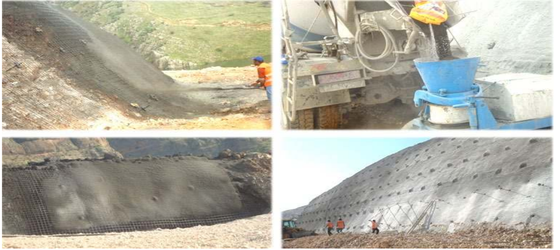
Şekil 4.20. Şev Destekleme Sisteminin İmalatı
