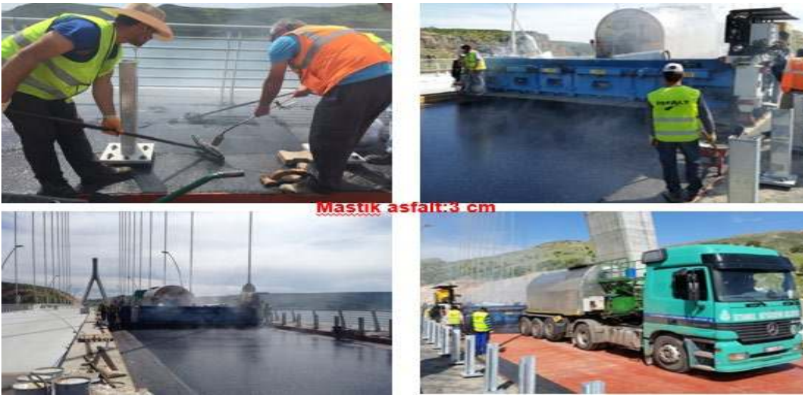
Şekil 4.70. Üstyapı Mastik Asfaltının Serilmesi (3 cm)
