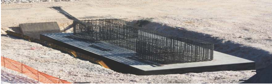
Şekil 4.23. Kenar Açıklık Orta Ayak Temel İmalatı
