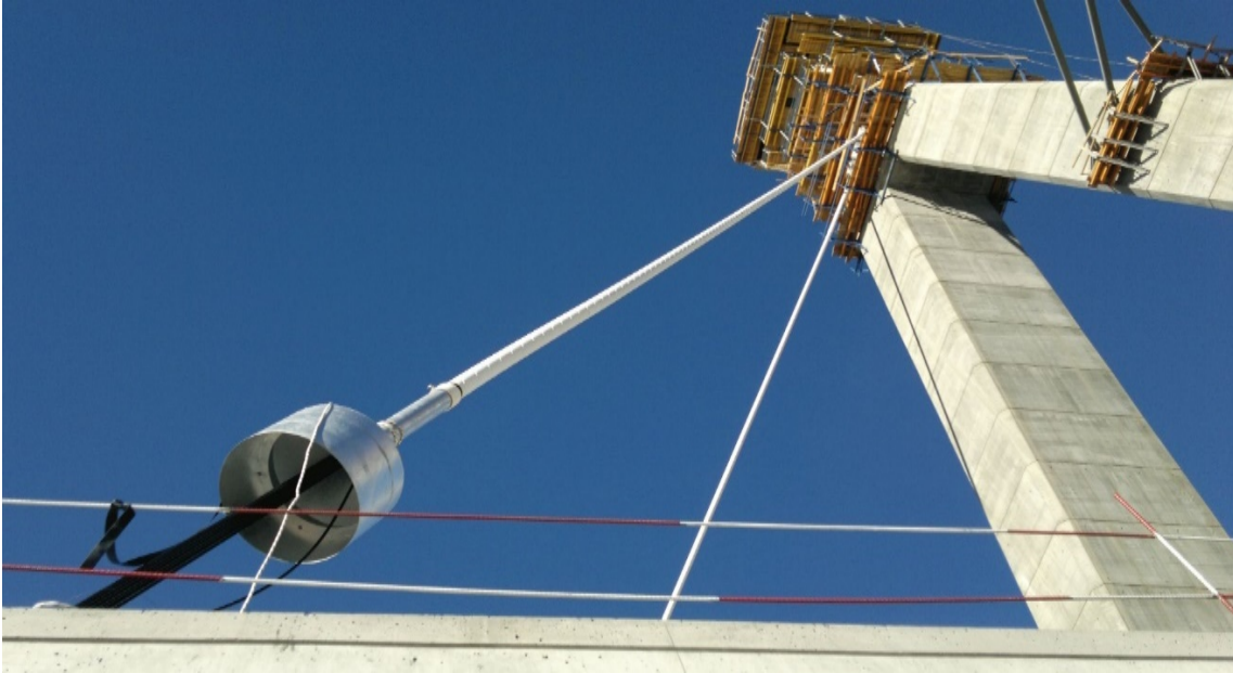
Şekil 4.66. Kablonun Pilonla Bağlantısı
