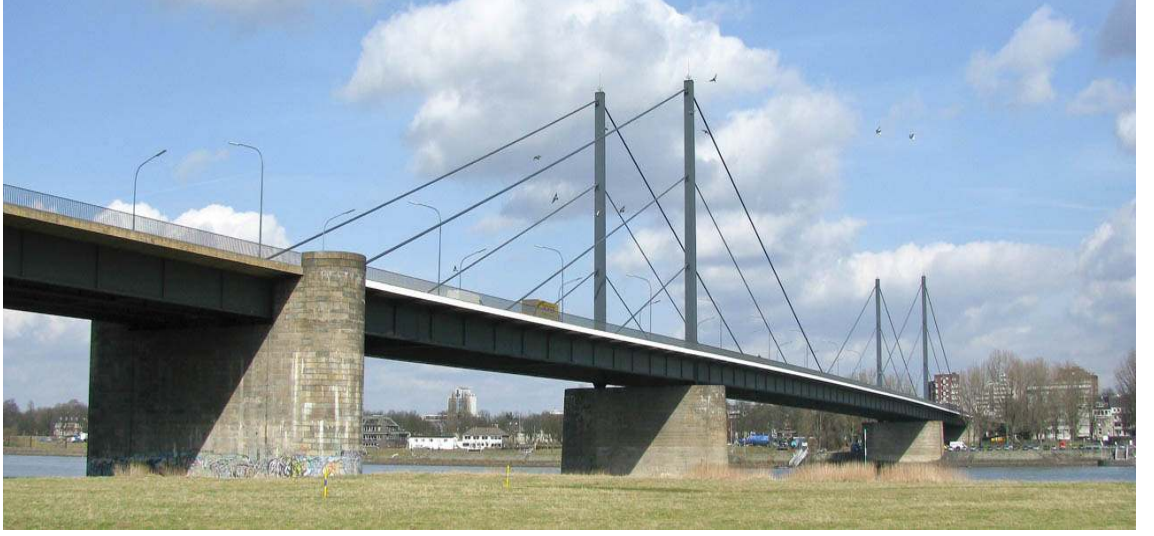
Şekil 2.2 Theodor Heuss (Nordbrücke ) Köprüsü
