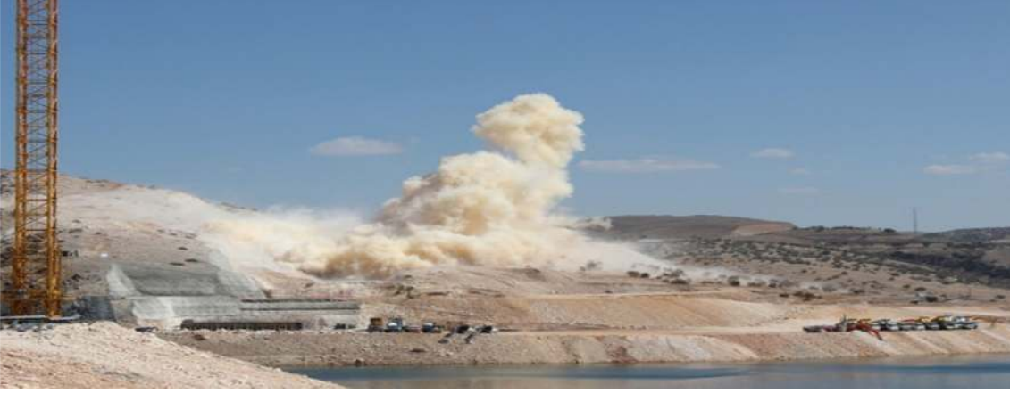
Şekil 4.16 Patlatmanın Yapılması
