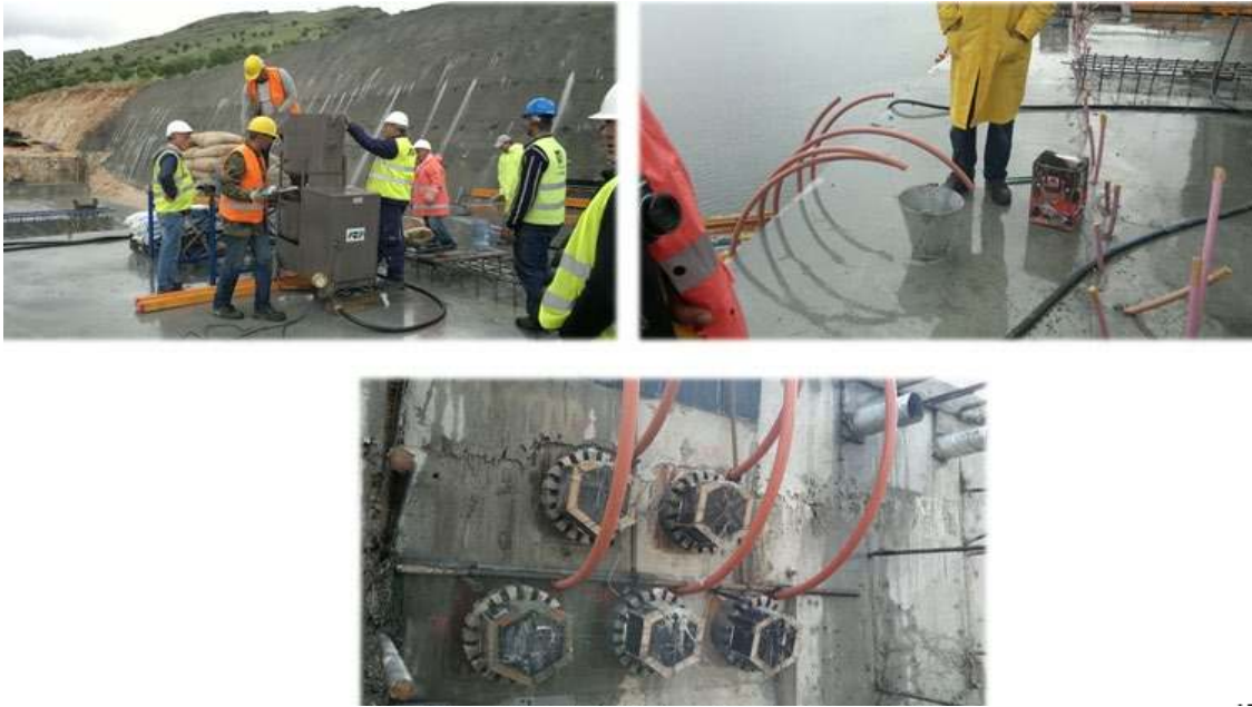
Şekil 4.37. Ard germe İşlemine Çimento Enjeksiyonu- nunun Yapılması
