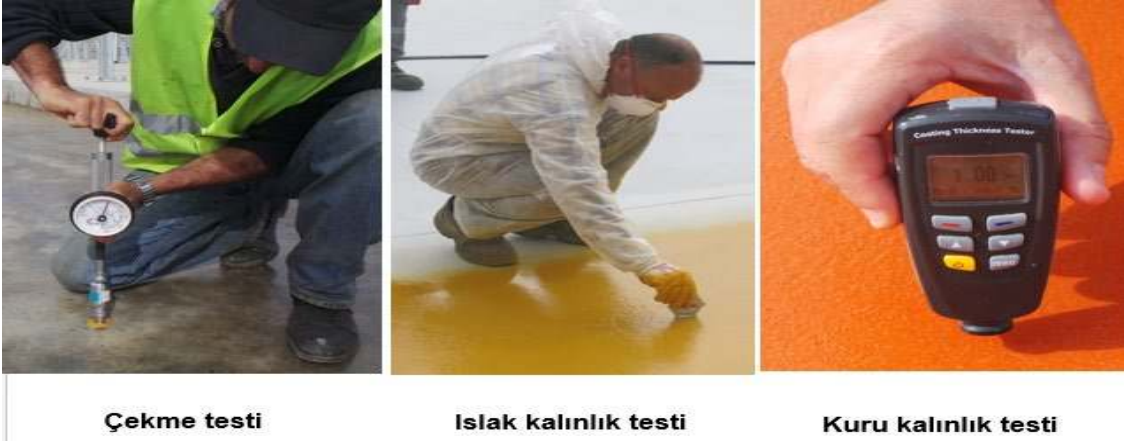
Şekil 4.69. Tabliye İzolasyonun Yapılması
