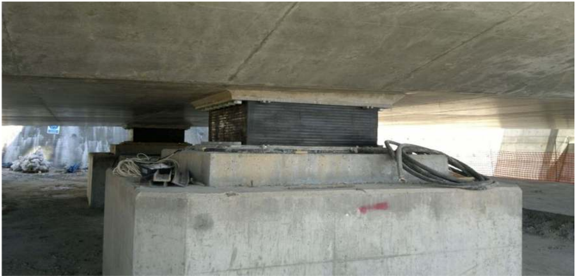
Şekil 4.26. Orta ayak Temelinin Mesnet Bandı Kotuna Getirilmesi
