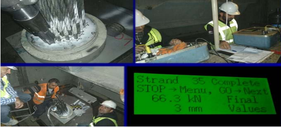
Şekil 4.65. Kabloya Uygun Germe Verilmesi Aşaması
