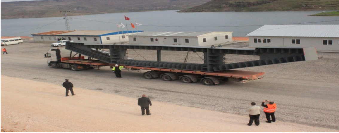
Şekil 4.44. İlk Çelik Segmentin İnşaat Alanına Taşınması
