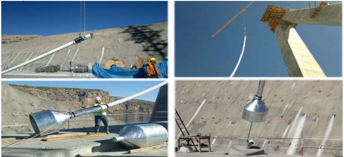
Şekil 4.63. Çelik Segmentin Kabloya Bağlantısının Yapılması
