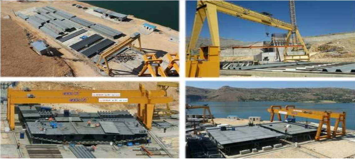
řekil 4.55. elik Segment Levhalarının řantiye Bir Araya Getirilmesi
