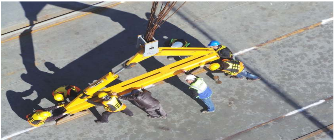
Şekil 4.58. Halatın Segmente Bağlanması
