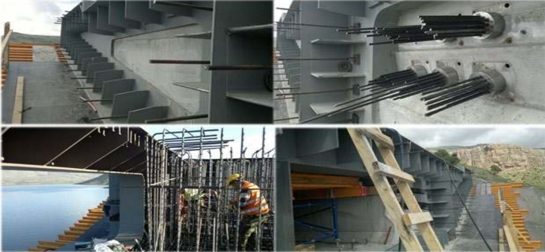
Şekil 4.50. Ard germe Kablolarının Beton ve Çelik Bağlantısının Yapılması
