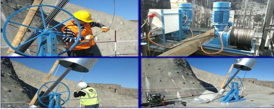
Şekil 4.64. Kabloya Germe İşleminin Uygulanması
