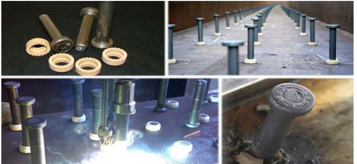
Şekil 4.48. İlk Çeliğin Betona Nelson Çivisi ile Montajı
