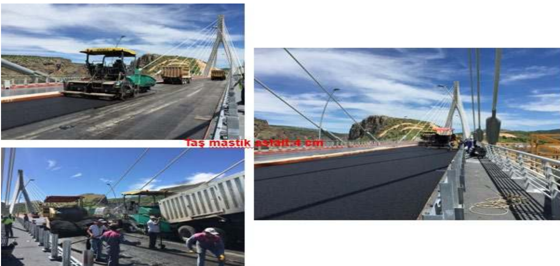
Şekil 4.71. Üstyapı Taş Mastik Asfaltının Serilmesi (4 cm)
