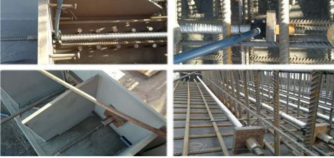
Şekil 4.49. İlk Çelik Segmentin Yüksek Mukavemetli Çelik ile Montajı
