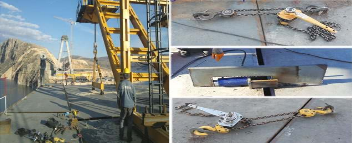
Şekil 4.60. Çeliğe Üst Yapıda Final Pozisyonunun Verilmesi
