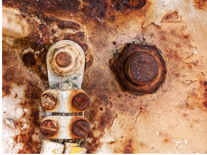
Şekil 3.4. Korozyon aşınmasına uğramış makine elemanı örneği
