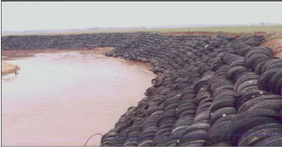
Şekil 4.4. Bütün lastiklerin şev korumasında kullanılması
