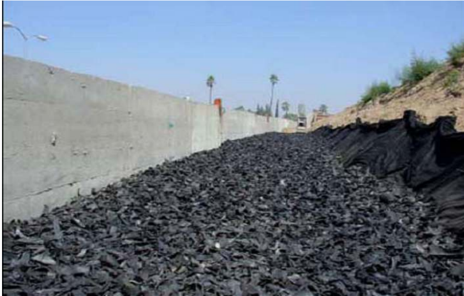
Şekil 4.5. Kullanılmış araç lastiklerinin duvar arkası dolgusunda kullanılması
