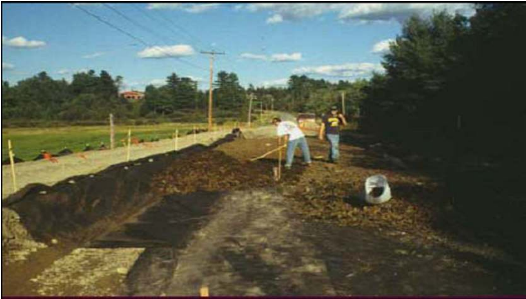
Şekil.4.6. Kullanılmış araç lastiklerinin yol gövdesinde kullanılması [49].
