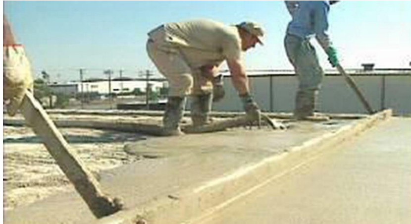
Şekil 3.5. GV esaslı hafif betonların çatı şapı olarak uygulanması [55]
