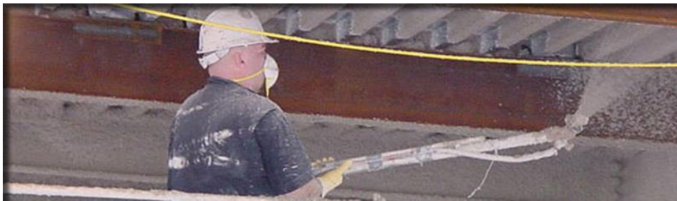
Şekil 3.3. GV esaslı harçların yangından korunma amaçlı çelik yapılara uygulanması [55]
