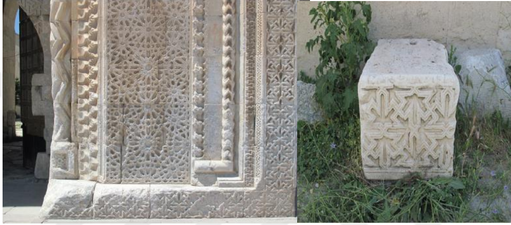
Şekil 101. Aksaray Sultan Hanı Taçkapısı (Duran 2019, 688)
