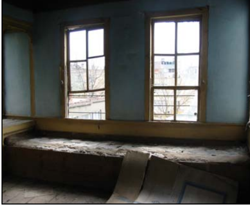
Resim 2.124. 113 mekanı d1 duvarı
