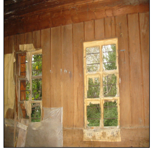
Resim 2.95. 106 mekanı d4 duvarı
