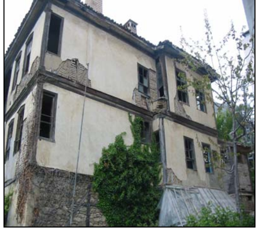
Resim 2.4. Sağ yan cephe
