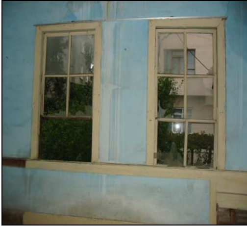
Resim 2.177. 208 mekanı d3 duvarı
