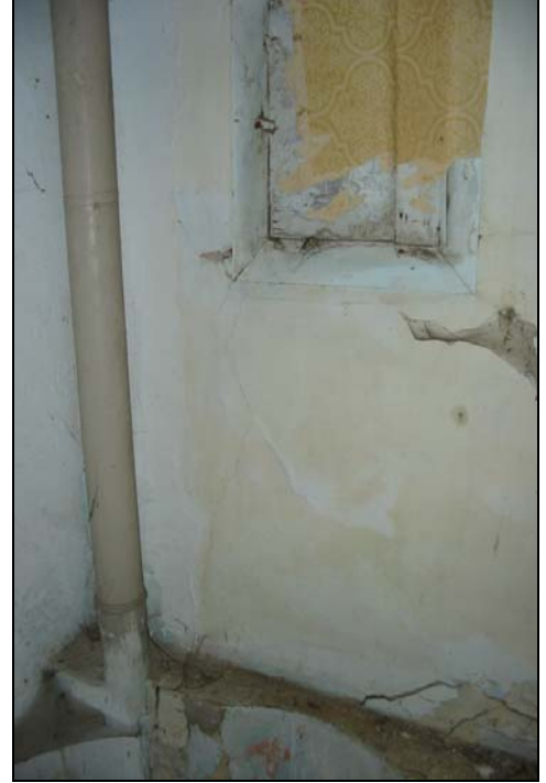
Resim 2.89. 104 mekanı d3 duvarı
