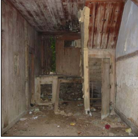
Resim 2.15. Z01 mekanı d3 duvarı
