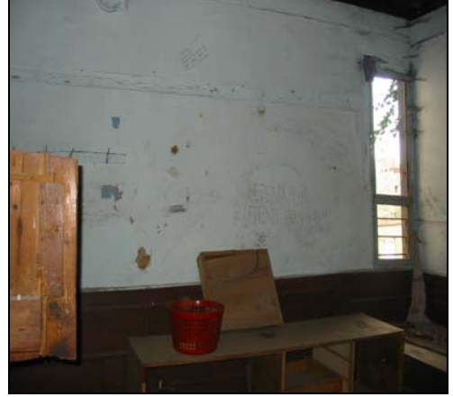
Resim 2.83. 103 mekanı d4 duvarı
