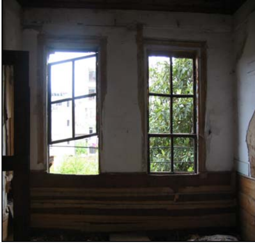
Resim 2.74. 102 mekanı d1 duvarı
