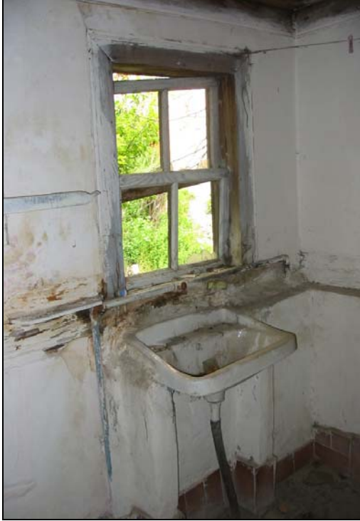
Resim 2.108. 109 mekanı d3 duvarı
