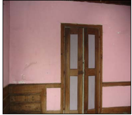
Resim 2.166. 206 mekanı d4 duvarı
