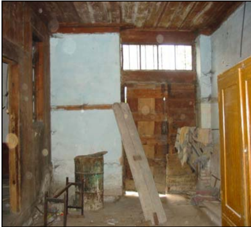
Resim 2.60. Z12 mekanı d1 duvarı
