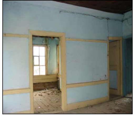
Resim 2.172. 207 mekanı d4 duvarı
