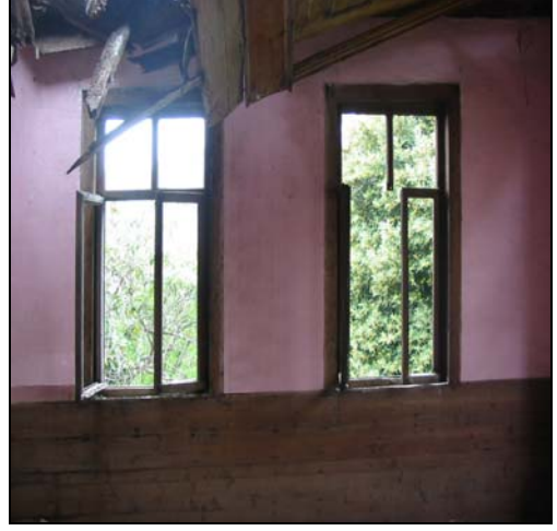
Resim 2.164. 206 mekanı d2 duvarı
