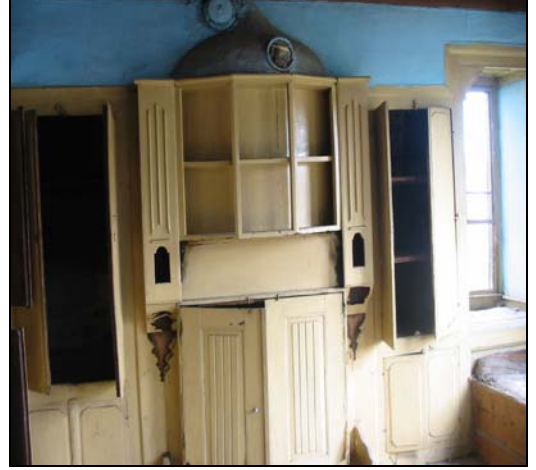
Resim 2.127. 113 mekanı d4 duvarı
