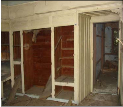
Resim 2.152. 203 mekanı d3 duvarı
