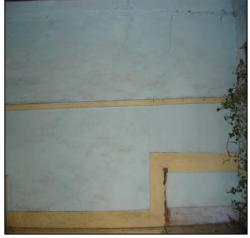
Resim 2.170. 207 mekanı d2 duvarı
