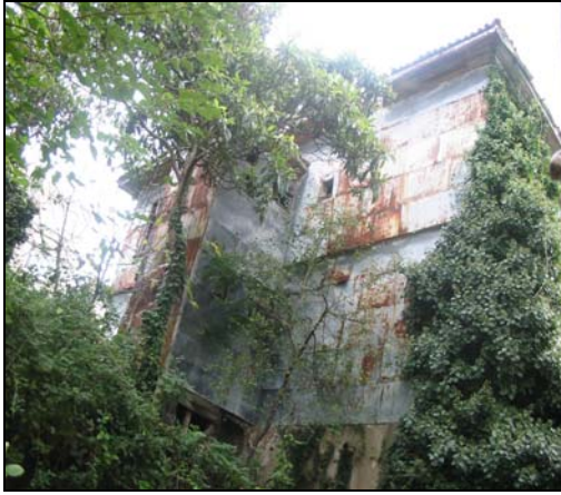
Resim 2.9. Sol yan cephe
