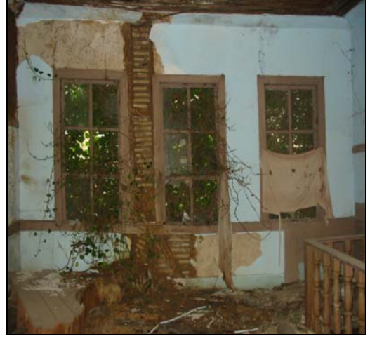
Resim 2.140. 201 mekanı d3 duvarı
