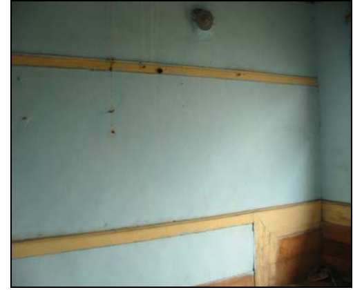
Resim 2.197. 212 mekanı d4 duvarı
