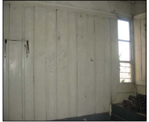
Resim 2.153. 203 mekanı d4 duvarı
