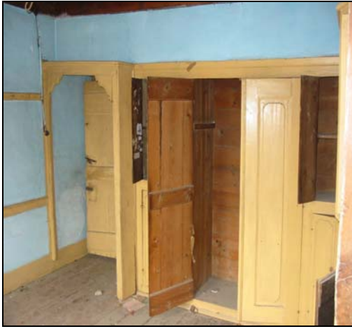
Resim 2.126. 113 mekanı d3 duvarı
