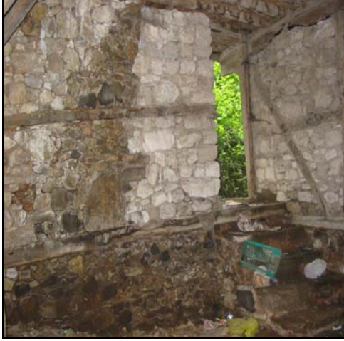
Resim 2.37. Z05 mekanı d2 duvarı
