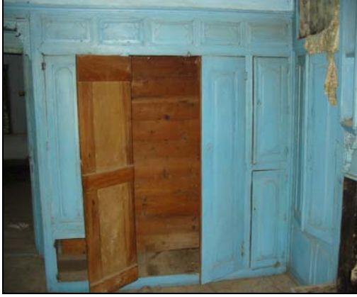
Resim 2.190. 211 mekanı d3 duvarı
