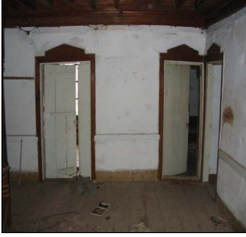
Resim 2.68. 101 mekanı d1 duvarı
