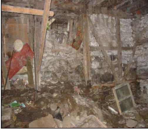
Resim 2.44. Z08 mekanı d3 duvarı
