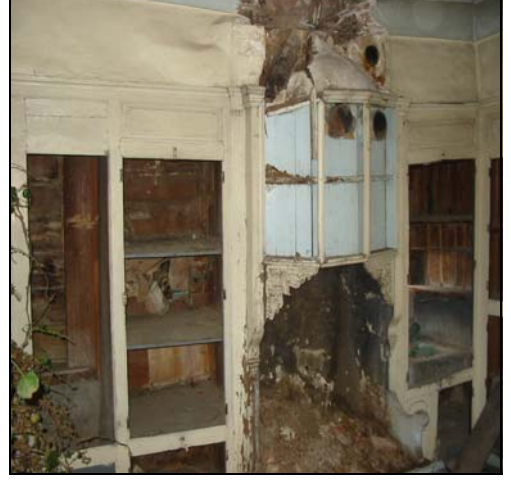
Resim 2.151. 203 mekanı d2 duvarı
