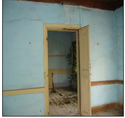
Resim 2.176. 208 mekanı d2 duvarı
