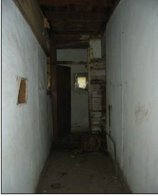
Resim 2.90. 105 mekanı d6 duvarı
