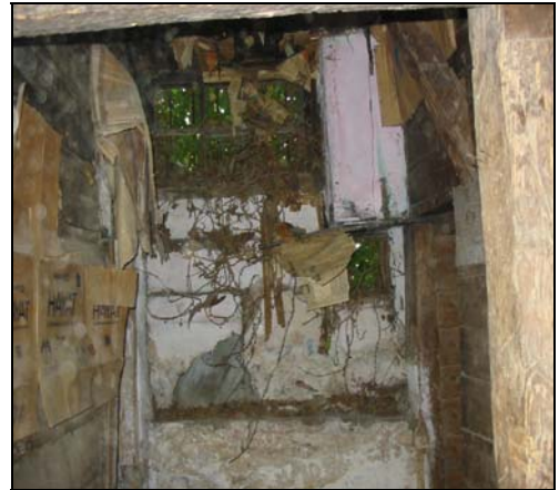
Resim 2.49. Z10 mekanı d4 duvarı
