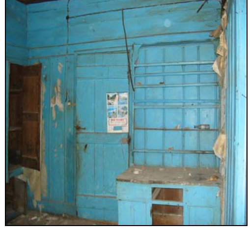
Resim 2.115. 111 mekanı d2 duvarı
