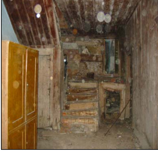
Resim 2.62. Z12 mekanı d3 duvarı
