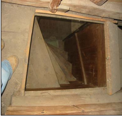
Resim 2.200. Çatı çıkış merdiveni
