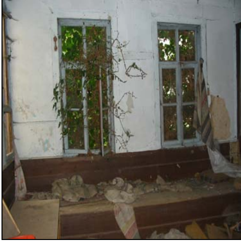
Resim 2.80. 103 mekanı d1 duvarı
