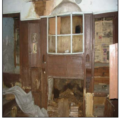
Resim 2.81. 103 mekanı d2 duvarı
