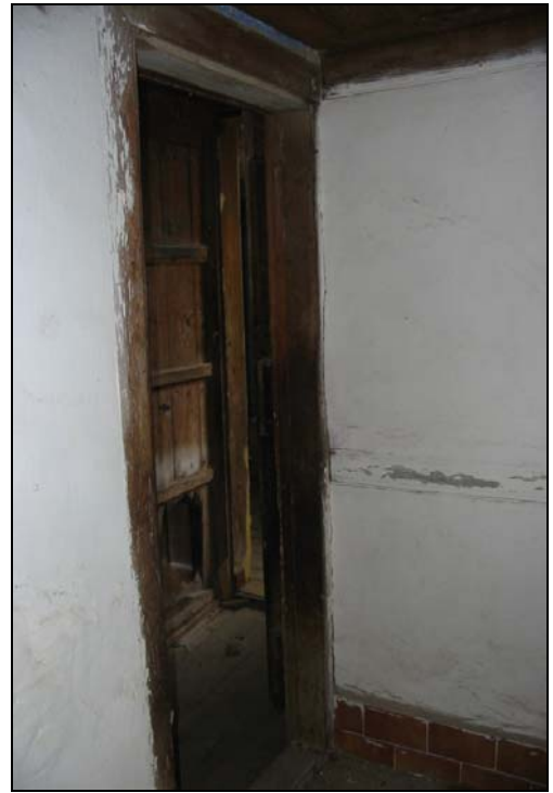
Resim 2.109. 109 mekanı d1 duvarı
