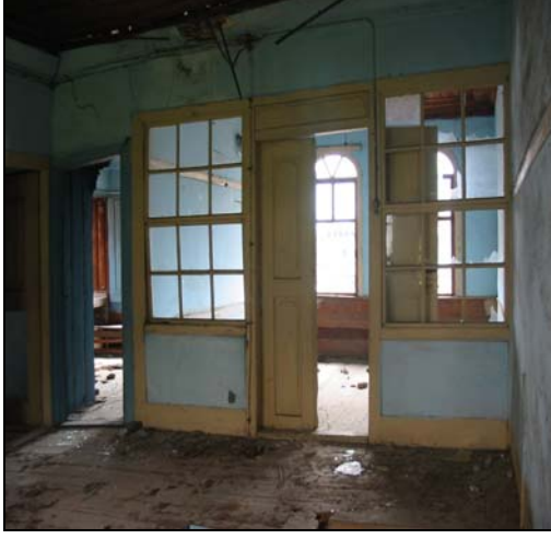
Resim 2.169. 207 mekanı d1 duvarı
