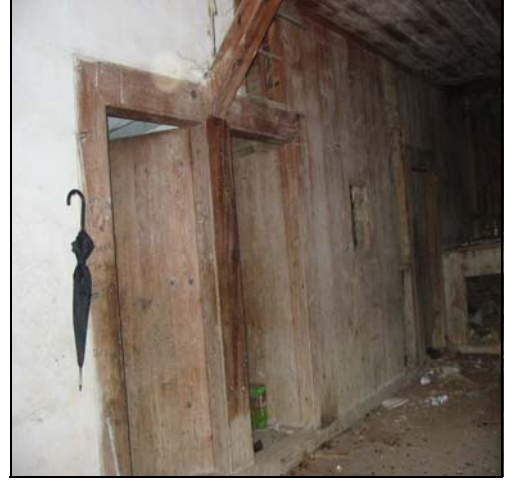
Resim 2.16. Z01 mekanı d2 duvarı
