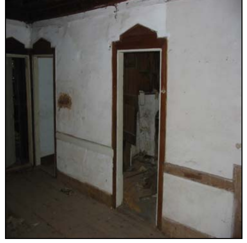
Resim 2.69. 101 mekanı d2 duvarı
