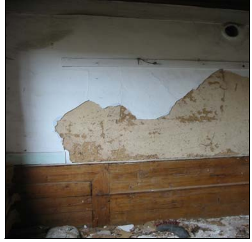
Resim 2.75. 102 mekanı d2 duvarı 1
