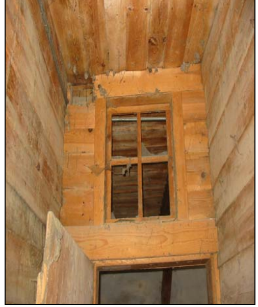
Resim 2.32. Z04 mekanı d4 duvarı
