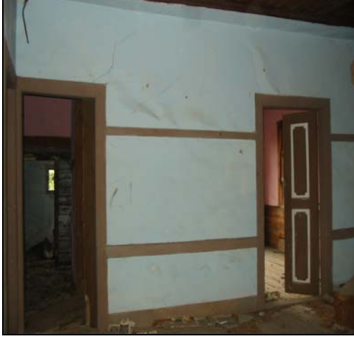
Resim 2.139. 201 mekanı d2 duvarı
