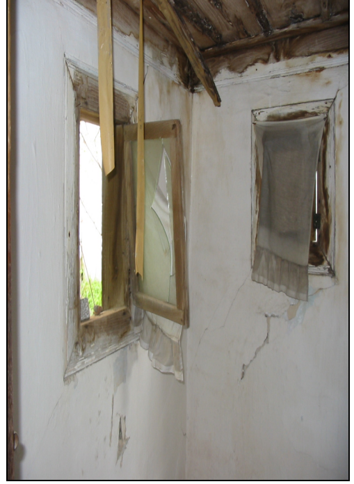
Resim 2.111. 110 mekanı d3-d4 duvarı
