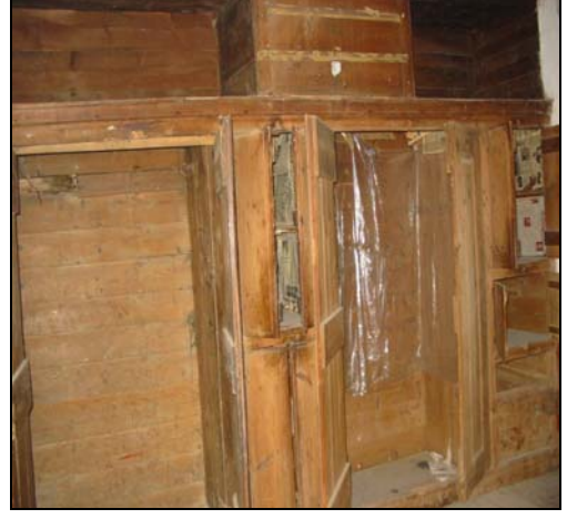
Resim 2.57. Z11 mekanı d4 duvarı
