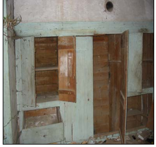
Resim 2.22. Z02 mekanı d2 duvarı
