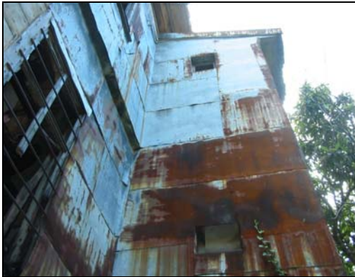
Resim 2.11. Sol yan cephe ek tuvalet
