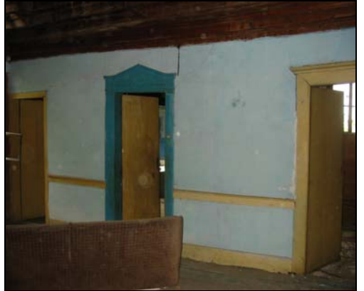
Resim 2.103. 107 mekanı d4 duvarı
