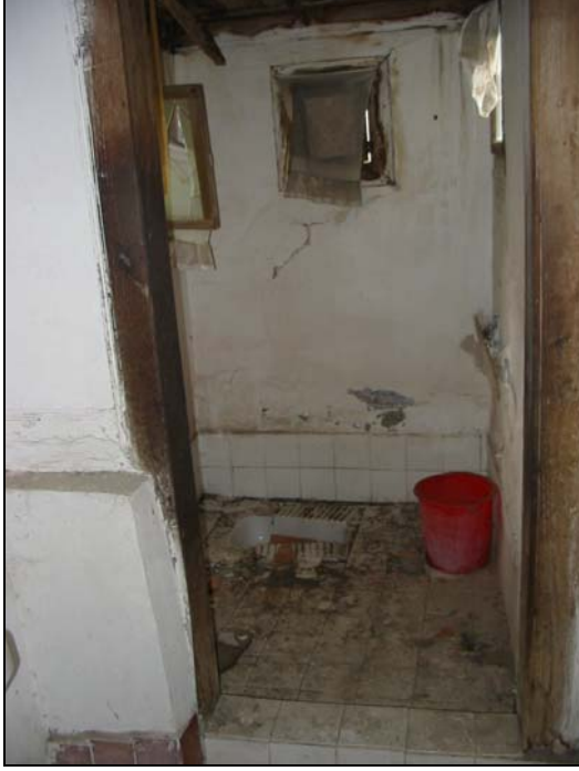
Resim 2.110. 110 mekanı d4 duvarı
