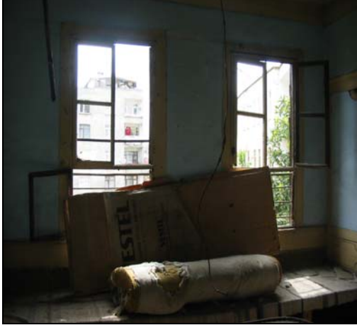
Resim 2.130. 114 mekanı d1 duvarı
