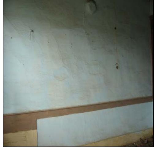
Resim 2.145. 202 mekanı d2 duvarı
