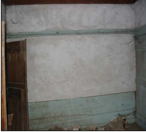
Resim 2.23. Z02 mekanı d3 duvarı
