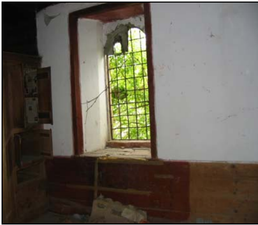
Resim 2.54. Z11 mekanı d1 duvarı
