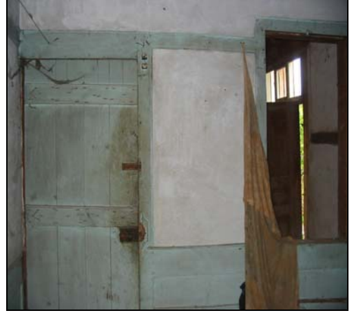
Resim 2.24. Z02 mekanı d4 duvarı
