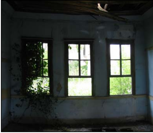
Resim 2.171. 207 mekanı d3 duvarı
