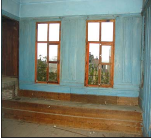
Resim 2.188. 211 mekanı d1 duvarı
