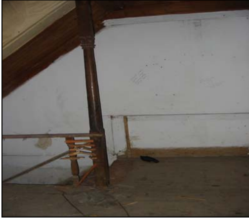
Resim 2.70 101 mekanı d3 duvarı
