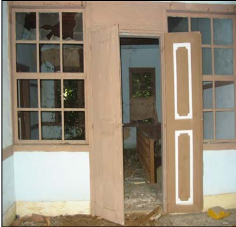
Resim 2.146. 202 mekanı d3 duvarı
