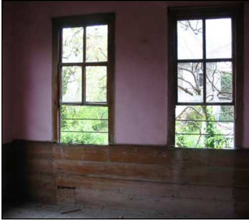
Resim 2.165. 206 mekanı d3 duvarı
