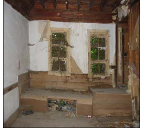
Resim 2.71. 101 mekanı d4 duvarı
