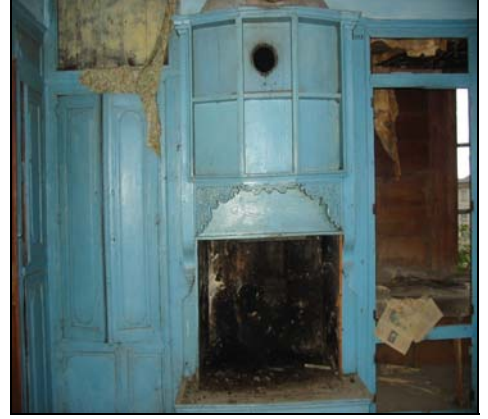
Resim 2.191. 211 mekanı d4 duvarı
