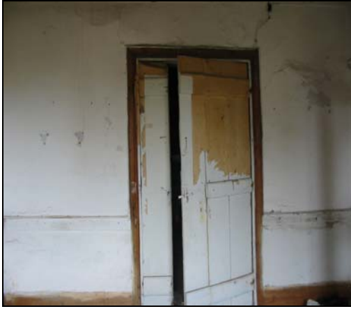
Resim 2.76. 102 mekanı d3 duvarı
