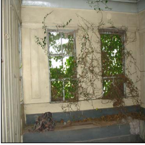
Resim 2.150. 203 mekanı d1 duvarı
