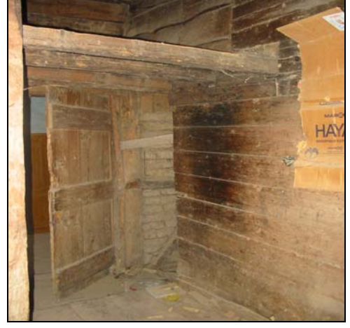
Resim 2.51. Z10 mekanı d2 duvarı
