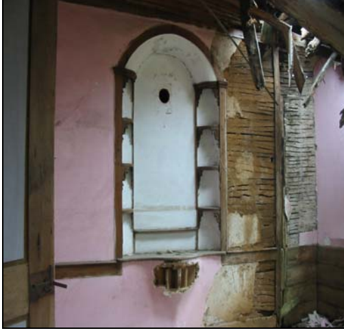
Resim 2.163. 206 mekanı d1 duvarı
