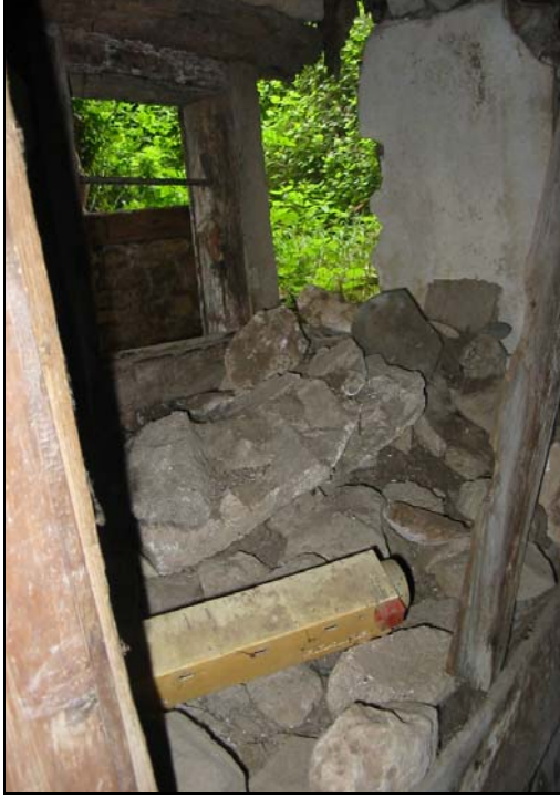
Resim 2.27. Z03 mekanı d2 duvarı
