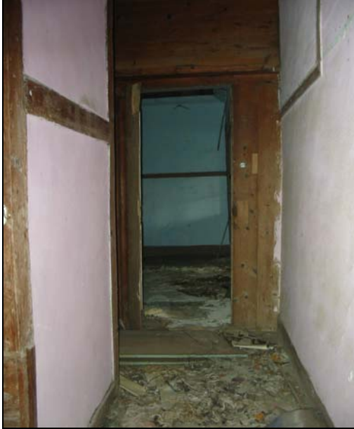
Resim 2.161. 205 mekanı d8 duvarı
