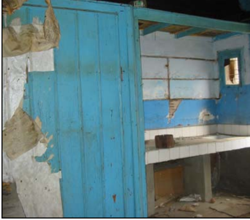
Resim 2.116. 111 mekanı d3-d5 duvarı
