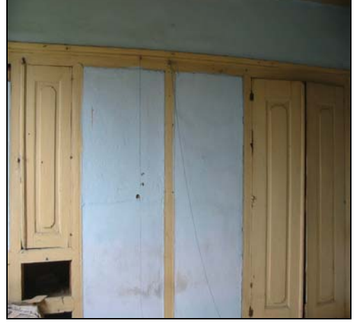
Resim 2.131. 114 mekanı d2 duvarı
