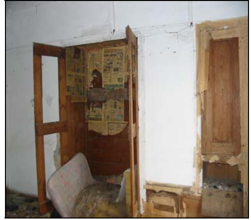
Resim 2.77. 102 mekanı d4 duvarı
