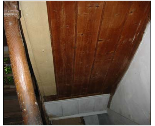
Resim 2.67. M1 merdiveni tavanı
