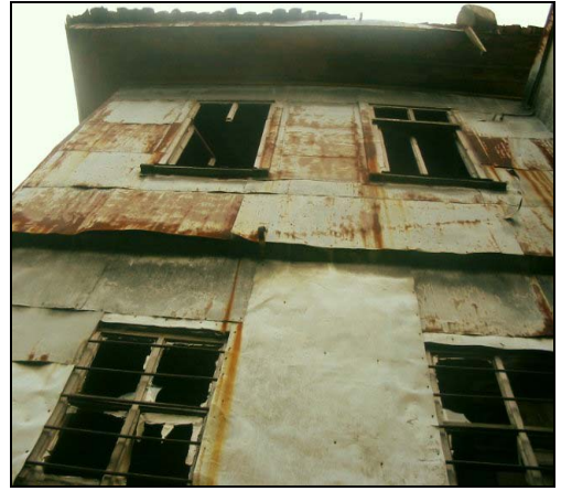
Resim 2.10. Sol yan cephe
