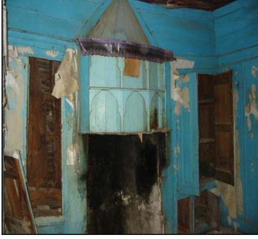
Resim 2.114. 111 mekanı d1 duvarı
