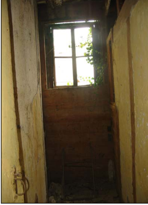
Resim 2.120. 112 mekanı d4 duvarı
