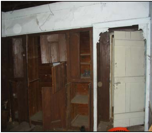
Resim 2.82. 103 mekanı d3 duvarı
