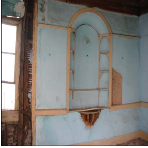
Resim 2.175. 208 mekanı d1 duvarı
