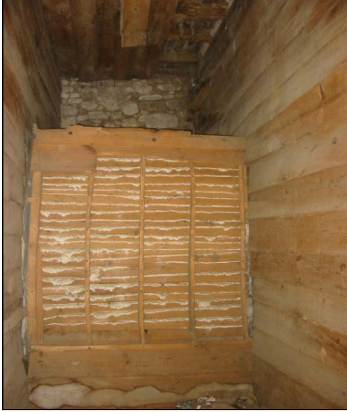
Resim 2.31. Z04 mekanı d2 duvarı
