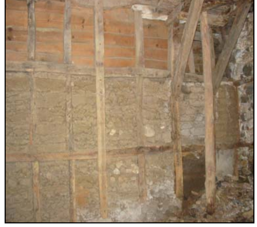
Resim 2.36. Z05 mekanı d1 duvarı
