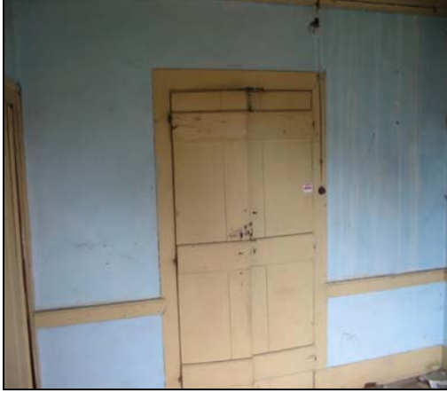
Resim 2.132. 114 mekanı d3 duvarı
