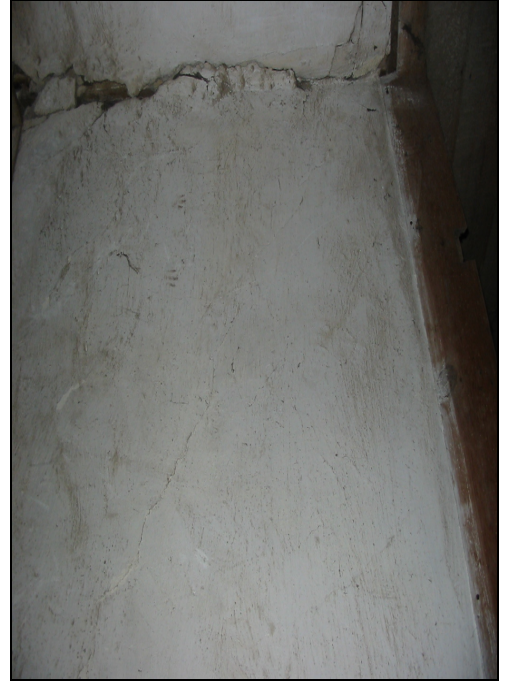
Resim 2.30. Z03 mekanı d3 duvarı
