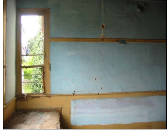
Resim 2.125. 113 mekanı d2 duvarı
