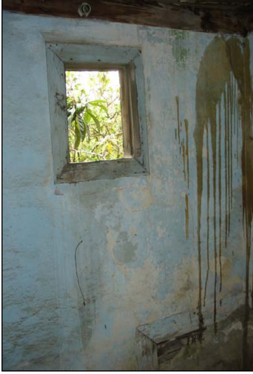
Resim 2.156. 204 mekanı d2 duvarı
