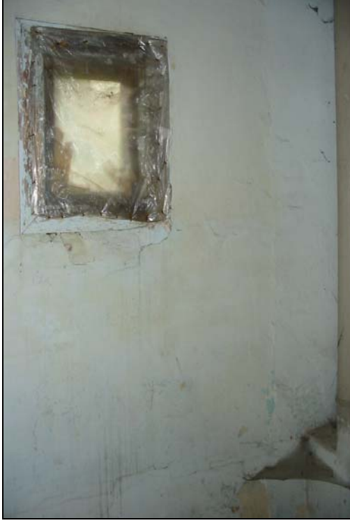
Resim 2.86. 104 mekanı d2 duvarı
