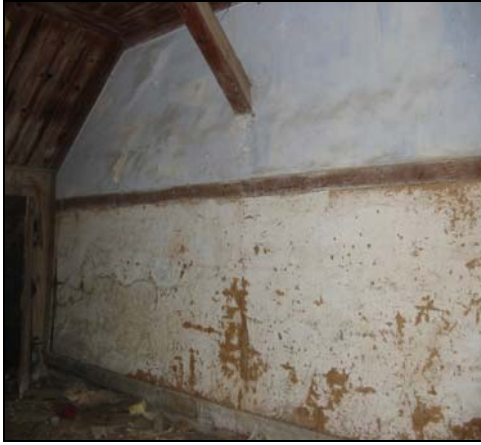
Resim 2.17. Z01 mekanı d4 duvarı
