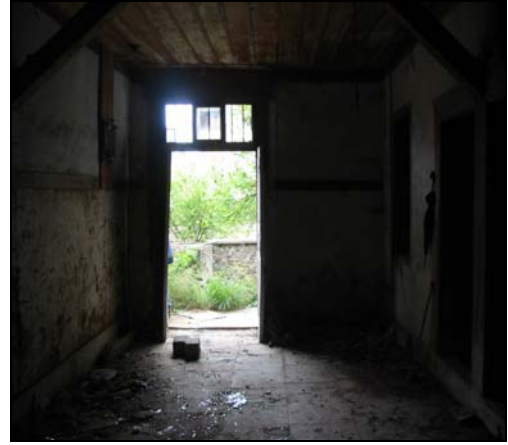
Resim 2.18. Z01 mekanı d1 duvarı
