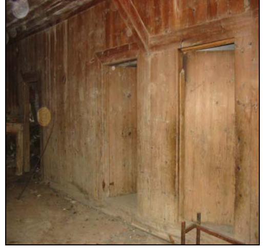
Resim 2.63. Z12 mekanı d4 duvarı
