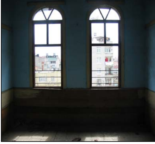
Resim 2.194. 212 mekanı d1 duvarı
