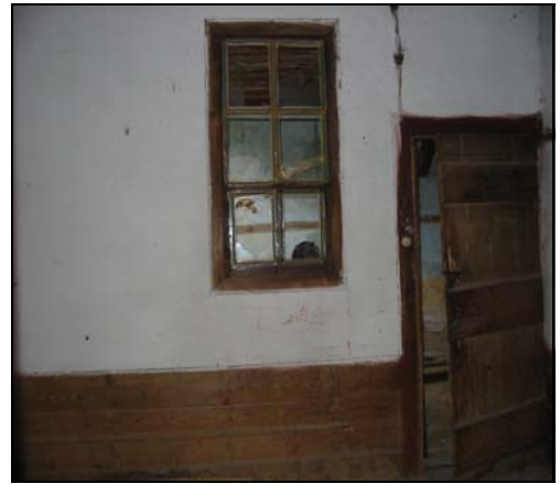
Resim 2.55. Z11 mekanı d2 duvarı
