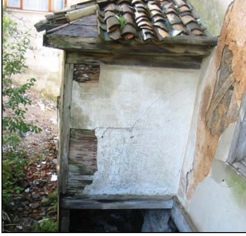
Resim 2.7. Arka cephe ek tuvalet
