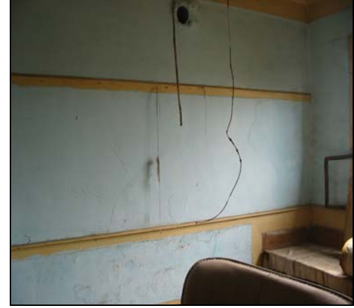
Resim 2.133. 114 mekanı d4 duvarı
