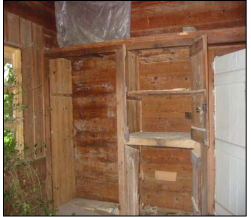
Resim 2.97. 106 mekanı d6 duvarı
