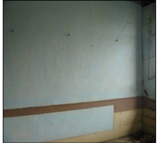
Resim 2.147. 202 mekanı d4 duvarı
