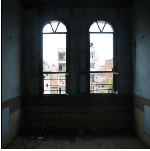
Resim 2.144. 202 mekanı d1 duvarı
