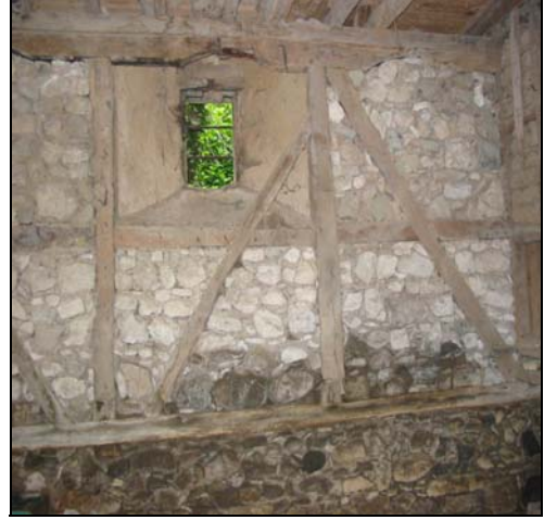
Resim 2.38. Z05 mekanı d3 duvarı
