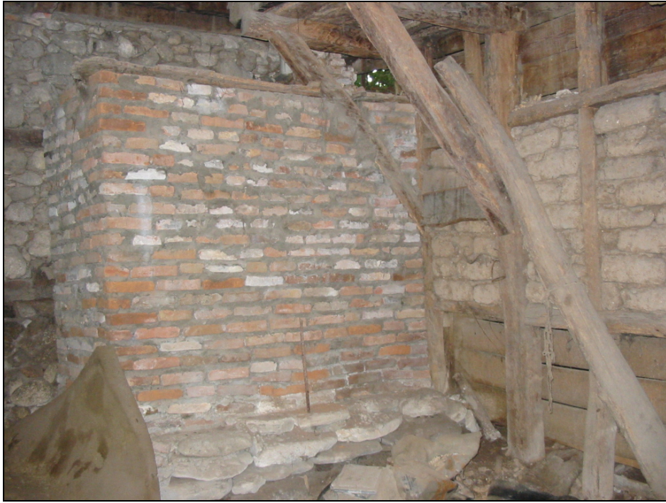
Resim 2.43. Z08 mekanı d1-d5-d6 duvarı
