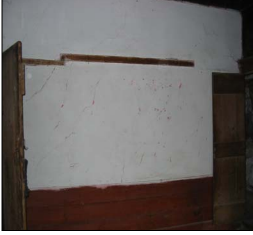
Resim 2.56. Z11 mekanı d3 duvarı
