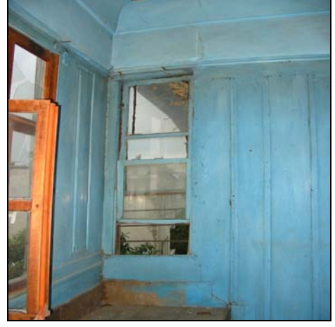
Resim 2.189. 211 mekanı d2 duvarı
