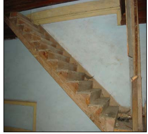
Resim 2.101. 107 mekanı d2 duvarı
