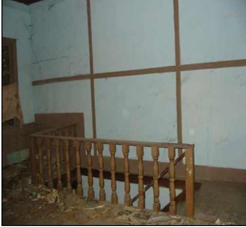
Resim 2.141. 201 mekanı d4 duvarı
