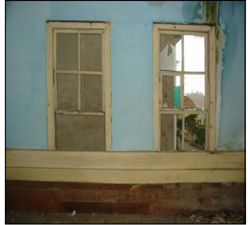
Resim 2.178. 208 mekanı d4 duvarı
