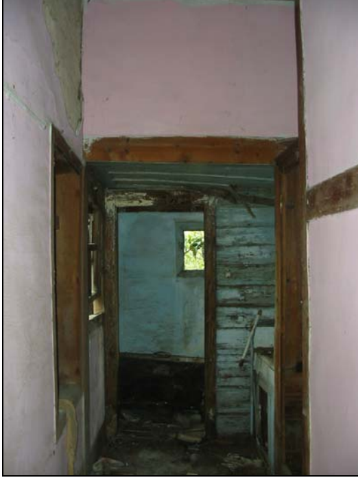
Resim 2.159. 205 mekanı d2 duvarı
