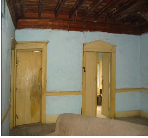
Resim 2.100. 107 mekanı d1 duvarı
