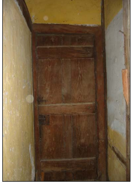
Resim 2.121. 112 mekanı d2 duvarı
