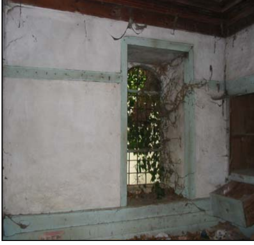
Resim 2.21. Z02 mekanı d1 duvarı
