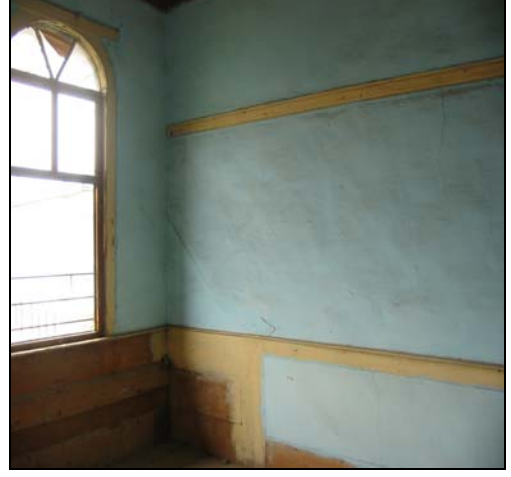
Resim 2.195. 212 mekanı d2 duvarı
