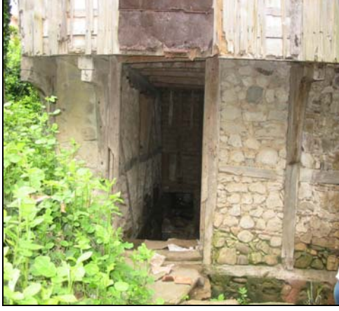
Resim 2.35. Z05 mekanı girişi
