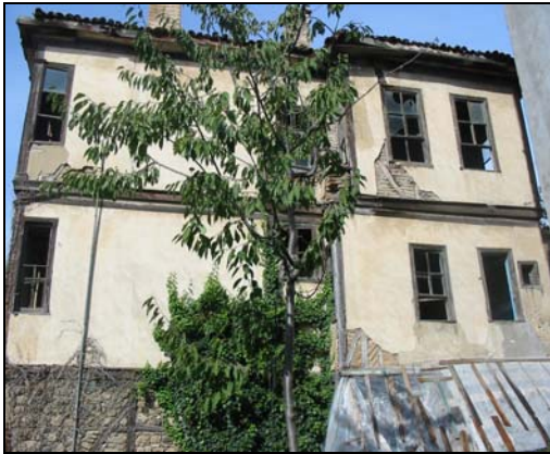
Resim 2.5. Sağ yan cephe
