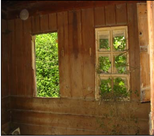
Resim 2.96. 106 mekanı d5 duvarı
