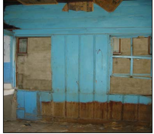
Resim 2.117. 111 mekanı d6 duvarı
