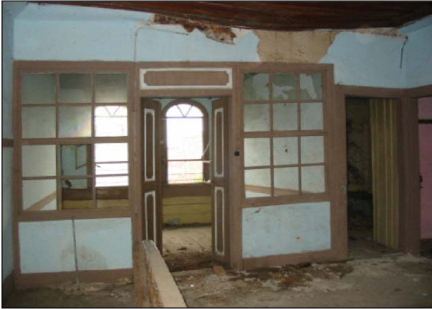
Resim 2.138. 201 mekanı d1 duvarı
