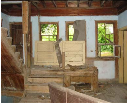
Resim 2.102. 107 mekanı d3 duvarı
