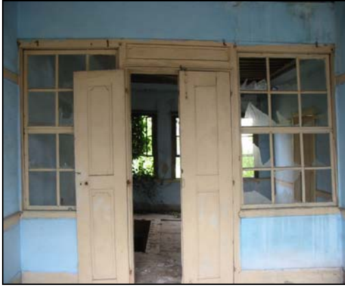
Resim 2.196. 212 mekanı d3 duvarı
