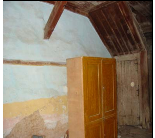
Resim 2.61. Z12 mekanı d2 duvarı
