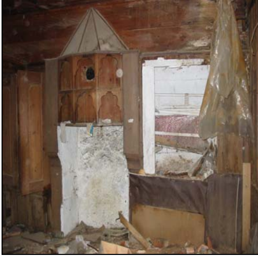
Resim 2.94. 106 mekanı d1 duvarı
