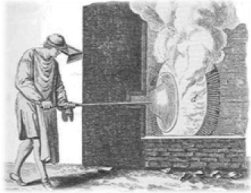
Şekil 1.1. 1750 yılında uygulanan cam üretim tekniğine bir örnek [3]
