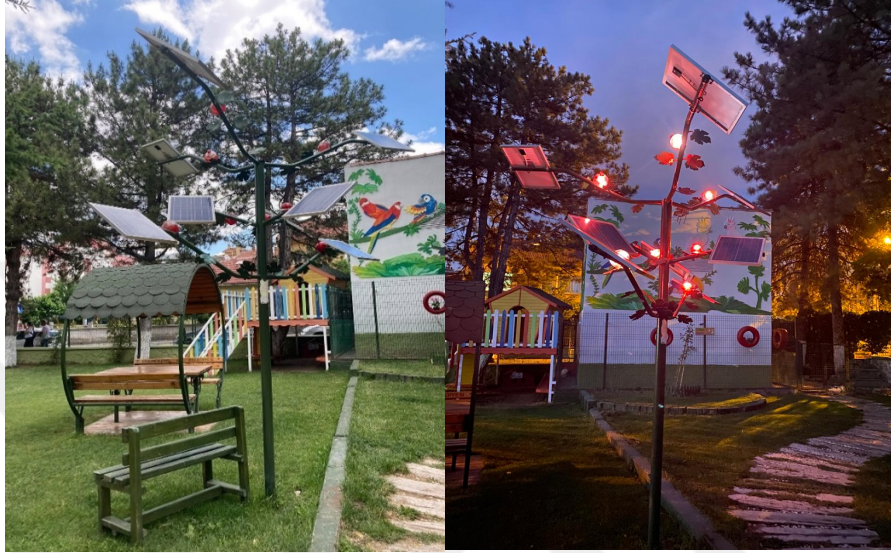
Görsel 2.16. Güneş enerjisi ile çalışan güneş ağacı
