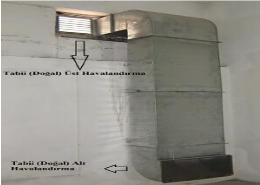
Resim 7.3. Alt ve üst doğal havalandırma örneği
