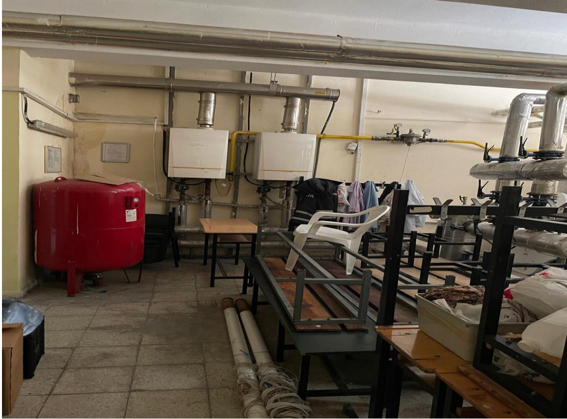
Resim 7.10. Uygun şekilde düzenlenmeyen kazan dairesi saha örneği
