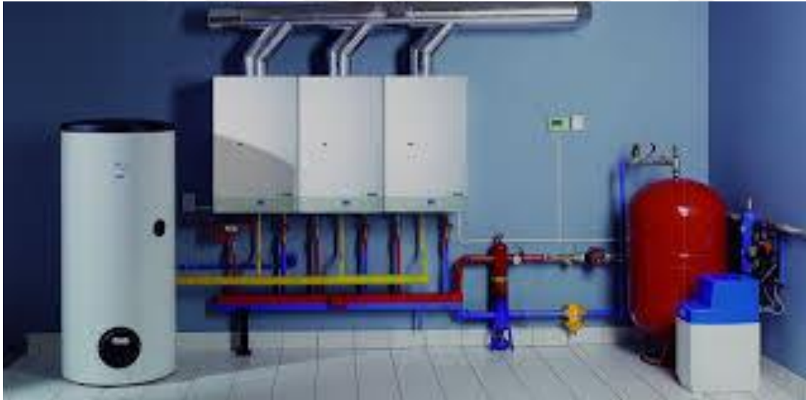
Resim 7.1. Kaskad ısıtma sistemi kazan dairesi örneği
