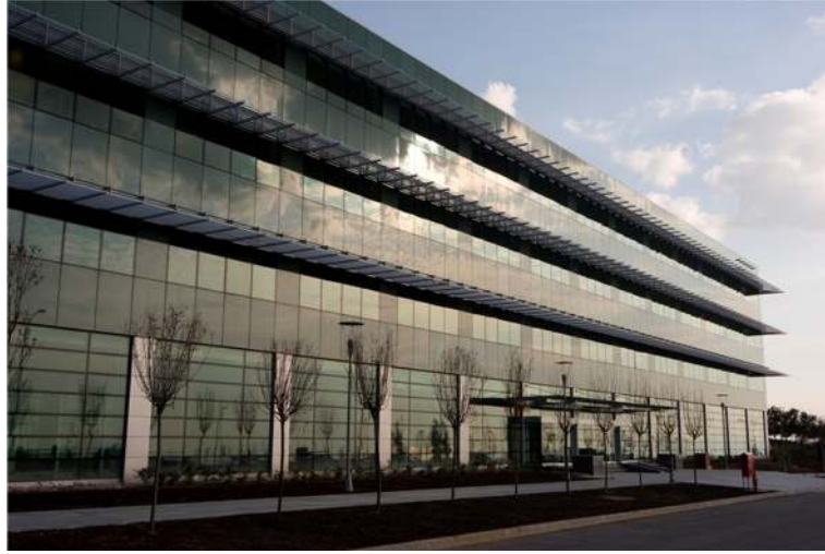
Şekil 3.14 Siemens Gebze binası ( http://cedbik.org/ )
