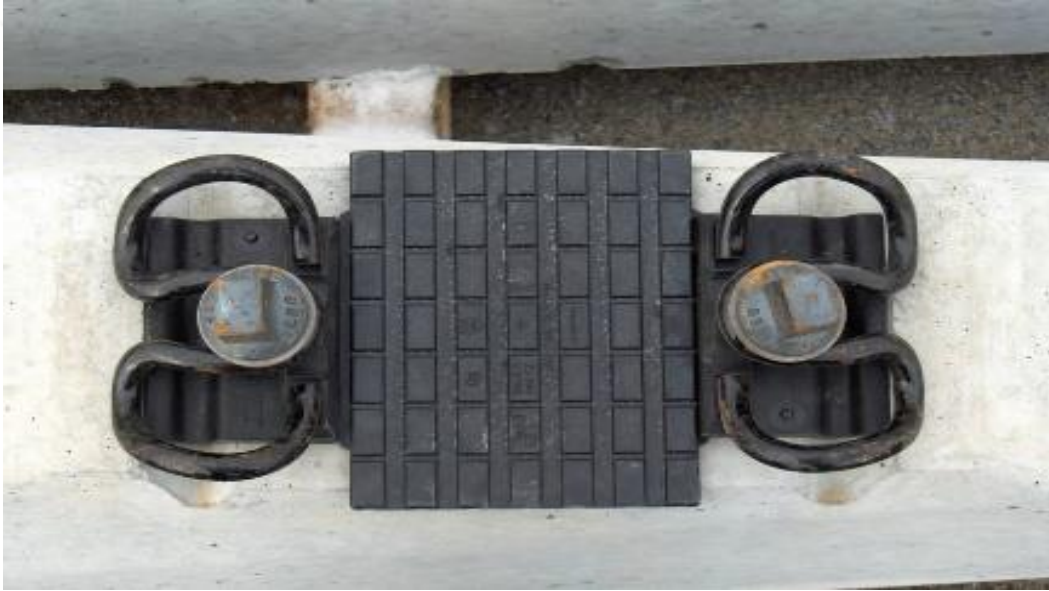
Resim 2.1 Travers ve bağlantı elemanları (Tacim 2018).
