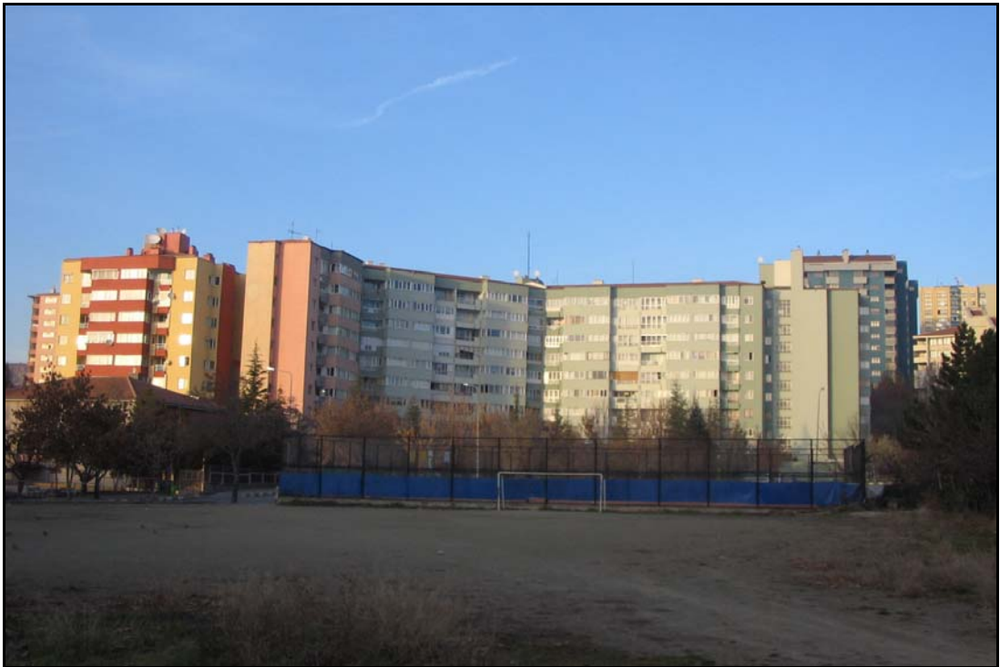
Resim 5.8. Çarşı merkezinin ön cephesinin görünüşü, 2008 [76]
