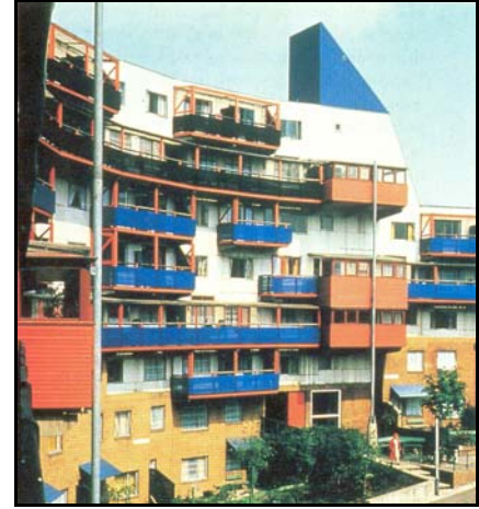
Resim 2.29. Byker Wall , cephe [24]
