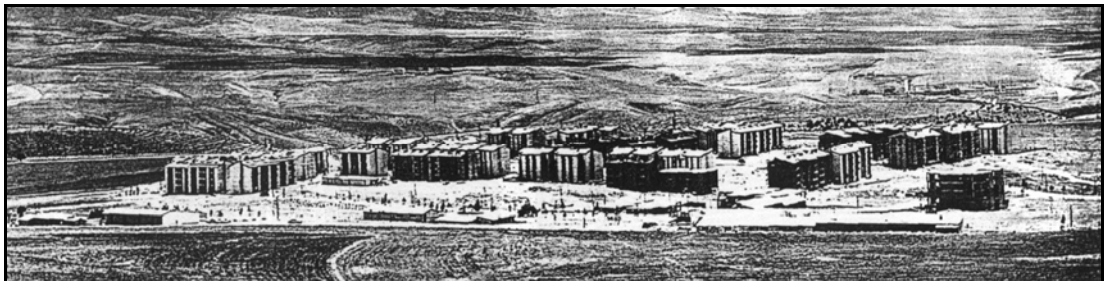
Resim 4.8. OR-AN Yerleşimi'nin inşaatının başladığı ilk yıllardan, konut blokları ve sağda yapımına başlanmış çarşı merkezinin Çaldağı'ndan görünüşü [123]
