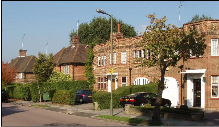
Resim 2.9. Hampstead Bahçe Şehri , konut giriş cephesi [20]
