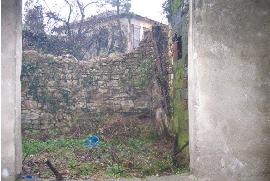
Resim 3.10. Yapının kuzeybatı (arka) cephesi
