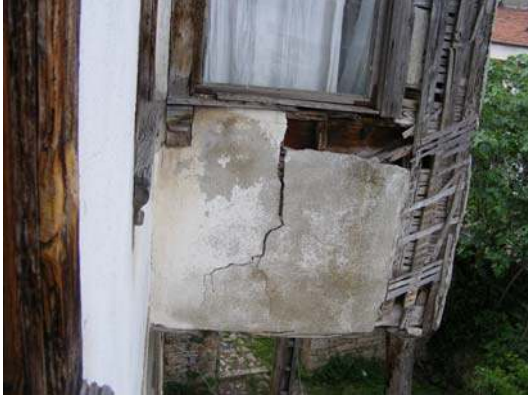
Resim 3.29.-3.30. 1. kat dış duvarların bagdadi ahşap çıtaları ve dolgu detayları
