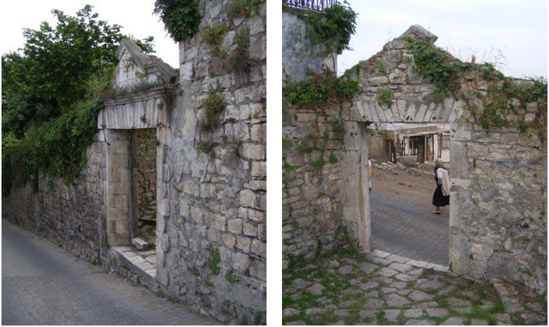
Şekil 3.1.-3.2. Furtun Sokak'tan Orta Sokak'a geçiş kapısı (Ön-Arka görünüşü)
