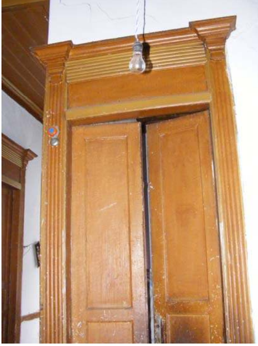
Resim 3.90.- 106-oda kapısı (K13) (dış)
