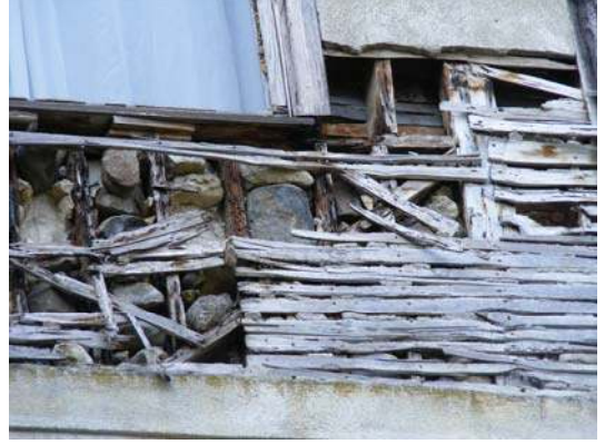
Resim 3.29.-3.30. 1. kat dış duvarların bagdadi ahşap çıtaları ve dolgu detayları
