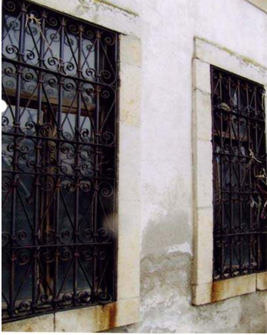
Resim 3.31.-3.32. Zemin kat pencerelerinin taş söveleri ve demir parmaklıkları
