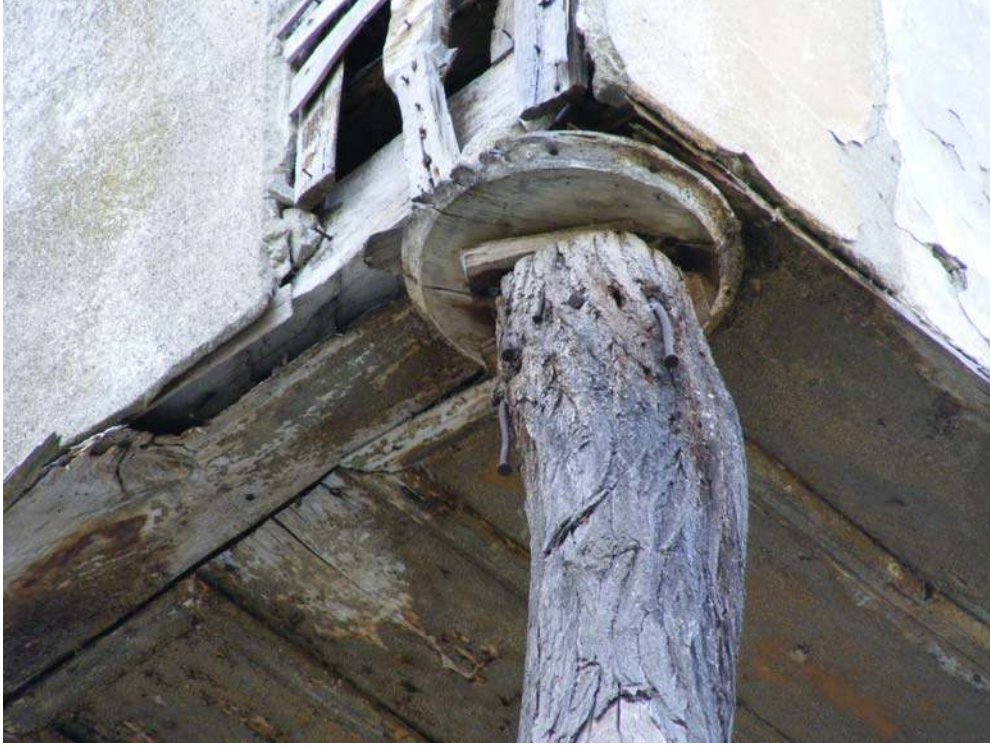
Resim 3.21. Ahşap dikmelerden sol taraftakinin yerine konulan ağaç gövdesi
