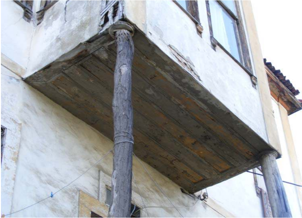
Resim 3.20. Yapının güneydoğu (ön) cephesindeki çıkma ve ahşap dikmeler
