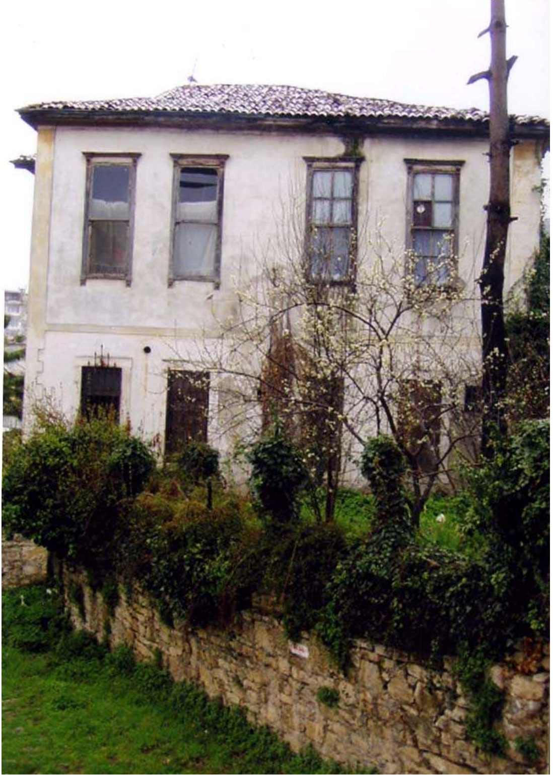
Resim 3.8. Yapının kuzeydoğu cephesi
