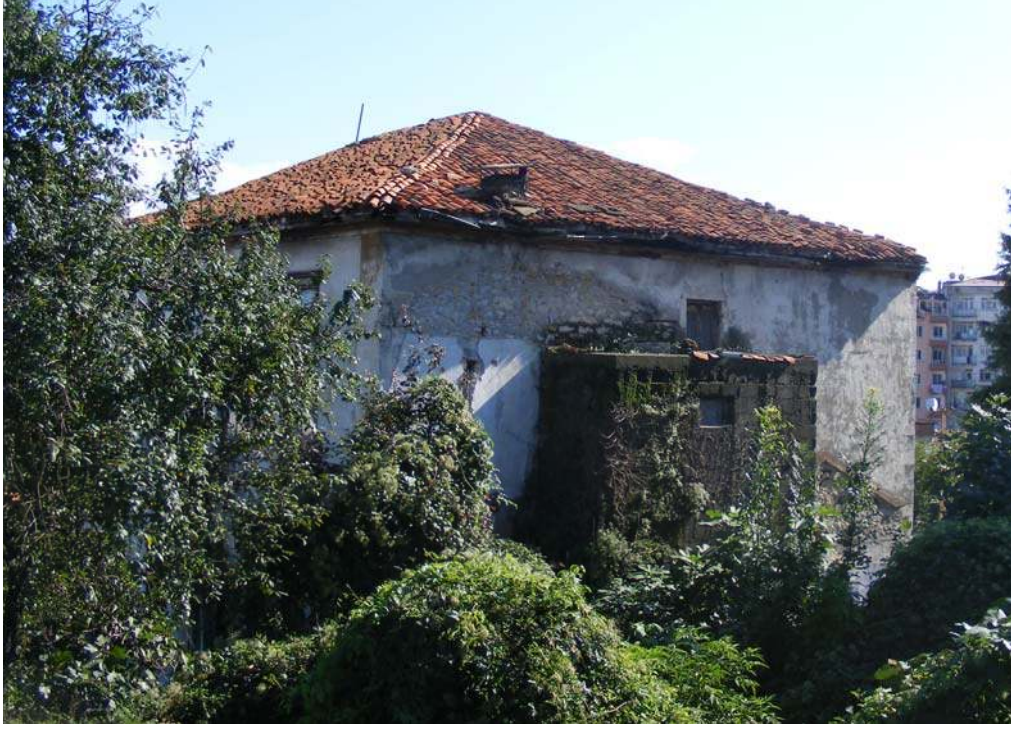
Resim 3.9. Yapının kuzeybatı (arka) cephesi
