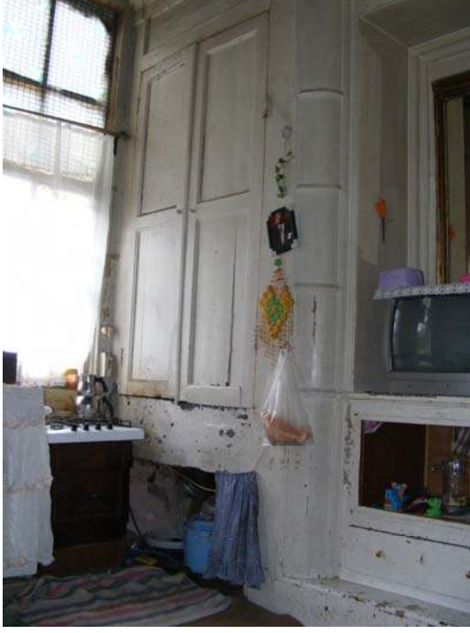
Resim 3.80. 103-odanın ahşap dolabı
