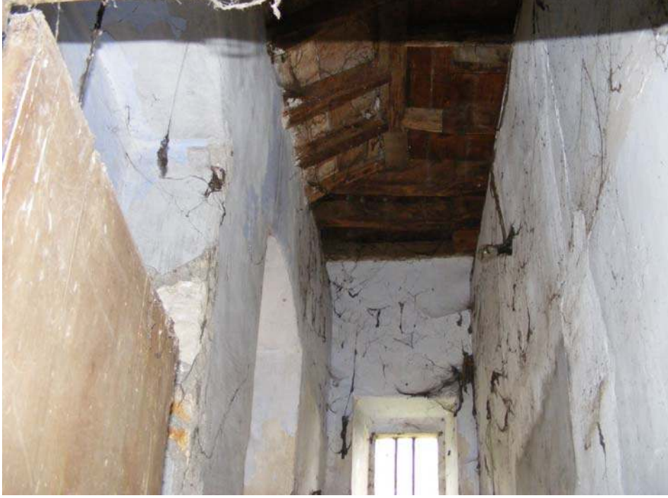
Resim 3.66. Z08 numaralı mekanın çatı konstrüksiyonuna ait izler
