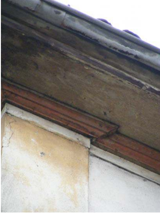
Resim 3.28. Ahşap çatı silmesi
