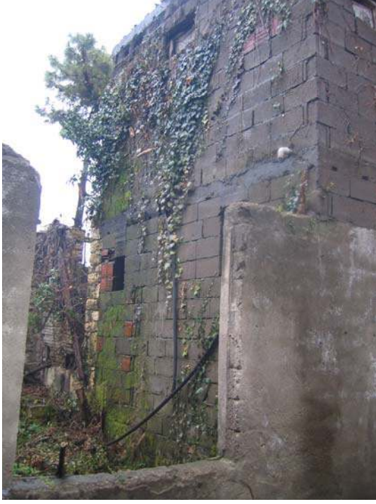
Resim 3.11. Furtun Evi'nin kuzeybatı cephesindeki ıslak hacim mekanı
