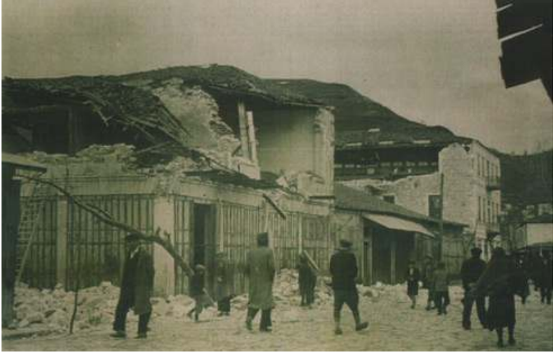
Resim 1.5. 1939 Erzincan depremi sonrası Ordu'daki hasar görüntüleri [5].
