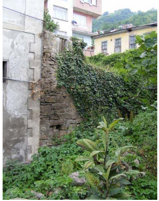
Resim 3.19. Sağ yan cephedeki toprak, çöp, moloz yığıntısı
