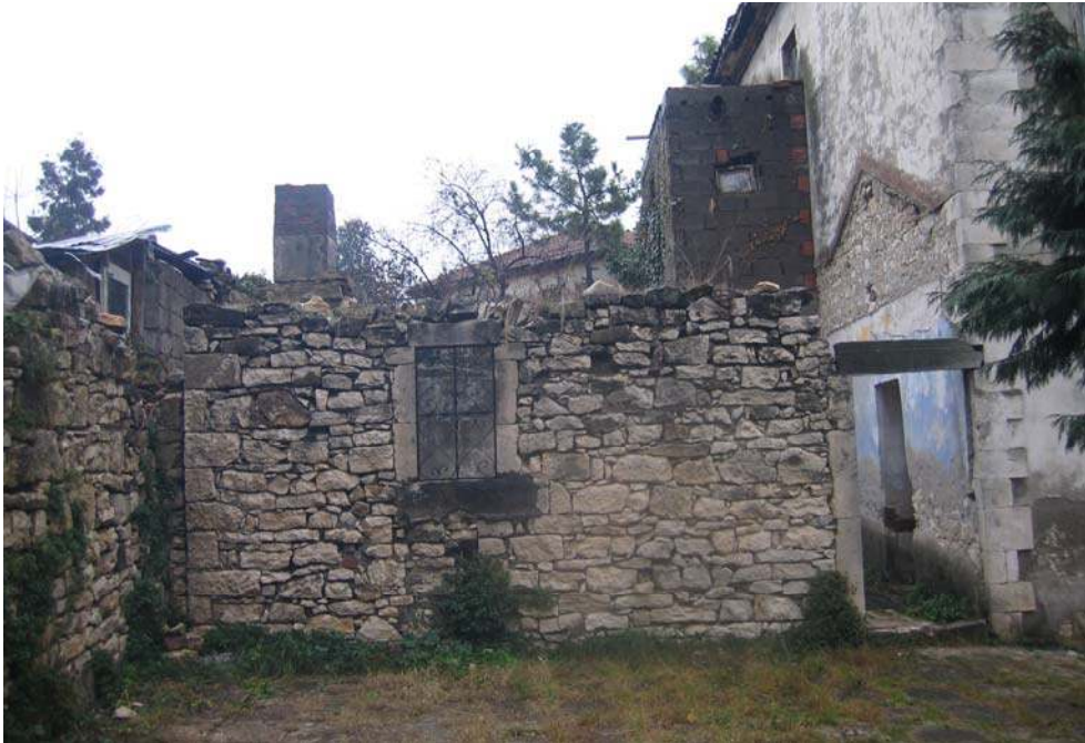
Resim 3.12. Furtun Evi'nin güneybatı cephesi yanındaki mutfak mekanı
