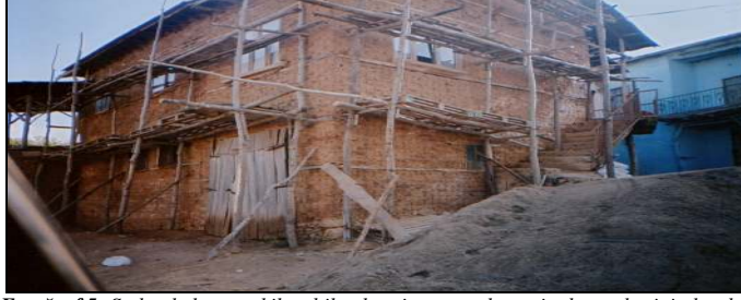
Fotoğraf 5: Sudan kolayca etkilenebilen kerpiçten yapılan evin dış cephesinin kardan yağmurdan korunması için evin dış cephesinin sıvanması işlemi için yapılan hazırlık (Günbağı Köyünden)
