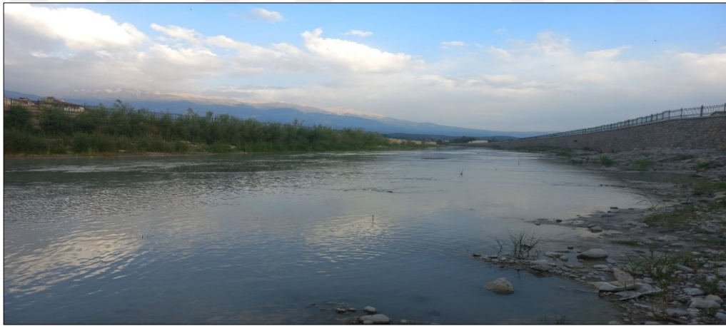
Şekil 4.6. Eşen Çayı genel görünüm.
