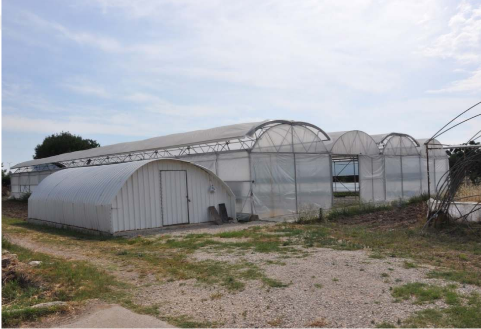
Şekil 3.1. Denemenin gerçekleştirildiği UV+IR+Antidrop katkılı plastik örtülü 840 m 2 alana sahip seranın görüntüsü
