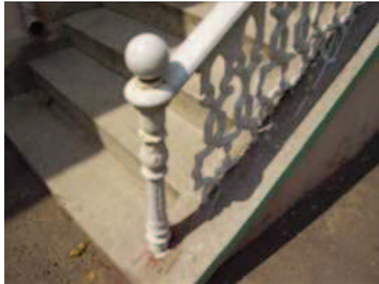
Fotoğraf 158: Kuzeybatı Kanadı İç Cephe**
