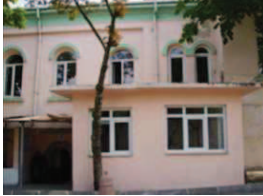
Fotoğraf 108: Kuzeybatı Kanadı Dış Cephe**
