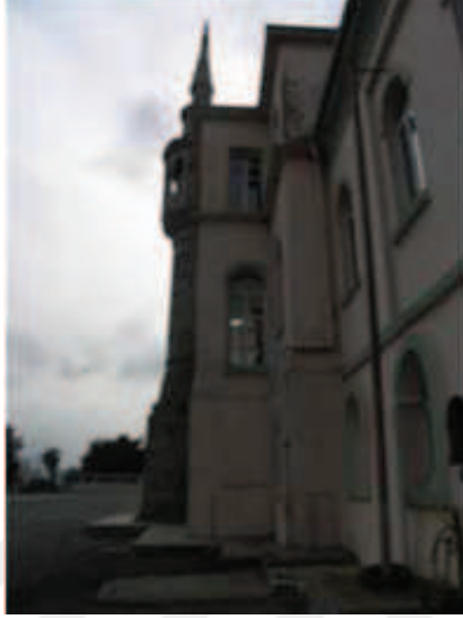
Fotoğraf 88: Kuzeydoğu Kanadı Dış Cephe**
