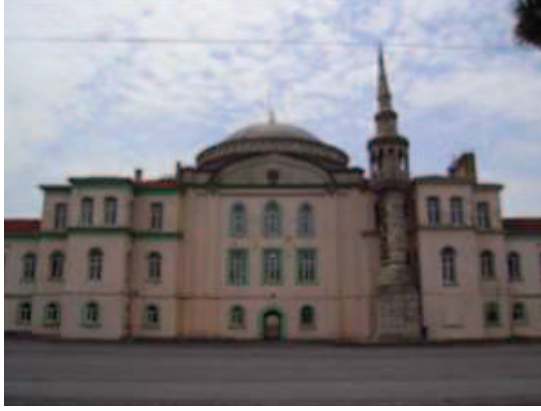
Fotoğraf 84: Kuzeydoğu Kanadı Dış Cephe**
