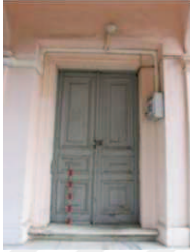
Fotoğraf 145: Kuzeydoğu Kanadı İç Cephe**
