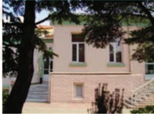
Fotoğraf 116: Güneydoğu Kanadı İç Cephe**
