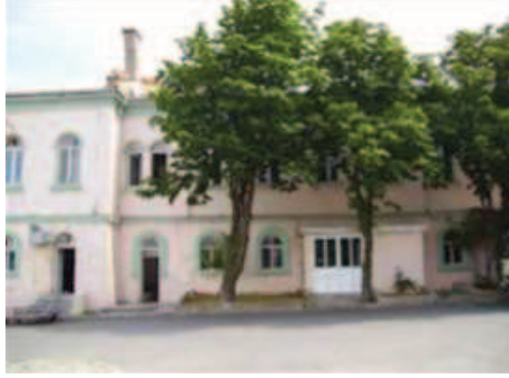
Fotoğraf 99: Kuzeybatı Kanadı Dış Cephe**
