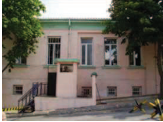
Fotoğraf 111: Kuzeybatı Kanadı Dış Cephe**
