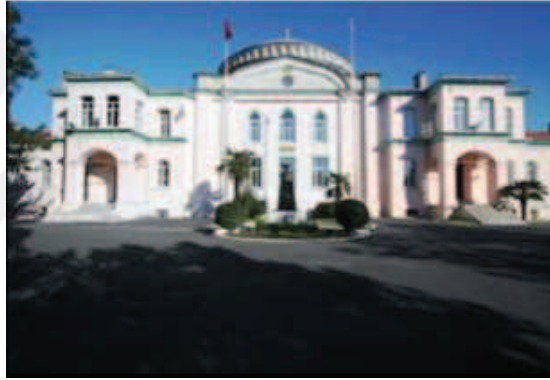
Fotoğraf 139: Kuzeydoğu Kanadı İç Cephe**
