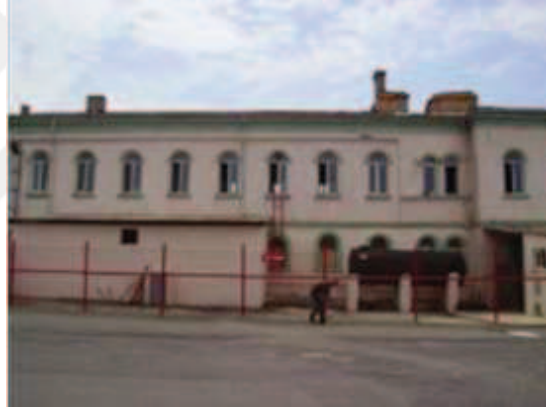
Fotoğraf 94: Kuzeydoğu Kanadı Dış Cephe**
