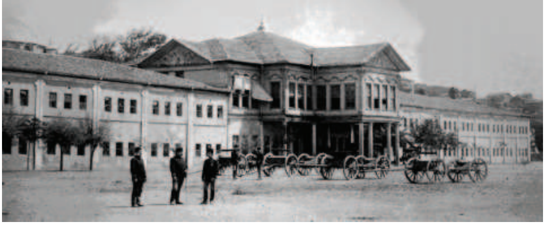
Fotoğraf 4: Humbaracılar Kışlası Ön Cephesi*
