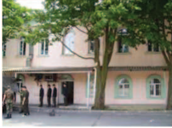
Fotoğraf 102: Kuzeybatı Kanadı Dış Cephe**
