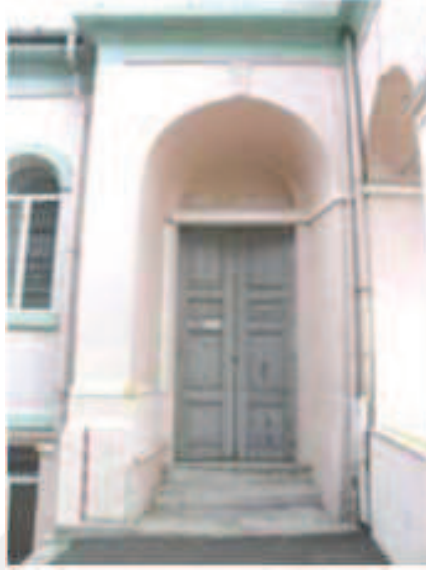
Fotoğraf 143: Kuzeydoğu Kanadı İç Cephe**
