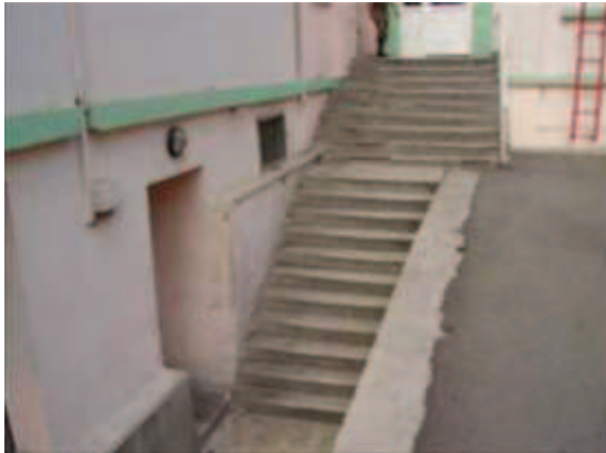
Fotoğraf 170: Kuzeybatı Kanadı İç Cephe**
