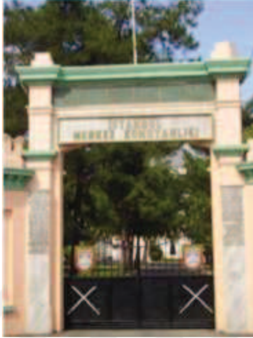
Fotoğraf 52: Ana Giriş Kapısı Yol Cephesi**
