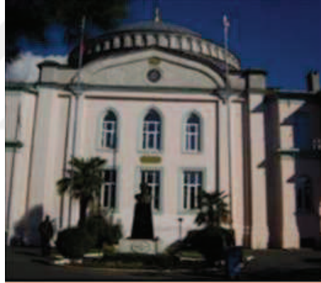
Fotoğraf 146: Kuzeydoğu Kanadı İç Cephe**
