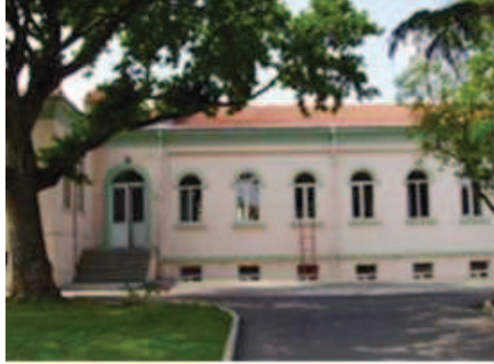
Fotoğraf 159: Kuzeybatı Kanadı İç Cephe**
