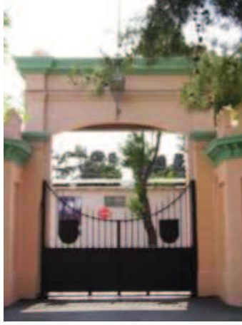
Fotoğraf 57: Ana Giriş Kapısı İç Cephe Görünümü**
