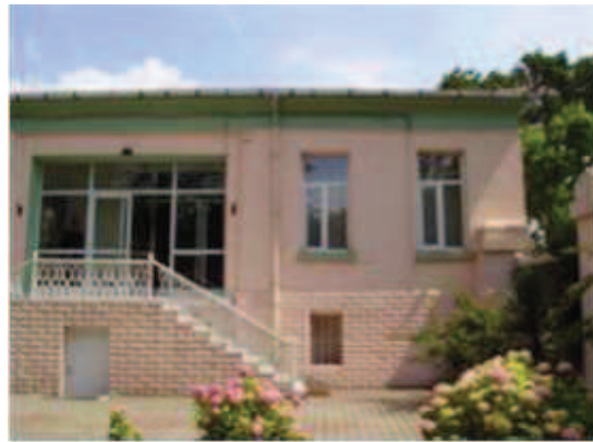
Fotoğraf 114: Güneydoğu Kanadı İç Cephe**
