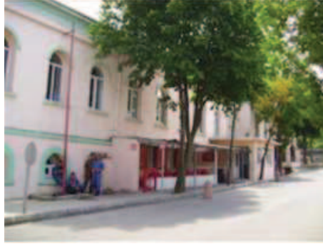
Fotoğraf 105: Kuzeybatı Kanadı Dış Cephe**
