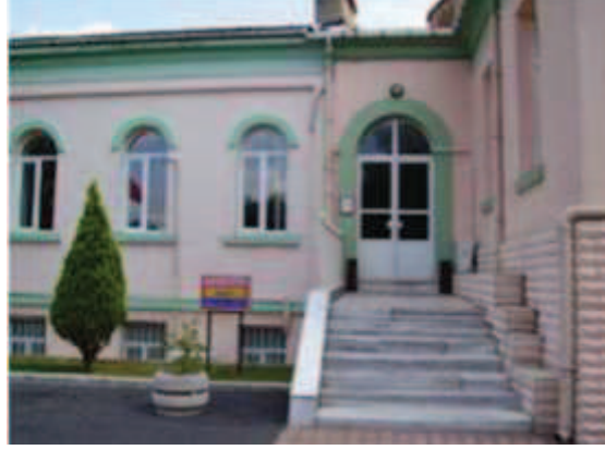
Fotoğraf 119: Güneydoğu Kanadı İç Cephe**
