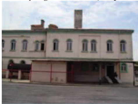
Fotoğraf 95: Kuzeydoğu Kanadı Dış Cephe**
