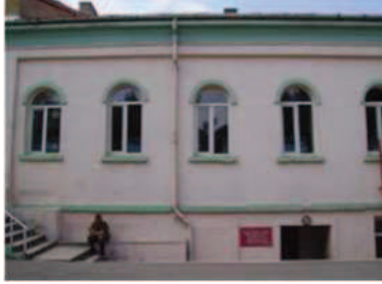
Fotoğraf 165: Kuzeybatı Kanadı İç Cephe**
