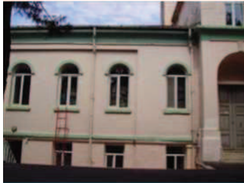
Fotoğraf 147: Kuzeydoğu Kanadı İç Cephe**
