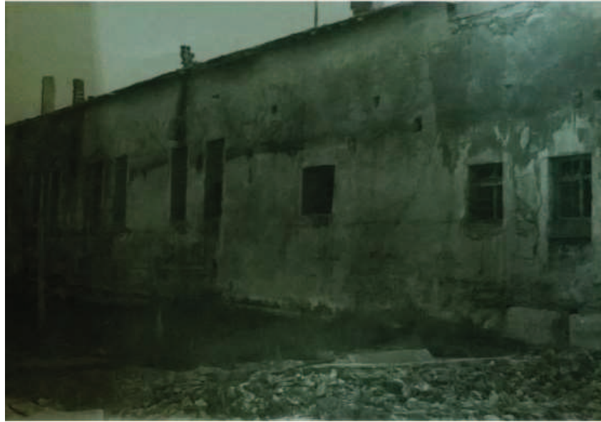
Rami Kışlası Cephesi*
