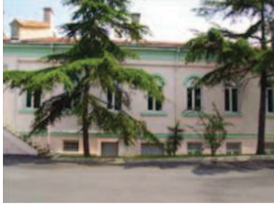
Fotoğraf 122: Güneydoğu Kanadı İç Cephe**
