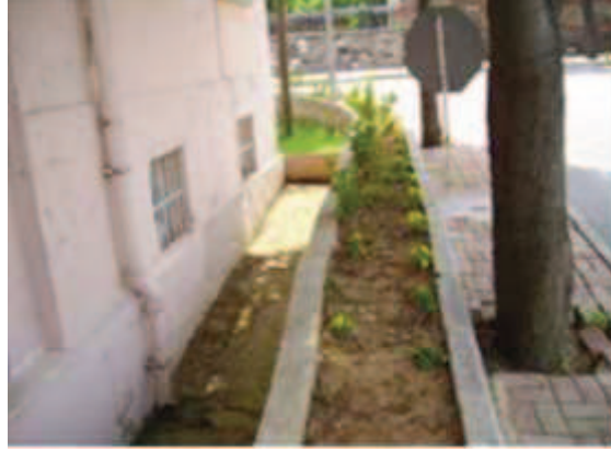
Fotoğraf 113: Kuzeybatı Kanadı Dış Cephe**
