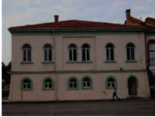
Fotoğraf 81: Kuzeydoğu Kanadı Dış Cephe**
