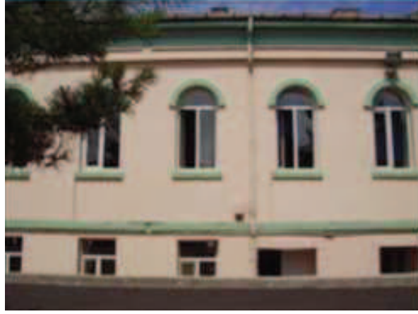
Fotoğraf 136: Kuzeydoğu Kanadı İç Cephe**
