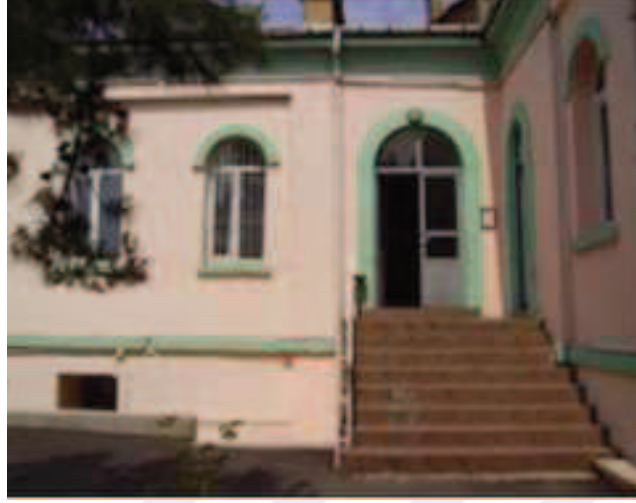
Fotoğraf 133: Kuzeydoğu Kanadı İç Cephe**
