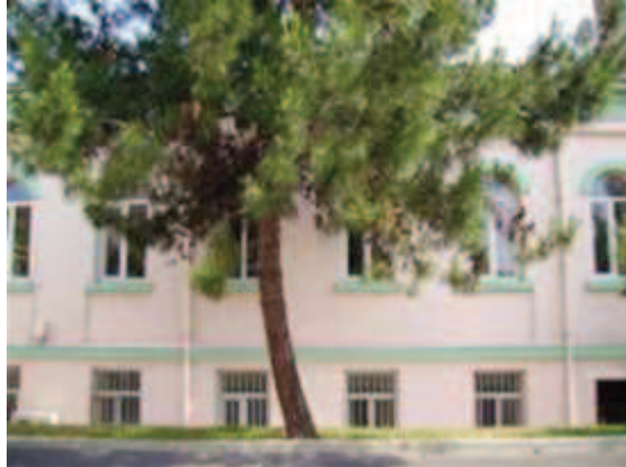
Fotoğraf 129: Güneydoğu Kanadı İç Cephe**
