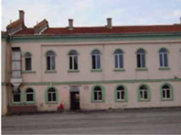
Fotoğraf 89: Kuzeydoğu Kanadı Dış Cephe**
