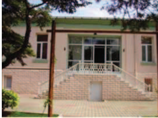
Fotoğraf 115: Güneydoğu Kanadı İç Cephe**
