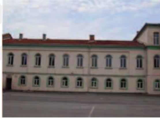
Fotoğraf 91: Kuzeydoğu Kanadı Dış Cephe**
