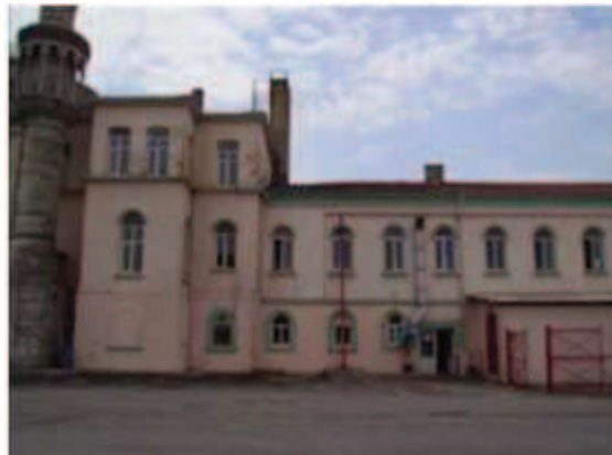
Fotoğraf 92: Kuzeydoğu Kanadı Dış Cephe**
