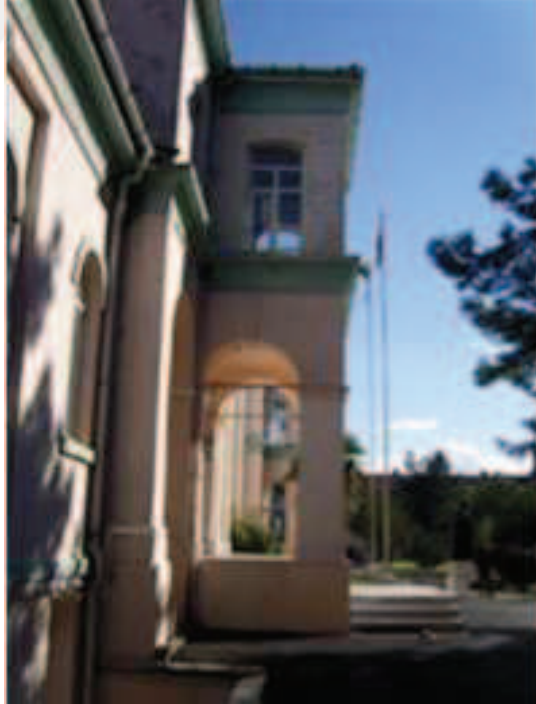
Fotoğraf 144: Kuzeydoğu Kanadı İç Cephe**
