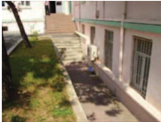
Fotoğraf 126: Güneydoğu Kanadı İç Cephe**
