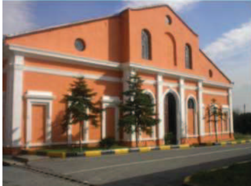
Demirkapı Kışlası Ek Yapı*
