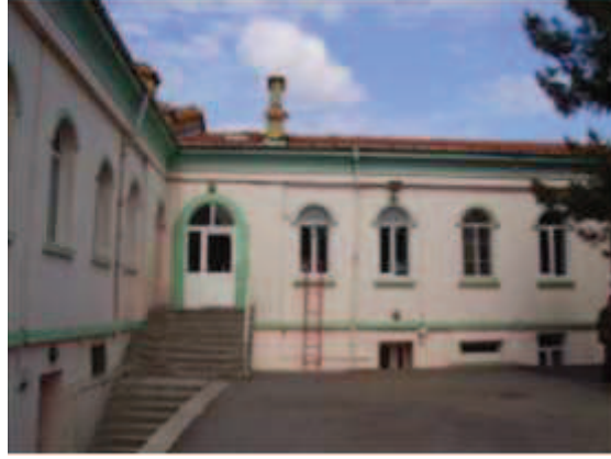
Fotoğraf 152: Kuzeydoğu Kanadı İç Cephe**
