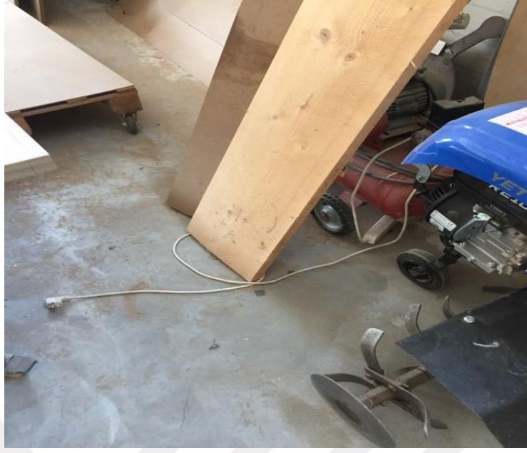
Şekil 49. Elektrik fiş ve kabloları
