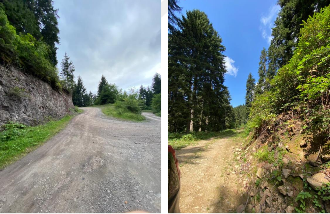
Şekil 11. Arazi çalışmaları orman yol kurp örneği ve hendek ile kazı şevi
