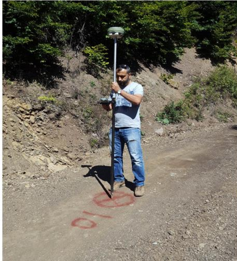
Şekil 2.5. YKN'nin alana işaretlenmesi ve Cors-GPS ile koordinatlarının alınması.
