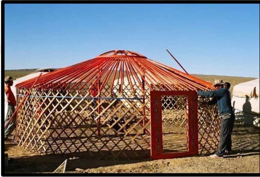
Görsel 2.5. Taşınması ve kurulması kolay olan çadırın kurulumu
