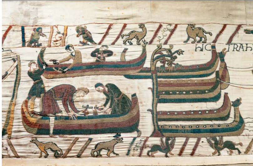
Şekil 31: Bayeux Duvar Halısındaki Viking Gemi Yapımı
