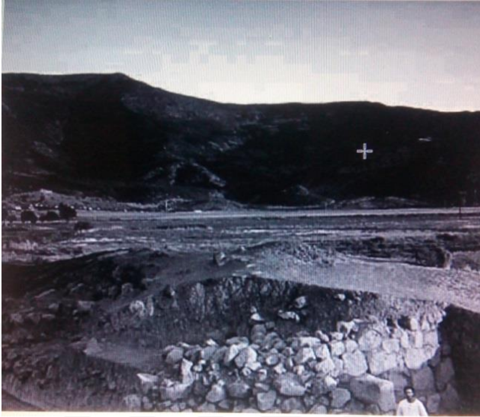
Resim 21: Zincirli Höyük, modern sulama kanalının şehrin güneydoğusundaki sur duvarını tahribi (Schloen ve Fink, 2008:111).
