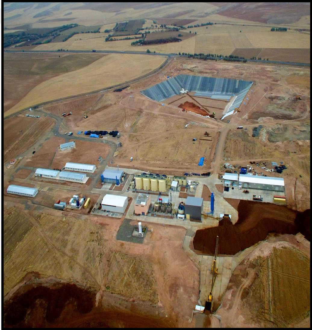
Şekil 2.2. Gümüştaş A.Ş. Niğde Tepeköy altın gümüş zenginleştirme tesisi, inceleme alanında üretilen tüvenan cevher kamyonlarla buraya taşınmaktadır.
