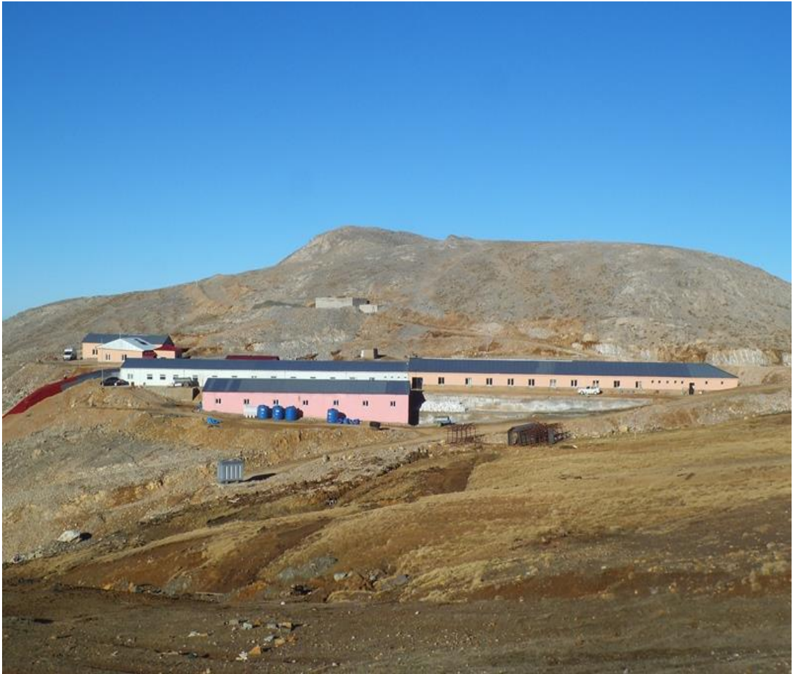
Şekil 1.4. Bolkardağları'nda maden işletmesine ait şantiye binasına güneyden bakış (İşletmede çalışan personel yatılı olarak bu binalarda barınmaktadır).
