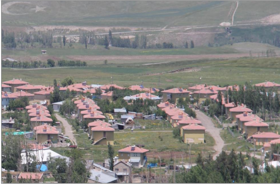
Fotoğraf 2.12. Deprem konutları, Ortabahçe'ye planlı bir yerleşme görünümü kazandırmıştır.
