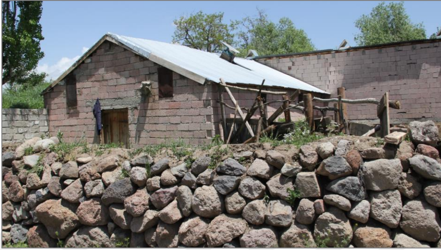
Fotoğraf 2.20. Ortabahçe’de briket malzemeli, eğimli çatıya sahip yeni tip konut örneği.
