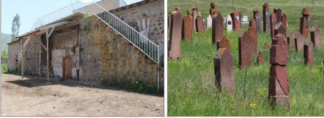
Fotoğraf 2.13. Kesme taş, sahadaki geleneksel yapı unsurlarındadır.
