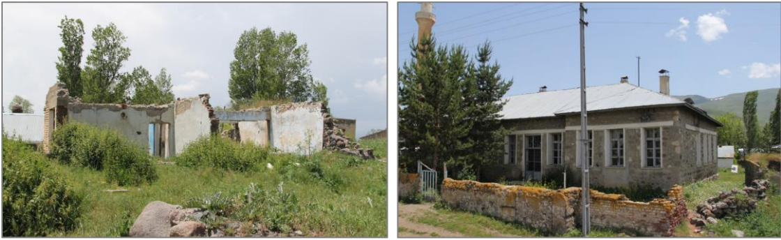
Fotoğraf 1.3. Ortabahçe Köyü’nde 2004 depreminde zarar gören binalardan görünümeler.
