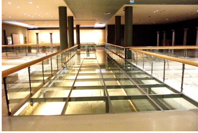
Şekil 97: Şeffaf Gezi Yolu Platformu ve Koruyucu Trabzanlar (URL-74, 2022).
