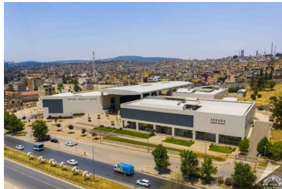
Şekil 80: Zeugma Mozaik Müze Binası (URL-56, 2022).
