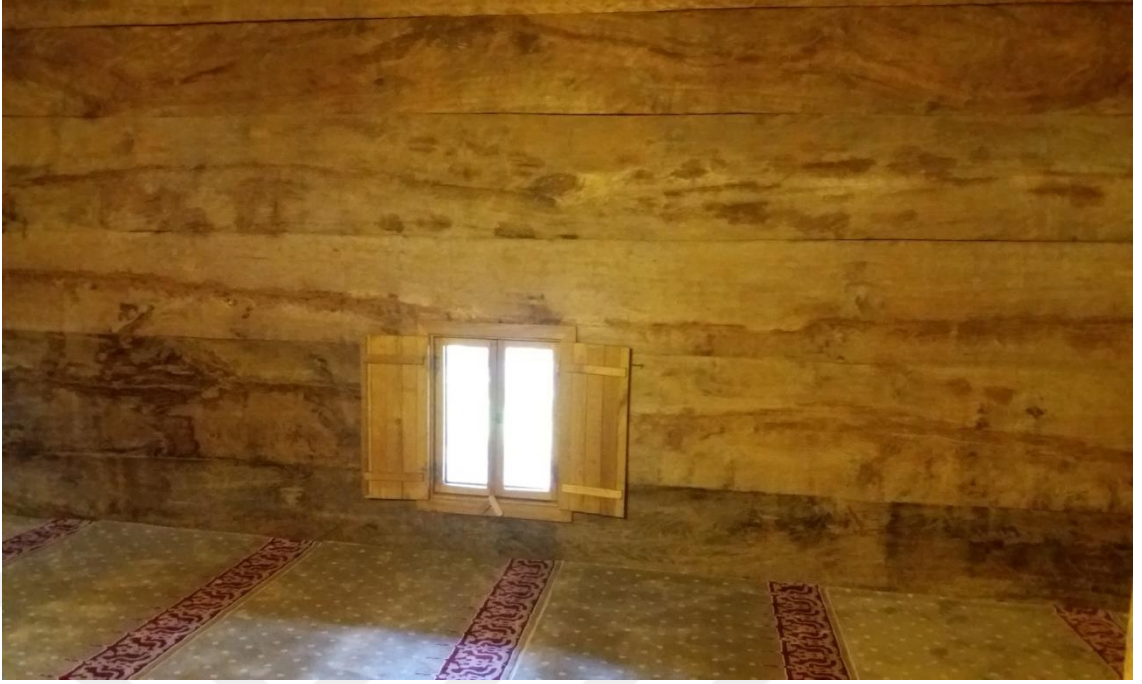
Foto.8.Ahşap yığma tekniği duvarlar
