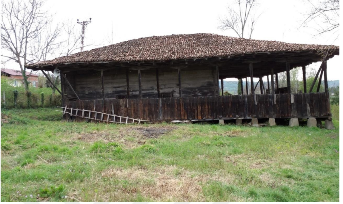
Foto. 44. Ordu Köyü Camii doğu cephesinden görünüm
