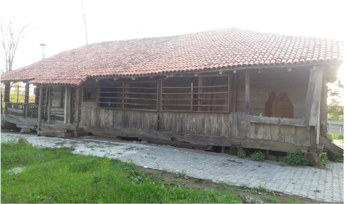
Foto. 32.Şeyh Habil Camii kırma çatısının kuzey doğu kesiminden bir görünüm
