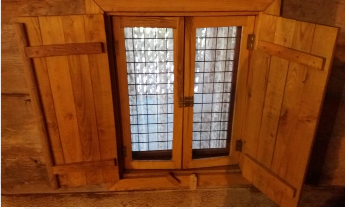
Foto. 10. Ahşap pencere ve demir korkuluklar
