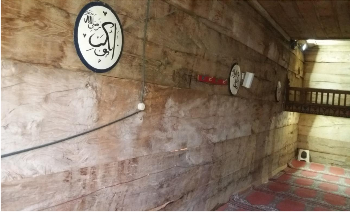
Foto. 34. Şeyh Habil Camii yığma duvarlar
