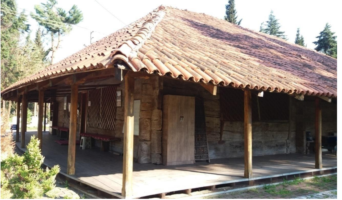
Foto. 13. Ahşap kırma çatı
