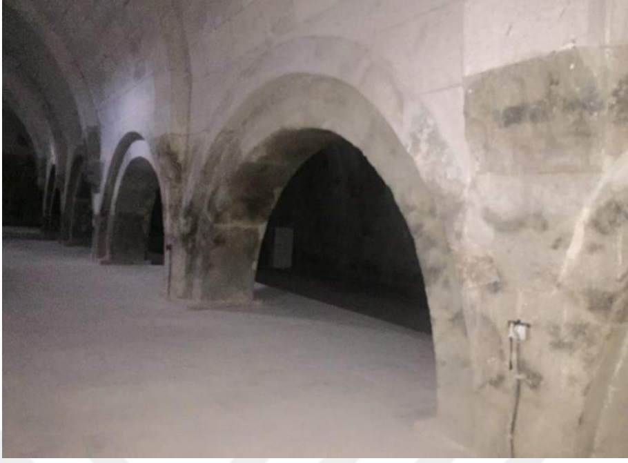
Foto 11. Iğdır Kervansarayı Kuzey Neften Görünüm.
