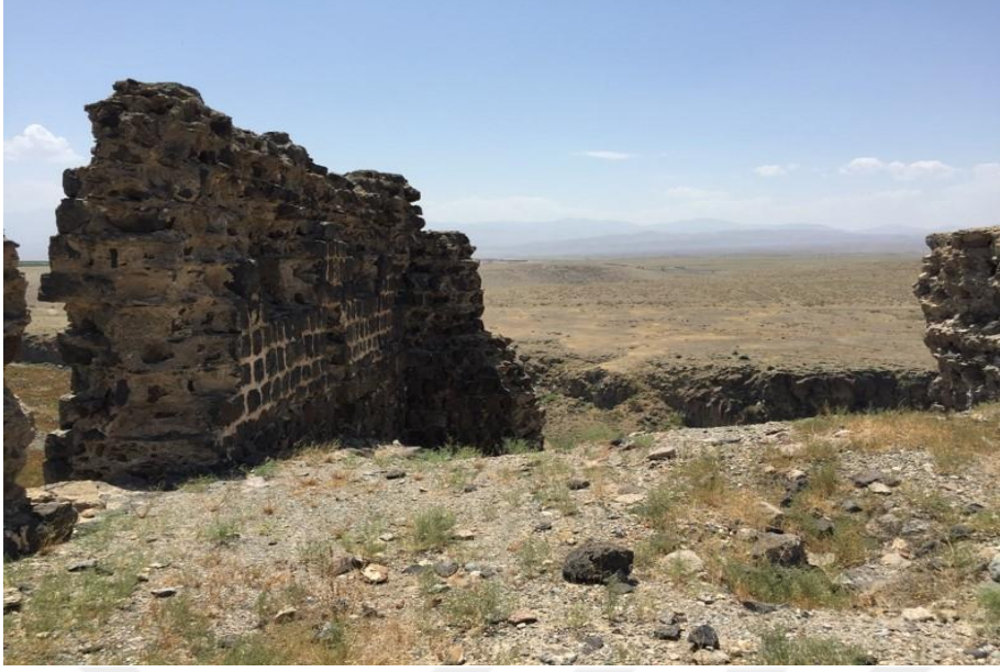
Foto 47. Karakale (Sürmeli Kalesi) Güney İç Duvar Kalıntısı.
