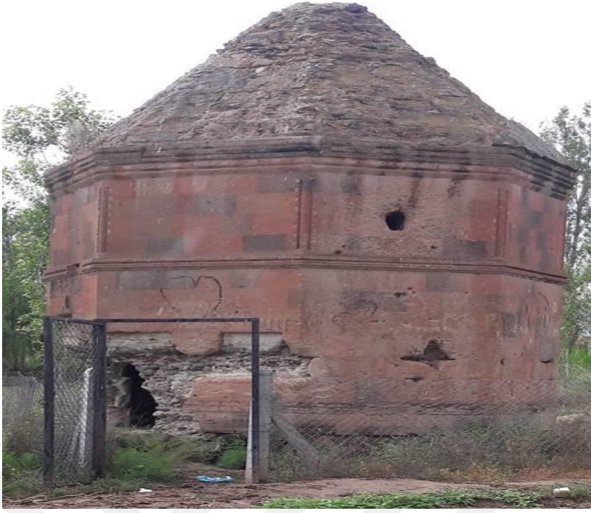
Foto 21. Iğdır Kul Yusuf Kümbeti Güneydoğudan Görünüm.
