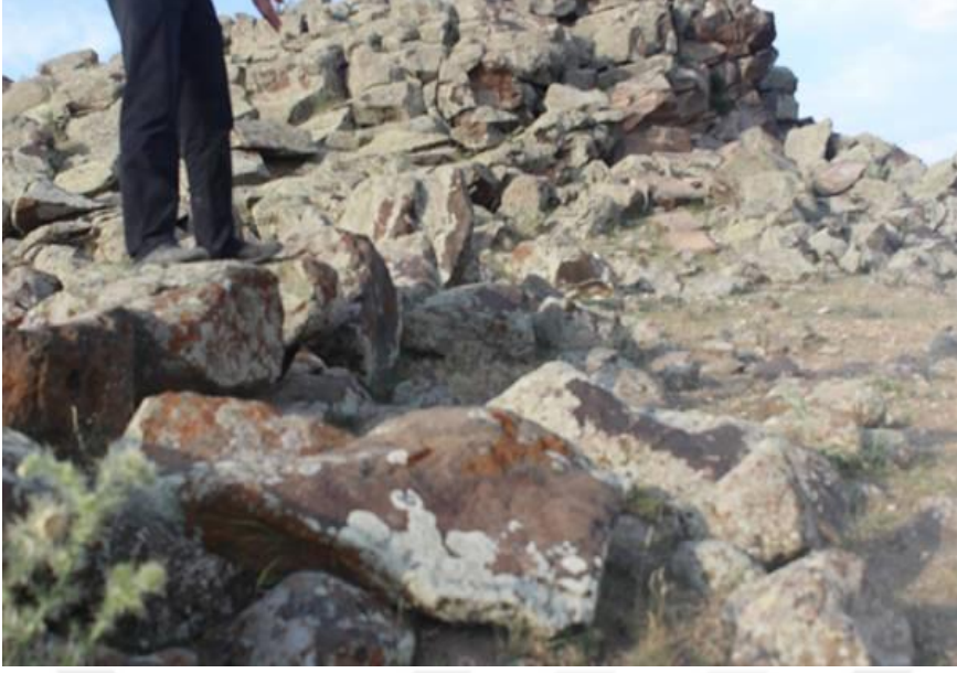
Foto 75. Katırlı Kalesinin Batı Sur Temelleri.
