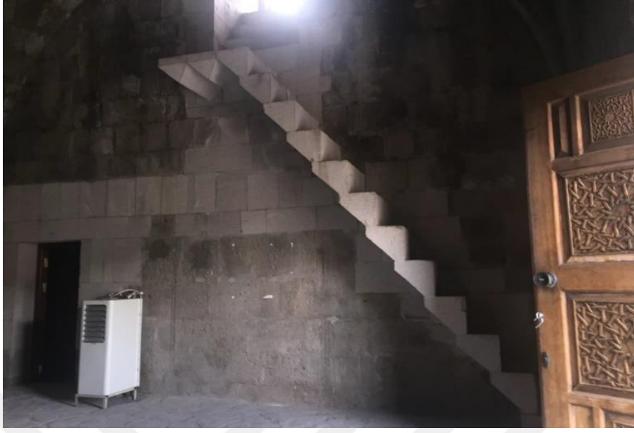
Foto 7. İğdır Kervansarayının Taş Merdivenle Çatıya Çıkışı.
