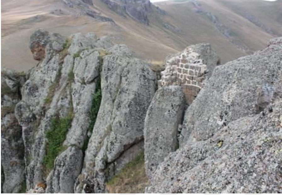
Foto 105. Güngörmez Kalesinin Güneybatı Duvar Kalıntısı.
