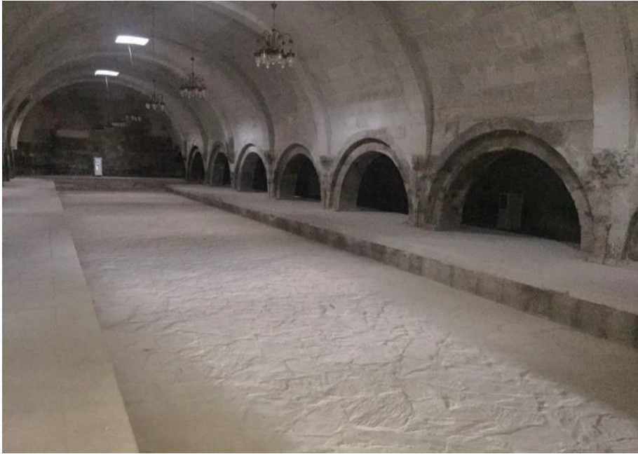
Foto 12. Iğdır Kervansarayı Güney Neften Görünüm.
