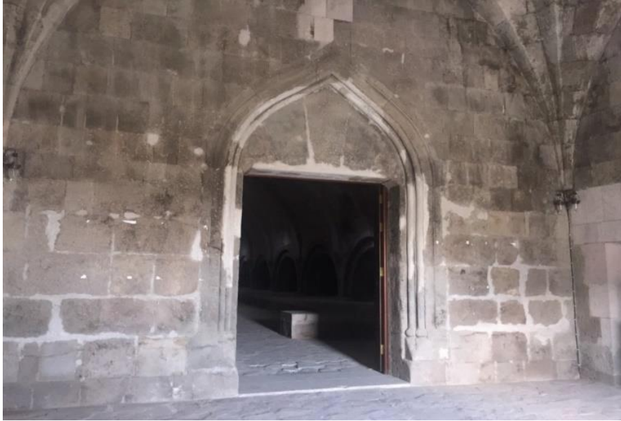
Foto 8. İğdır Kervansarayı Ahır Kapısından Görünüm.
