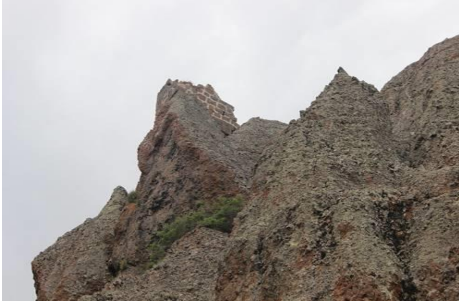
Foto 102. G ng rmez Kalesinin Duvar Kalıntısı.
