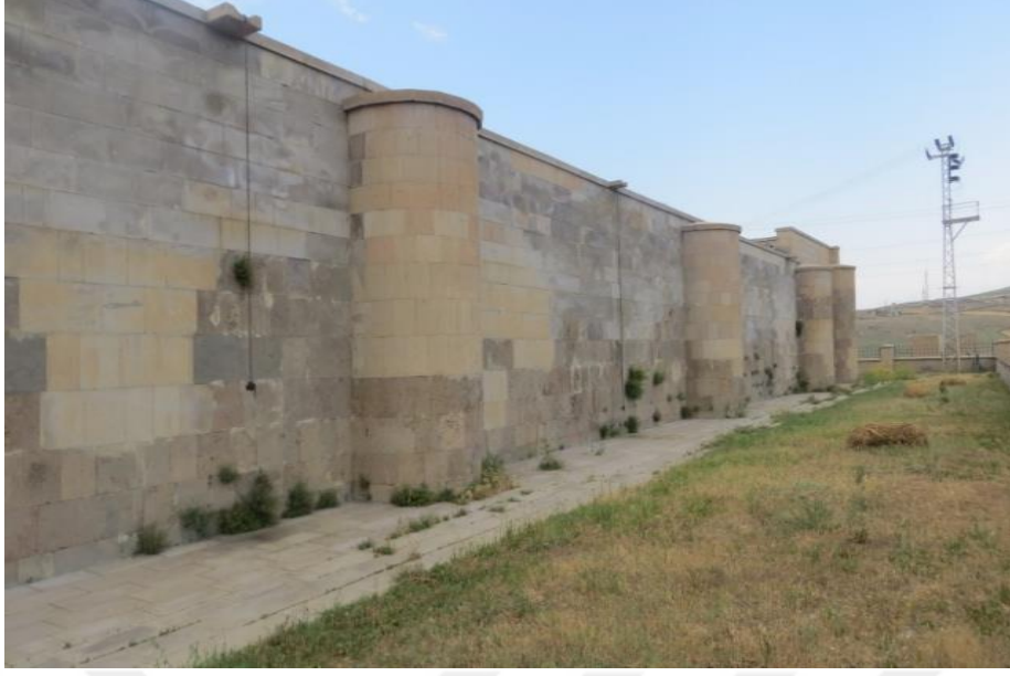
Foto 3. Iğdır Kervansarayı Destek Kulelerinden Doğu Cephesinden Görünüm.
