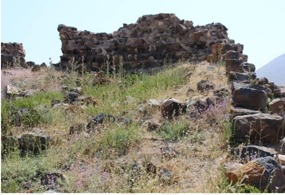
Foto 89. Kervansaray K y  Kalesinin İ yapı Duvarların Genel G r n m.
