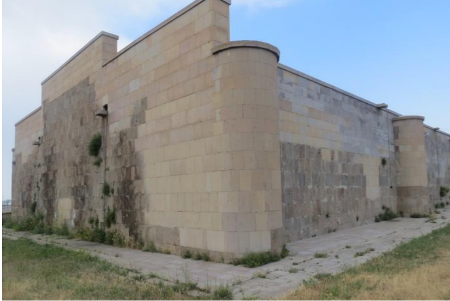
Foto 2. Iğdır Kervansarayı Doğu Cephesinden Görünüm.
