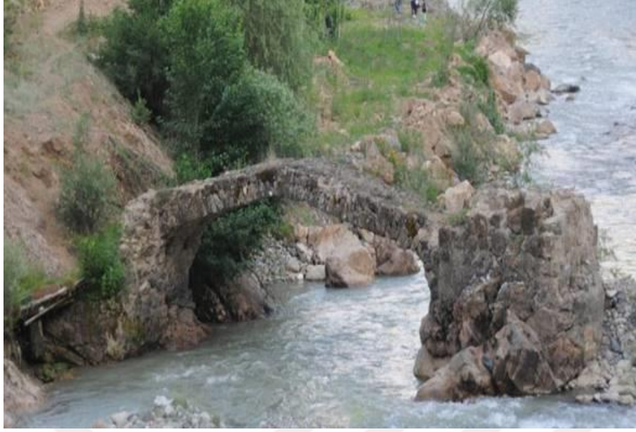
Foto 39. Meydancık Taş Kemer Köprüsünden Genel Bir Görünüm.
