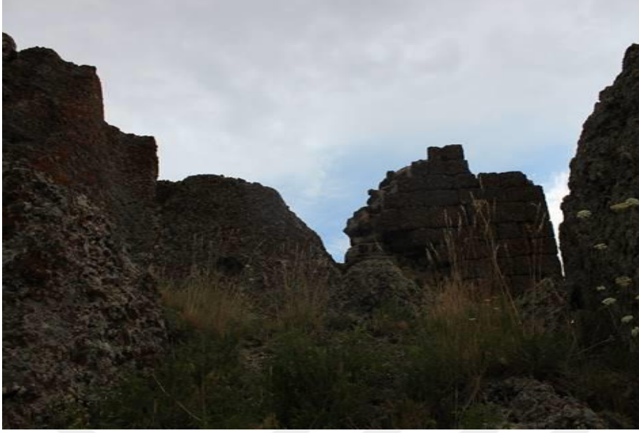
Foto 107. Güngörmez Kalesinin İç Duvar Kalıntısı.
