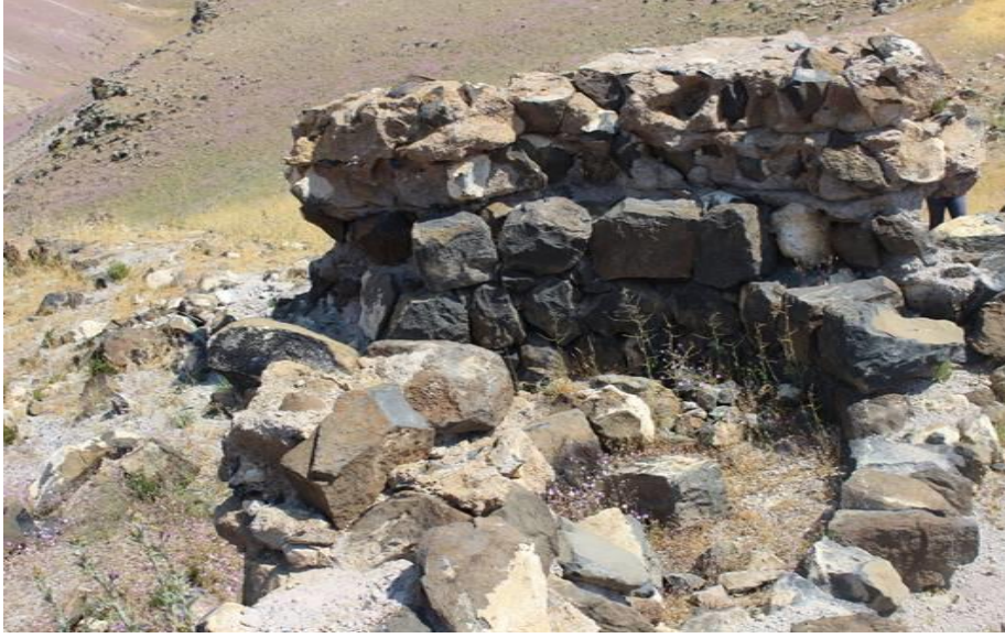
Foto 90. Kervansaray K y  Kalesinin İ  Yapı Sur Duvarları DoĒu batıdan G r n m.
