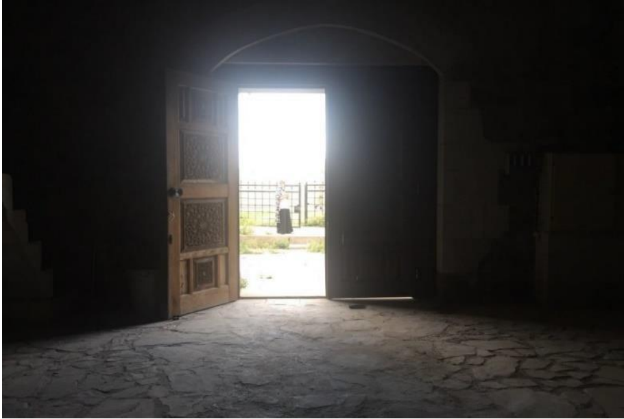
Foto 6. Iğdır Kervansarayı Giriş Holü.
