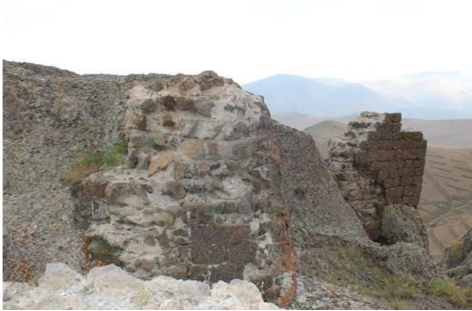
Foto 112. Güngörmez Kalesinin Yıkık Duvar Kalıntısı.
