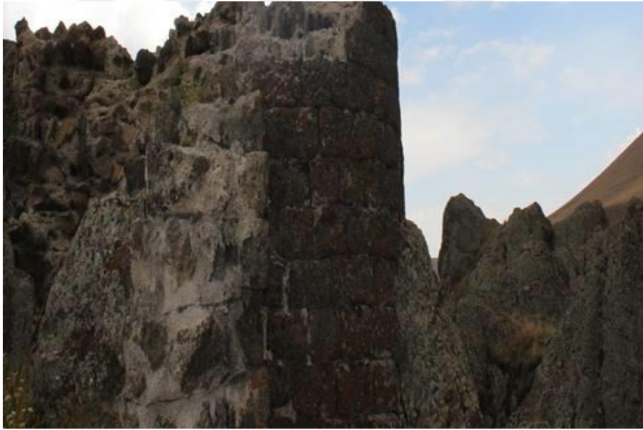
Foto 110. Güngörmez Kalesinin Güneybatı Burç Sur Duvar Kalıntısı.
