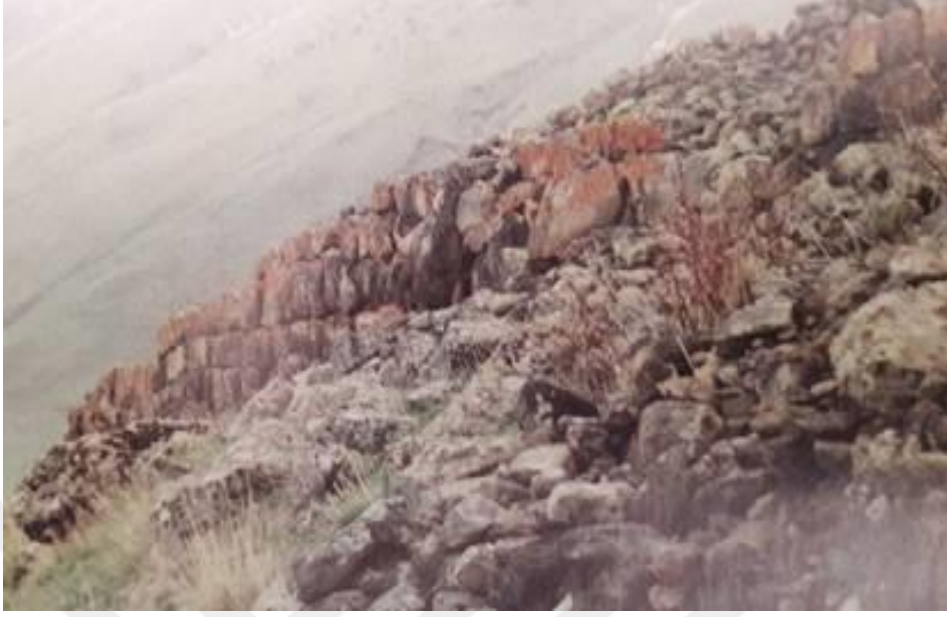
Foto 153. Iğdır Kalesi (korugan Kalesi) Kuzeydoğu Sur Duvarları (H. Buyruk'tan).
