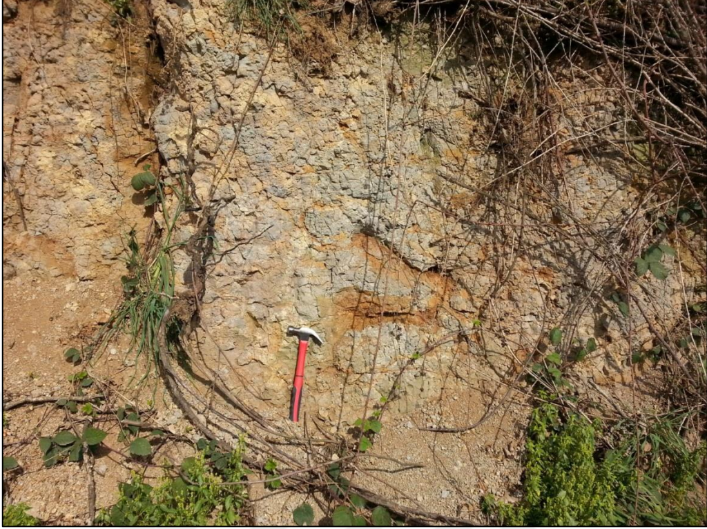
Şekil 16. Tüflerin inceleme alanındaki görünümü
