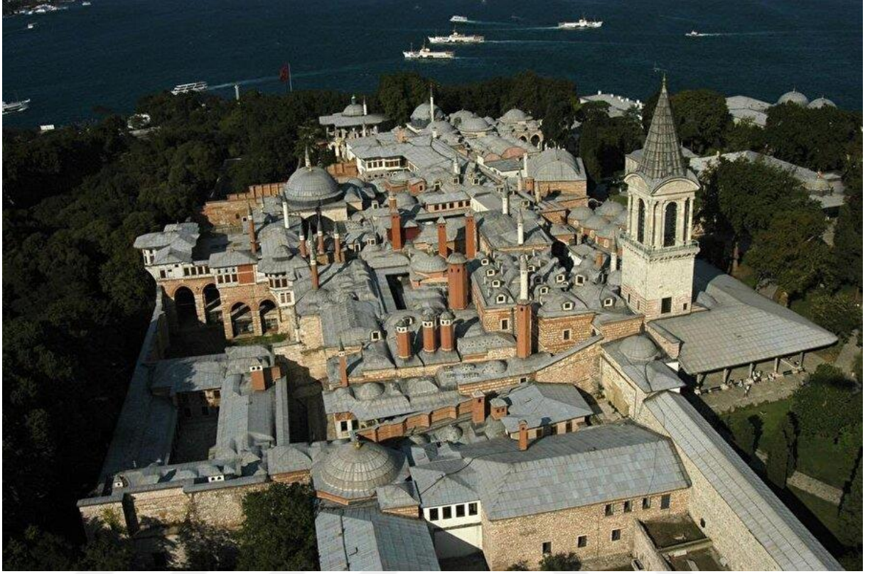
Resim 3.5. Topkapı Sarayı, Harem Dairesi Tepeden Görünüş
