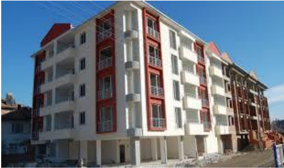
Foto 17: Gemici Mahallesinde Yapımı Süren Modern Binalar.
