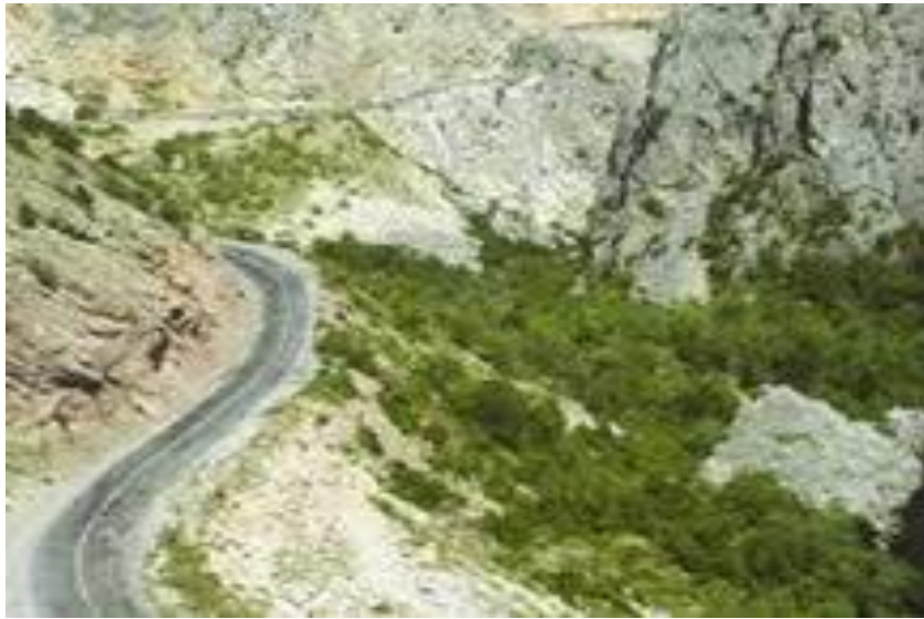
Foto 44: E-80 Karayolunun Yenilenmeden Önceki Görünümü
