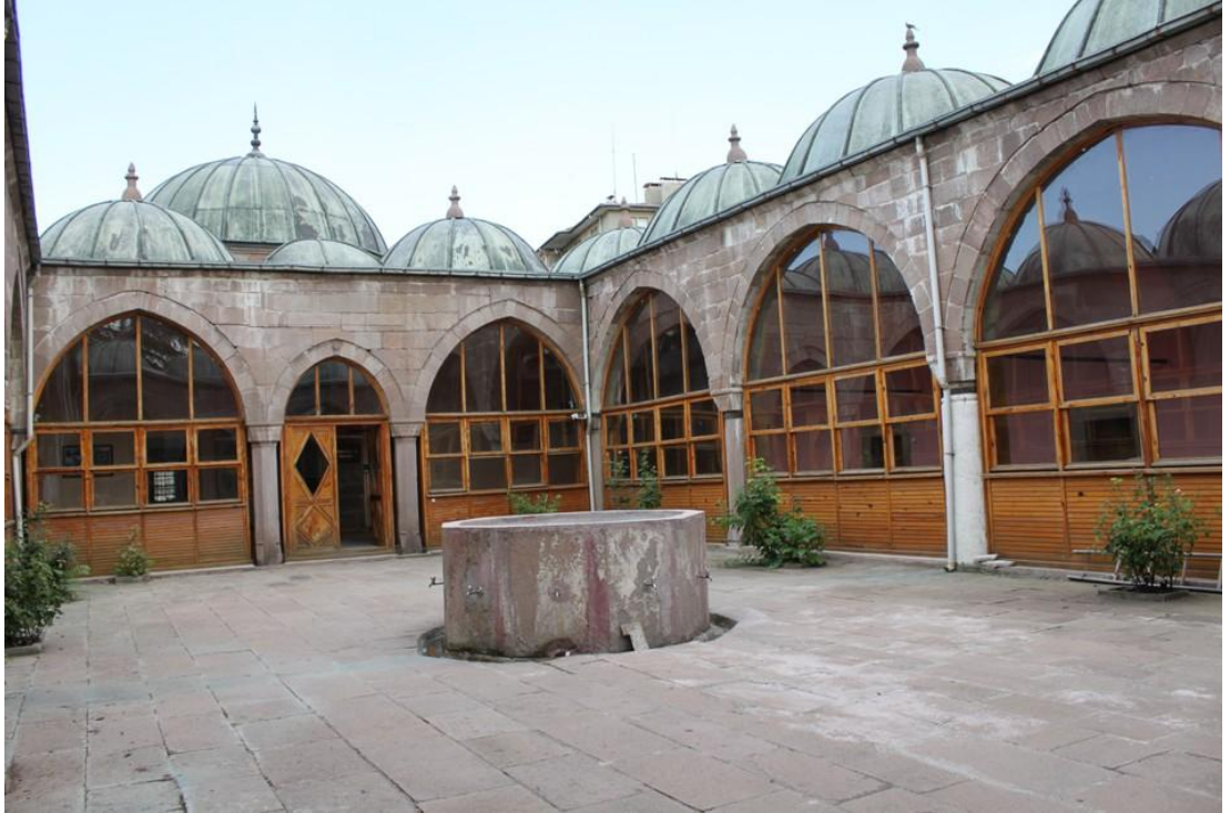
Resim 40: Vezirköprü, Fâzıl Ahmet Paşa Medresesi İçinden Bir Görünüş (2010)
