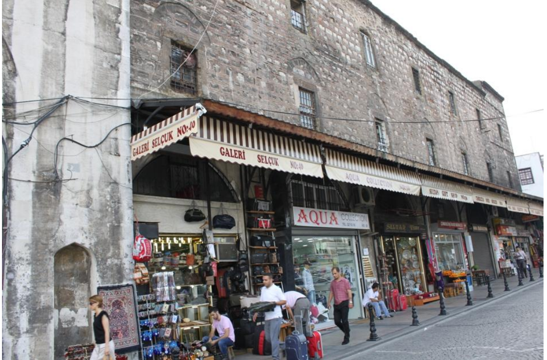
Resim 8: İstanbul, Köprülü Mehmet Paşa Hanı (Vezirhan) Giriş Cephesi (2010)
