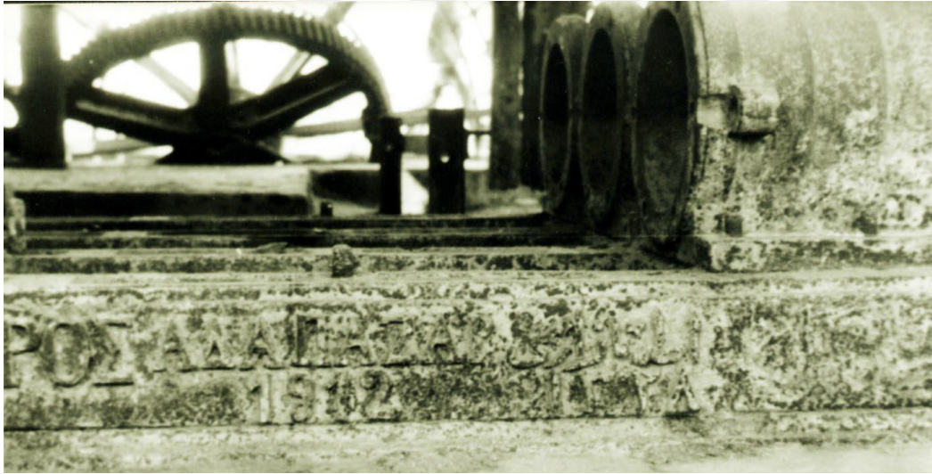
Resim 17- Muhtemelen bir Rum mühendis tarafından tasarlanan Çark suyu pompa sistemi üzerindeki yazı (.. ROS ADAPAZARI 1912 ve 1328).
