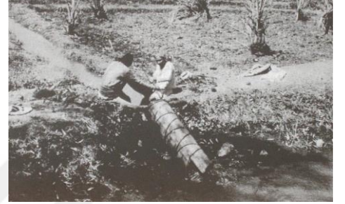
Resim 3- Arşimet tarafından geliştirildiği varsayılan Arşimet burgusu ve uygulama şekli
