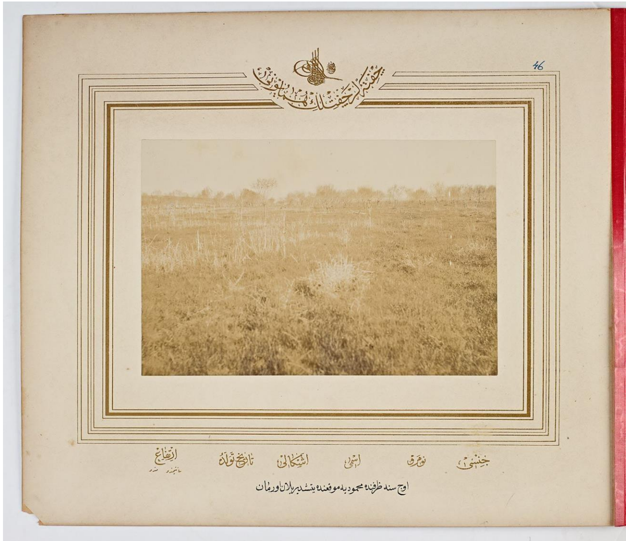
Ek-1: Üç sene zarfında Mahmudiye mevkiinden yetiştirilen orman. (Bugünkü Eskişehir ili sınırlarında)
