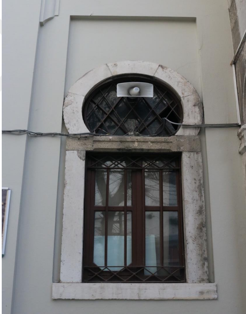
Şekil 5.98. Keçecizade Fuat Paşa Camii pencere form örneği-1
