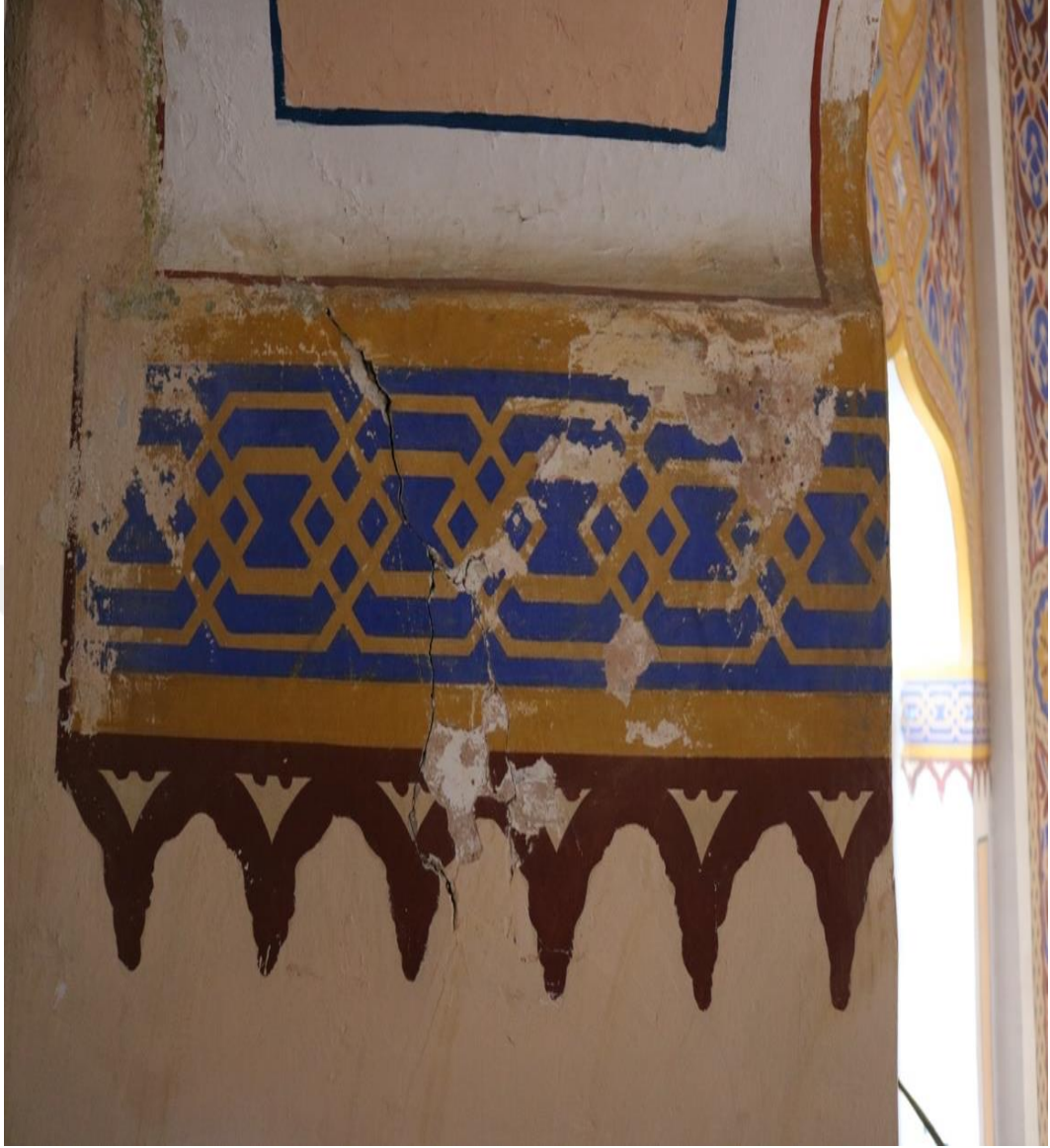
Şekil 5.80. Keçecizade Fuat Paşa Camii hünkâr mahfili gösterimi-2
