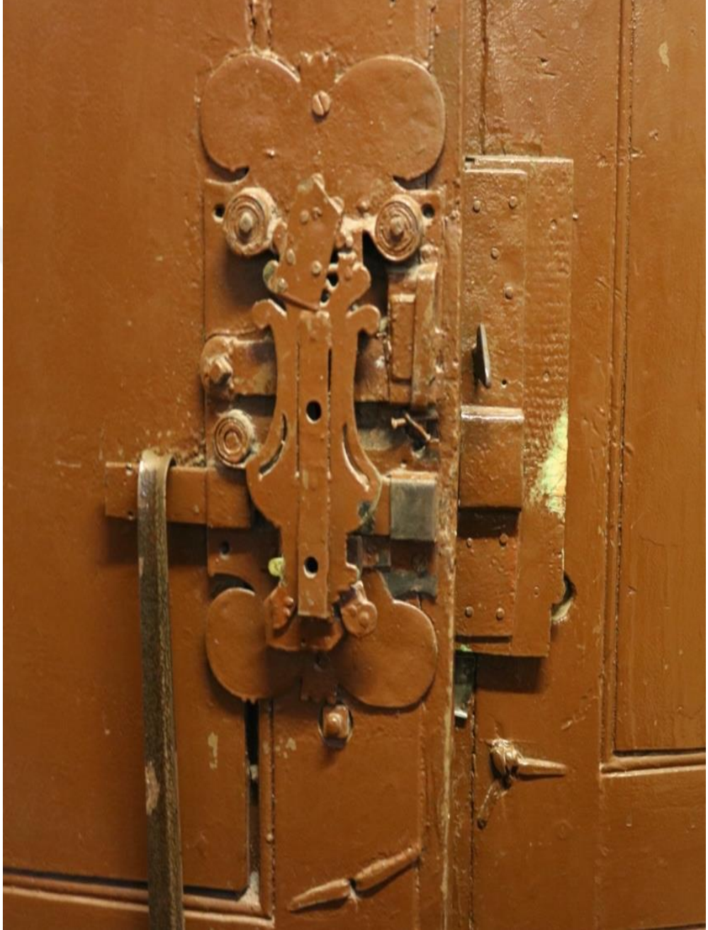
Şekil 5.101. Keçecizade Fuat Paşa Camii kapı kilidi örneği-1
