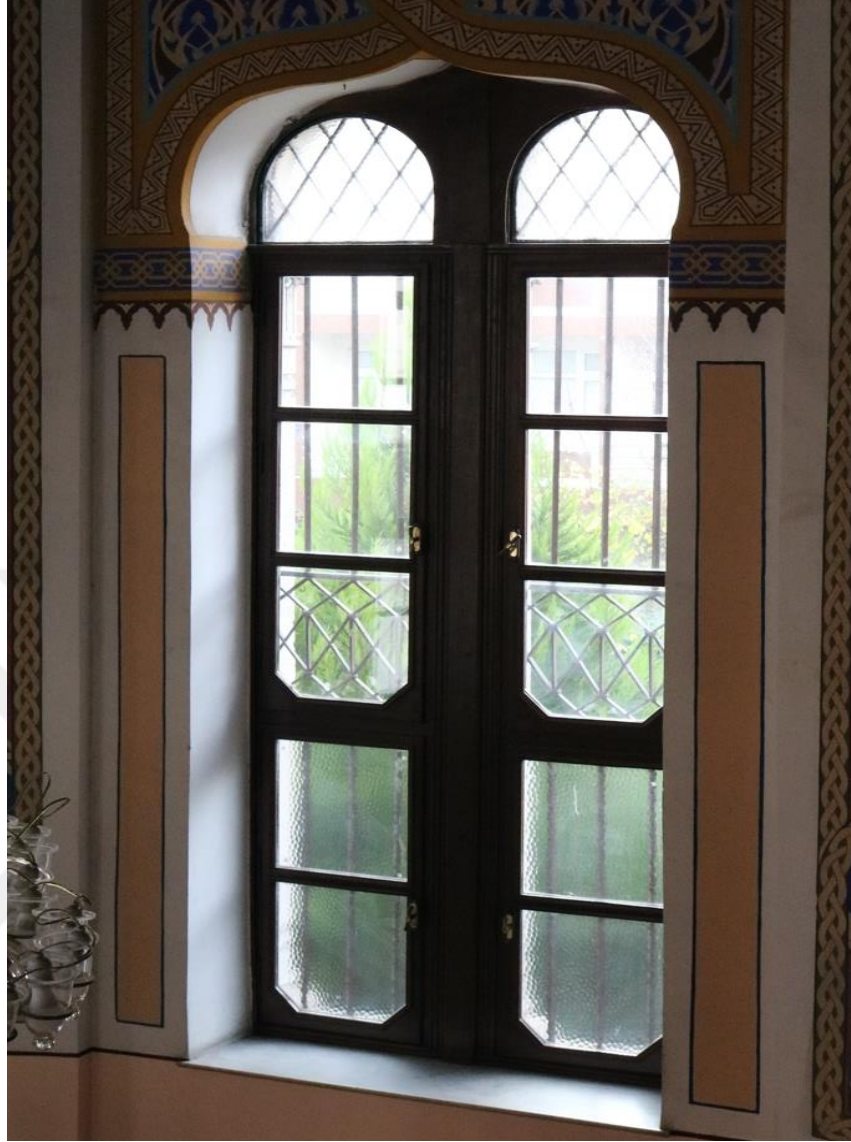
Şekil 5.99. Keçecizade Fuat Paşa Camii pencere form örneği-2
