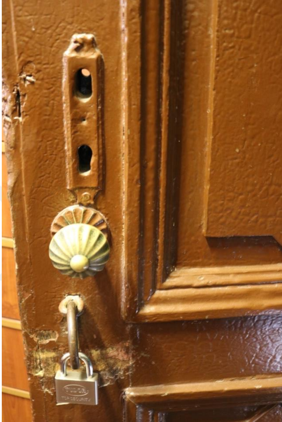
Şekil 5.102. Keçecizade Fuat Paşa Camii kapı kilidi örneği-2
