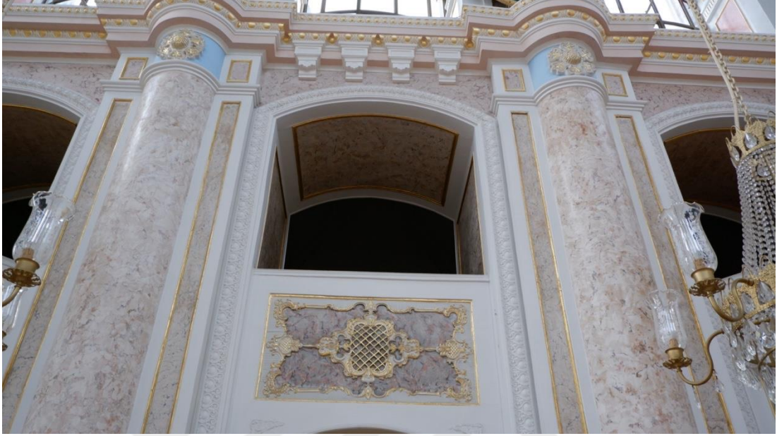
Şekil 5.61. Ortaköy Camii hünkâr mahfili örneği-1
