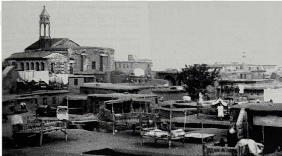
Şekil 2.38. Mar Kozma Kilisesi, çan kulesi ve çatısı (Tuncer, 2002)
