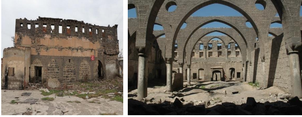
Şekil 2.32. Surp Sargis Kilisesine ait restorasyon öncesi görseller, https://www.tigrishaber.com/diyarbakirda-500-yillik-ermen-kilisesine-restorasyon
